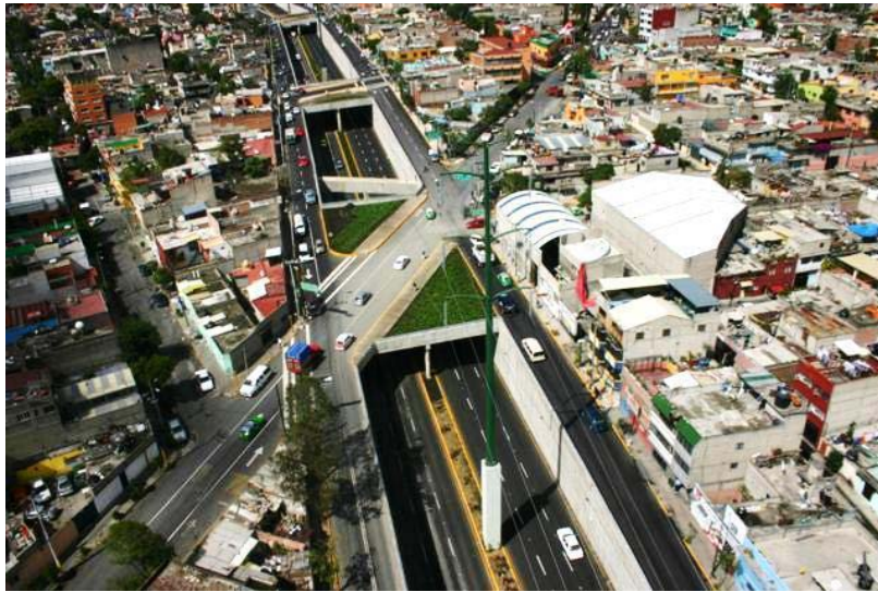
Foto. 3.1.7: Periodo de construcción: 28 junio 2004 – 27 diciembre 2004
