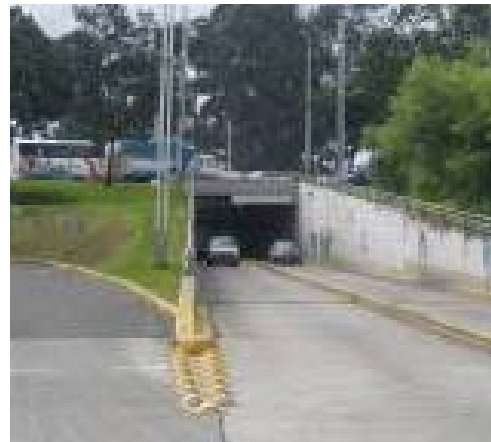
Gráfico y Foto 4.1.2.1: Paso deprimido, pórtico de hormigón armado con losa prefabricada
