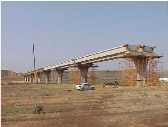
Fotos. 3.6.6.2: Dos tableros dobles prefabricados con continuidad hiperestática y pieza de cantiléver sobre pila
