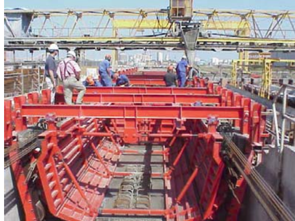
Fotos. 3.6.4.1: Encofrados metálicos para fabricación de vigas de puentes de hormigón armado
