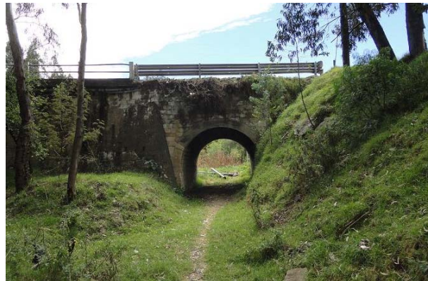
Foto 4.1.3.1: Paso deprimido para línea ferrea en la ciudad de Azogues
