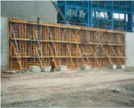
Fotos. 3.6.3.2: Encofrado metálico para muros de hormigón armado
