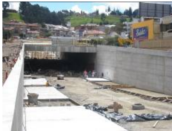
Foto 4.1.2.2: Intercambiador, pórtico de hormigón armado con vigas prefabricadas
