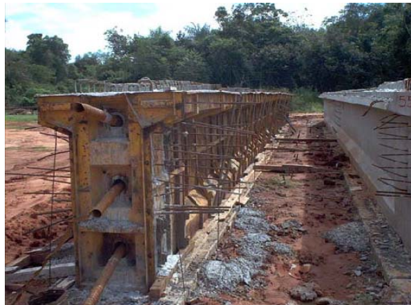
Fotos. 3.6.3.1: Encofrado metálico para vigas prefabricadas de hormigón armado
