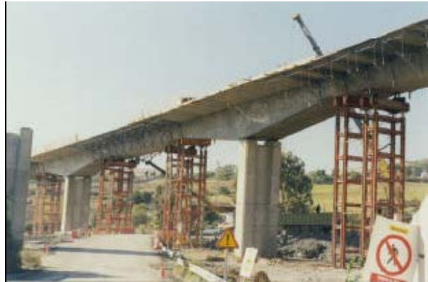
Fotos. 3.6.6.1: Instalación de unidades auxiliares para sostenimiento de elementos prefabricadas
