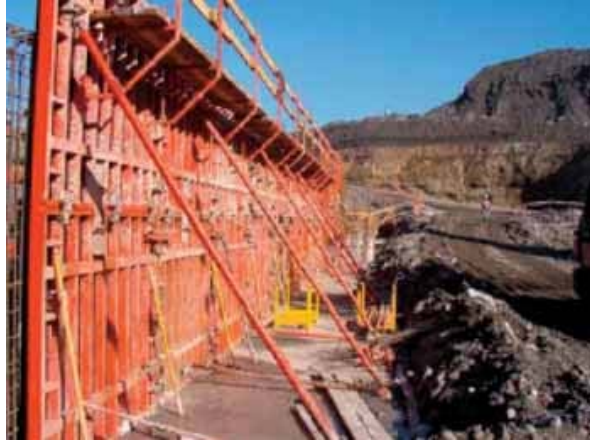
Fotos. 3.6.3.2: Encofrado metálico para muros de hormigón armado
