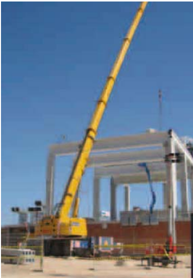
Fotos. 3.4.3: Grúas de izaje para ensamblaje de prefabricados
