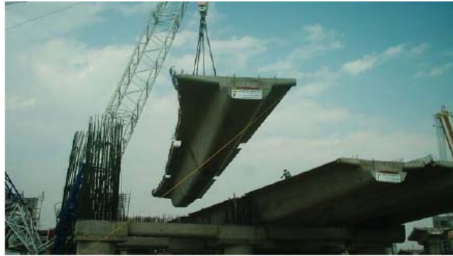
Fotos. 3.4.1: Ensamblaje de estructuras prefabricadas
