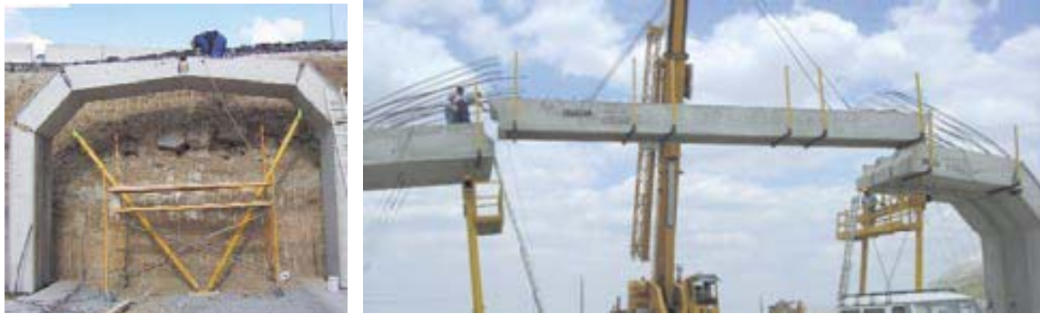
Fotos. 3.1.8: Montaje de estructuras prefabricadas para una y dos vías
