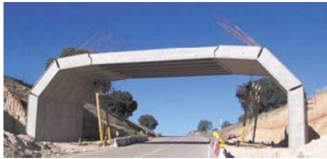
Foto. 3.1.9: Estructuras prefabricadas para dos vías (tres elementos)
