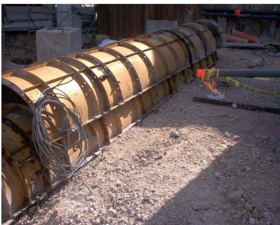
Fotos. 3.6.3.1: Encofrado metálico para vigas prefabricadas de hormigón armado
