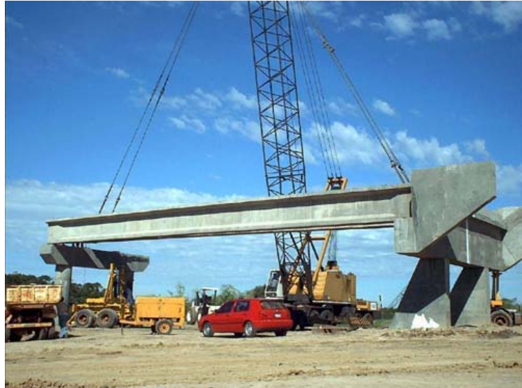
Fotos. 3.4.3: Grúas de izaje para ensamblaje de prefabricados
