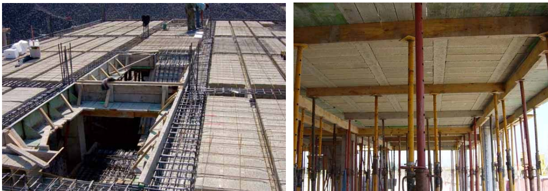
Fotos. 3.6.2.1: Encofrados horizontales unidireccionales
