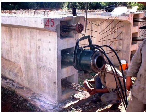
Fotos. 3.4.2: Postensado y ensamblaje de vigas prefabricadas en puente
