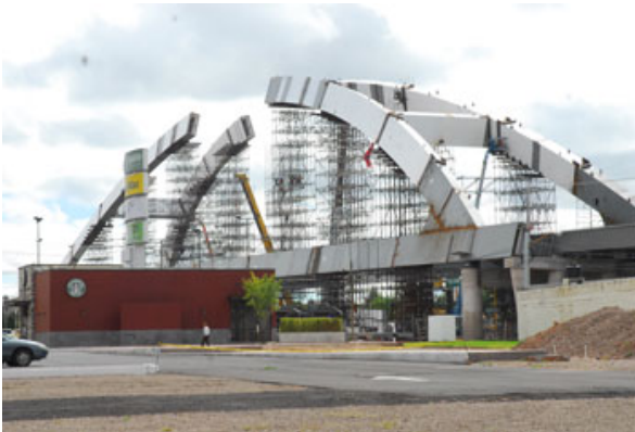
Fotos. 3.6.6.1: Instalación de unidades auxiliares para sostenimiento de elementos prefabricadas
