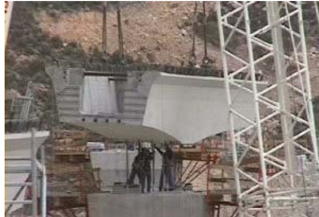
Fotos. 3.6.6.2: Dos tableros dobles prefabricados con continuidad hiperestática y pieza de cantiléver sobre pila
