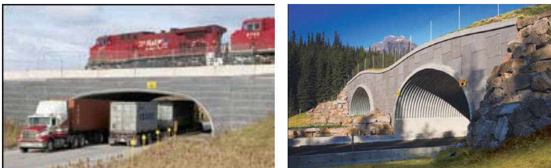
Foto 4.1.3.3: Paso deprimidos construidos en forma curva
