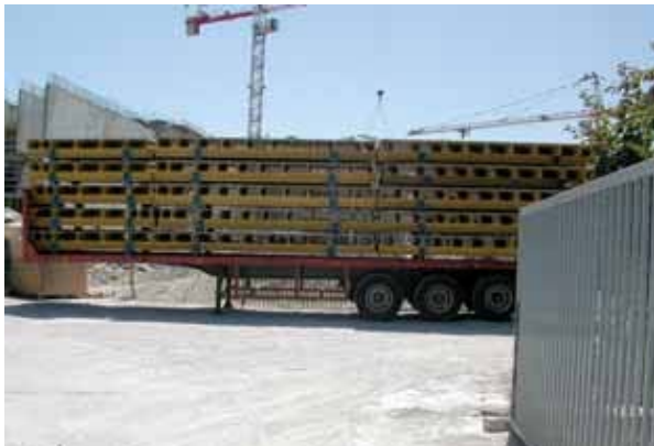
Fotos. 3.6.5.2: Carga y descarga de tableros y elementos de encofrados
