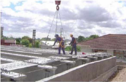
Fotos. 3.4.1: Ensamblaje de estructuras prefabricadas
