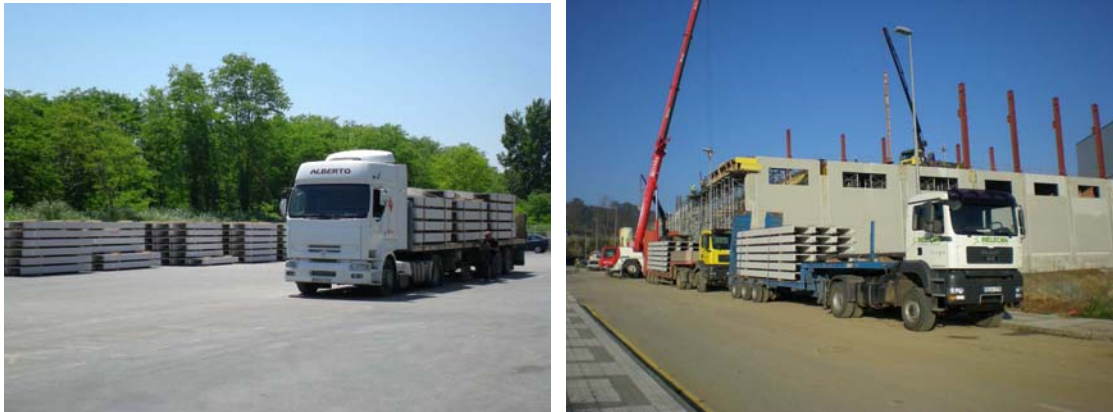
Fotos. 3.3.3: Traslado de prefabricados mediante camiones de carga
