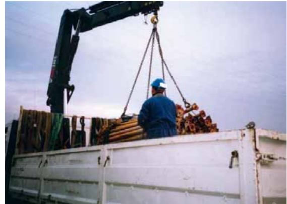
Fotos. 3.6.5.2: Carga y descarga de tableros y elementos de encofrados
