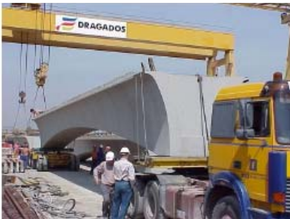
Fotos. 3.3.1: Transporte de una viga TIPO "U" y una Losa Prefabricada
