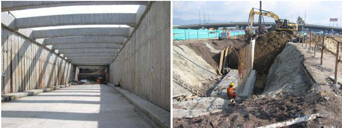
Fotos. 3.1.6: Acceso sur del deprimido vehicular y costado occidental en construcción.
