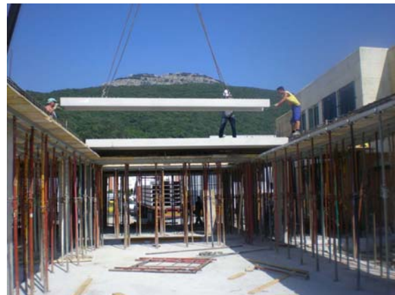
Fotos. 3.5.2: Izado de prefabricados con grúa
