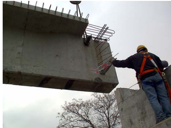
Fotos. 3.4.2: Postensado y ensamblaje de vigas prefabricadas en puente
