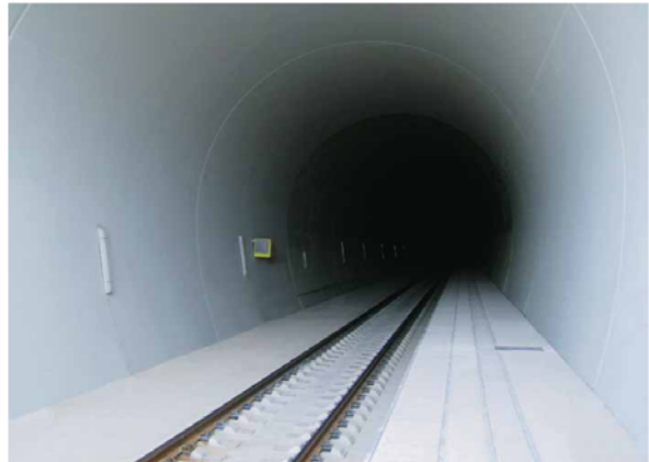
Fotos. 3.1.4: Interior de uno de los tubos del túnel de la Cabrera, con la vía en placa ya instalada, se utilizó dovelas de hormigón para revestimiento del túnel.
