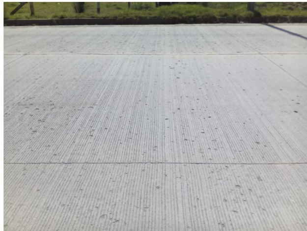
Figura 4.12 Desintegración presentada en el pavimento de la vía Cumbe - La Jarata absc 2+558.
