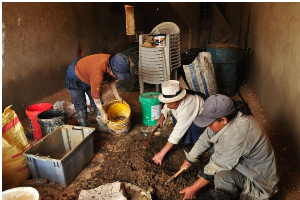
Colaborando en la preparación de mezcla para empañete
