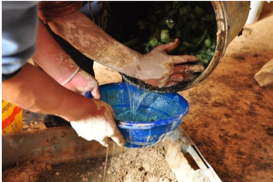
Cirniendo el mucílago de la tuna para la mezcla del empañete
