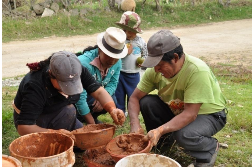
Preparando la mezcla para la capa de color del muro.
