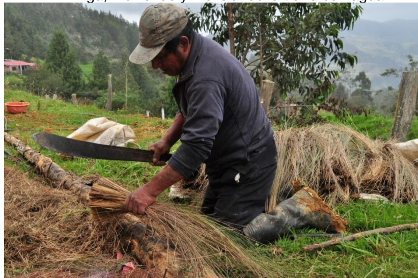
Cortando la paja para mezclar con el barro
