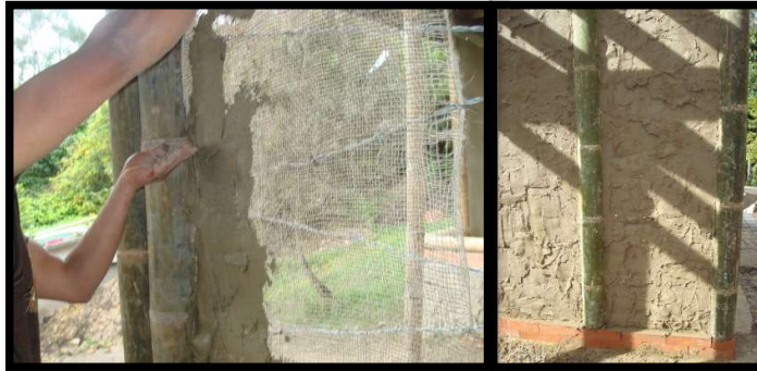
Ilustración 20: Bahareque con malla metálica
