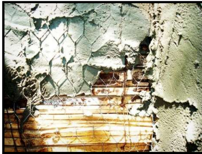
Ilustración 21: Bahareque con malla hexagonal
