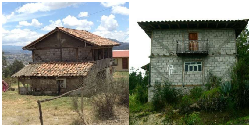
Ilustración 41: Composición de ejemplos de cambio de relleno de bahareque por bloque de pómez
