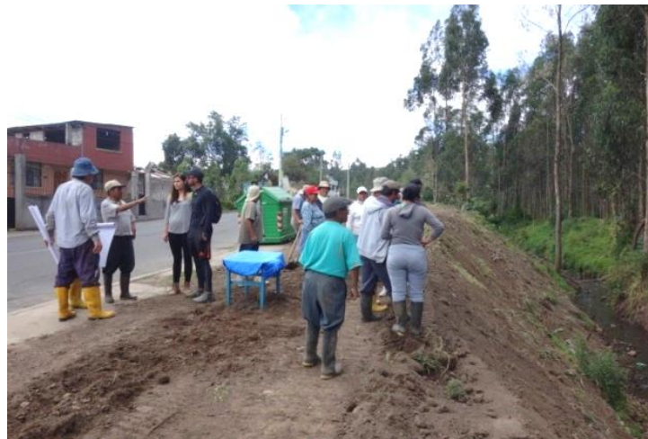
Figura 29: Trabajos participativos para la recuperación de la quebrada Suruhuayco. Elaboración propia, 2017
