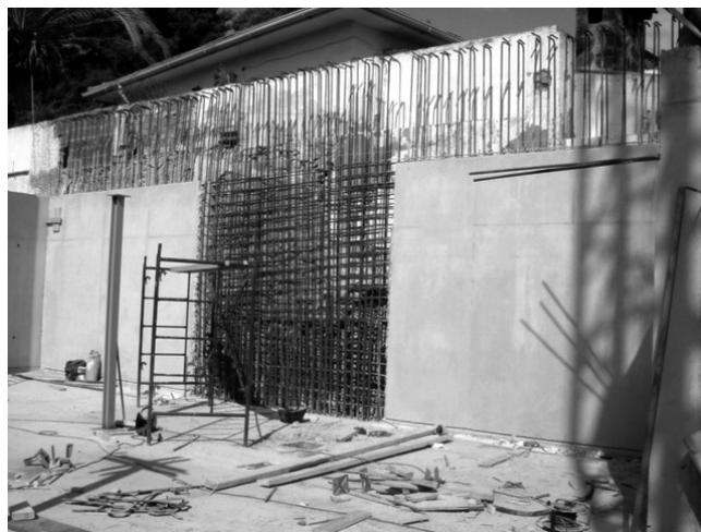
Imagen 358: Muros de Sótano en hormigón armado, para el edificio de oficinas Benigar. Estudio de Javier García-Solera.
