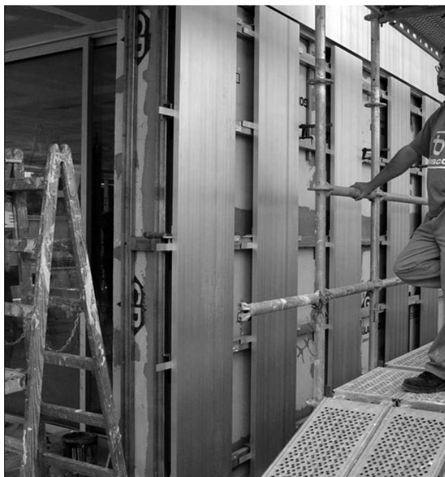
Imagen 497: Sistema de recubrimiento en base a tubería de aluminio anodizada.
