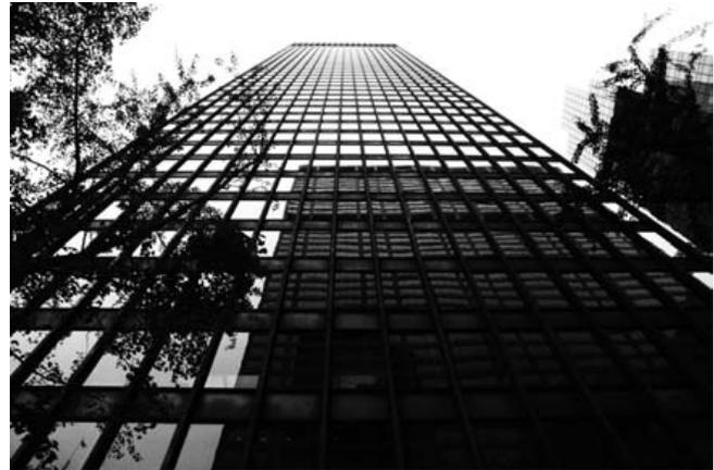
Imagen 89: Construcción con Acero Laminado (Envolvente de fachada). Estructura reticular, resistencia por su sección Transversal. Edificio Seagram, New York, Estados Unidos, 1958, Ludwig Mies Van der Rohe.
