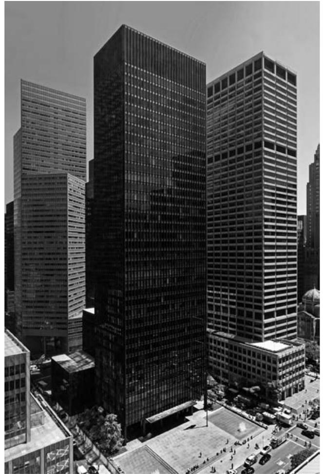
Imagen 88: Construcción con Acero Laminado (Envoltente de fachada). Estructura reticular, resistencia por su sección Transversal. Edificio Seagram, New York, Estados Unidos, 1958, Ludwig Mies Van der Rohe.
