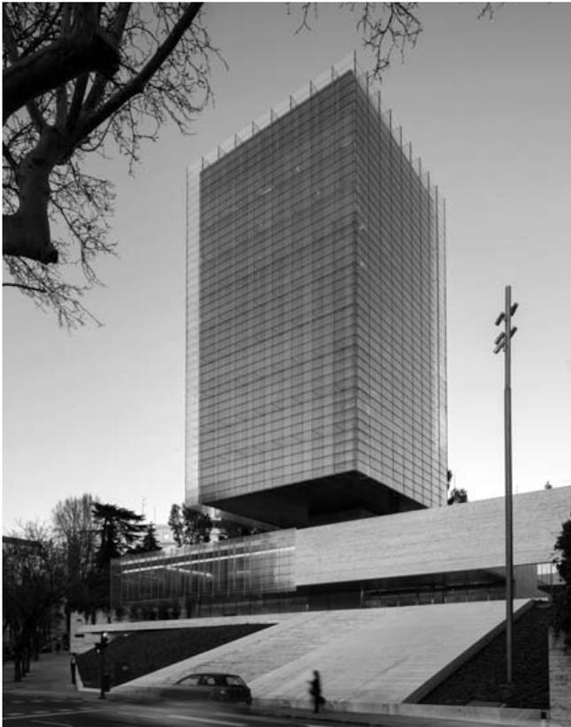
Imagen 60: Sistemas de conformación nuclear. La zona de concentración de cargas está en un núcleo central.
