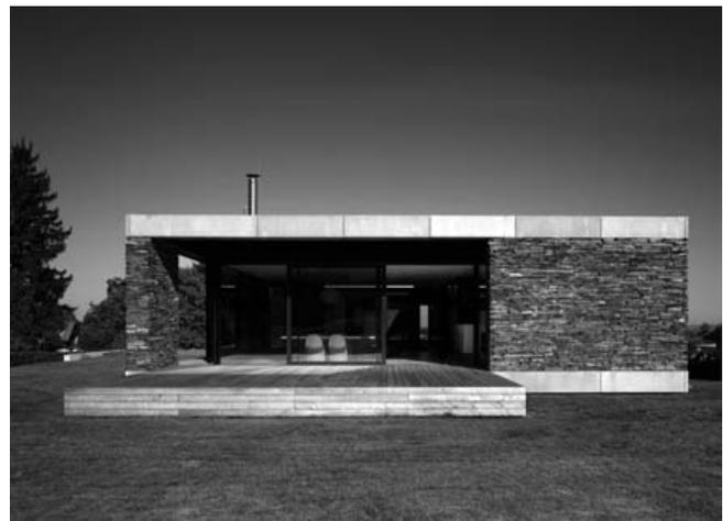
Imagen 71: Construcción con piedra. Sistema laminar de placas portantes. Vivienda en Ritka, Ritka, República Checa, 2011, Studio Pha. [http://images.adsttc.com/media/images/50e5/9328/b3fc/4b32/7e00/00c9/large\\_jpg/Photo\\_06.jpg?1413927033](http://images.adsttc.com/media/images/50e5/9328/b3fc/4b32/7e00/00c9/large_jpg/Photo_06.jpg?1413927033)
