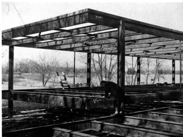
Imagen 87: Construcción con acero laminado. Sistema de estructuras de pórticos y retículas de vigas.
