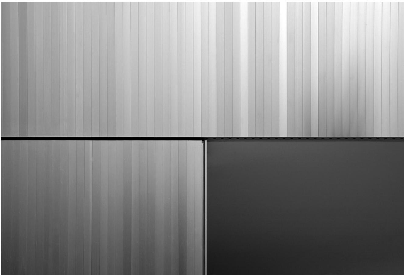
Imagen 498: Sistema de recubrimiento en base a tubería de aluminio anodizada.
