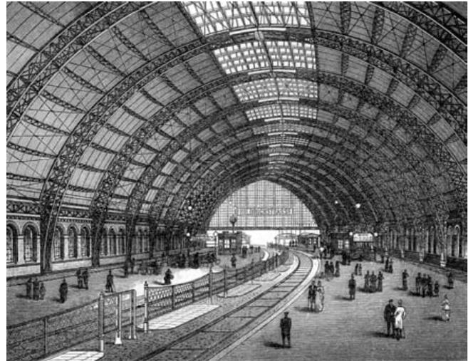
Imagen 83: Construcción con hierro fundido. Sistema por división de esfuerzos: cerchas curvas.
