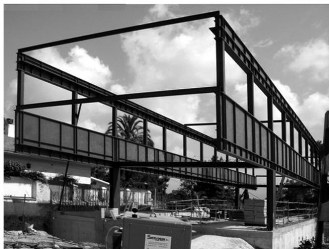
Imagen 359: Estructura metálica para el edificio de oficinas Benigar. Estudio de Javier García-Solera.
