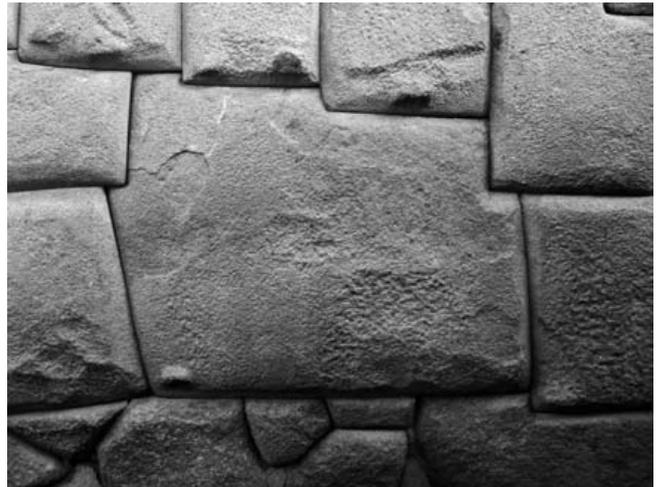
Imagen 23: Los muros de piedra resisten muy poca tracción, pero tienen mucha rigidez. Piedra de los 12 ángulos, muro en la calle Hatun Rumiyoq, en la ciudad de Cuzco, Perú.
