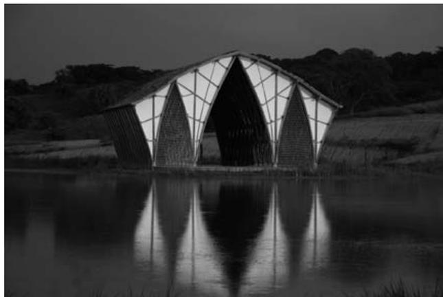
Imagen 98: Construcción con guadúa. Sistema mixto de mallas espaciales y arcos apuntados.
