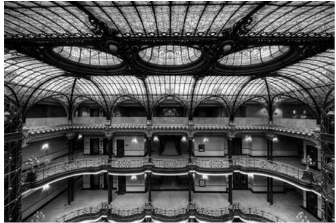
Imagen 84: Construcción con hierro fundido. Sistema por división de esfuerzos: cerchas curvas.
