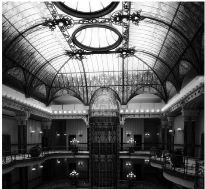
Imagen 85: Construcción con hierro fundido. Sistema por división de esfuerzos: cerchas curvas.
