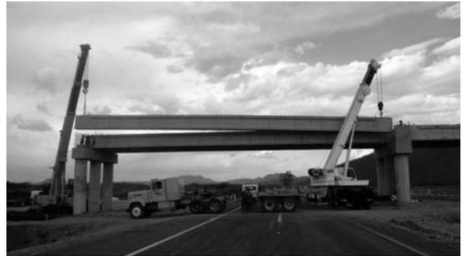
Imagen 109: Montaje de elementos prefabricados y pretensados. Colocación de una viga pretensada de un puente.
