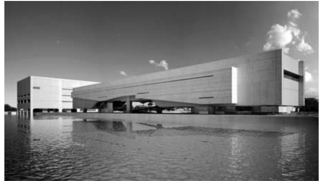
Imagen 110: Construcción en hormigón pretensado, sistema por sección transversal conformando pórticos. Cais das Artes, Bahía de Suã, Vitoria, Brasil, 2011, Paulo Mendes da Rocha, João Eduardo de Gennaro y METRO Arquitectos Asociados.
