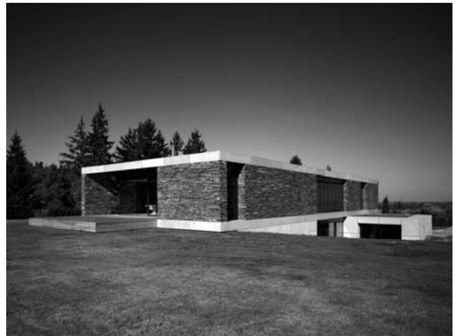
Imagen 70: Construcción con piedra. Sistema laminar de placas portantes. Vivienda en Ritka, Ritka, República Checa, 2011, Studio Pha. [http://images.adsttc.com/media/images/50e5/932b/b3fc/4b32/7e00/00ca/large\\_jpg/Photo\\_05.jpg?1413927038](http://images.adsttc.com/media/images/50e5/932b/b3fc/4b32/7e00/00ca/large_jpg/Photo_05.jpg?1413927038)
