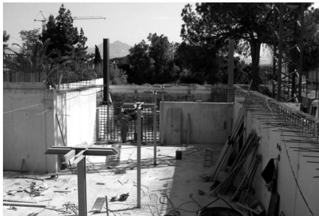
Imagen 366: Construcción del proyecto. Estructura inferior de hormigón armado.
