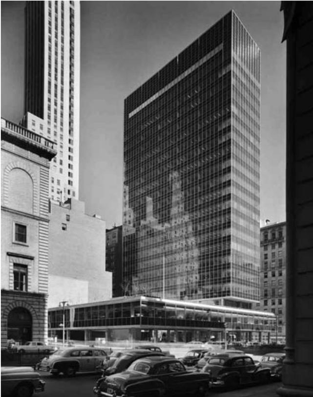
Imagen 58: Sistemas de conformación reticular. Las zonas de concentración de cargas se distribuyen lo más uniformemente posible por cada nivel. Lever House, New York, Estados Unidos, 1952, Gordon Bunshaft y Skidmore, Owings & Merrill. (Foto de Ezra Stoller) <https://sobrearquitecturas.files.wordpress.com/2014/06/lever-house-skidmore-owings-merrill-new-york-ny-1952-35m-001-96825bf2779c6c2ae2547fb031e91ec20c30d29a-s6-c30.jpg>
