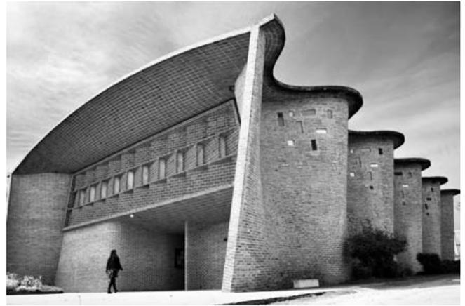
Imagen 80: Construcción con ladrillo. Sistema laminar de placas cilíndricas plegadas.
