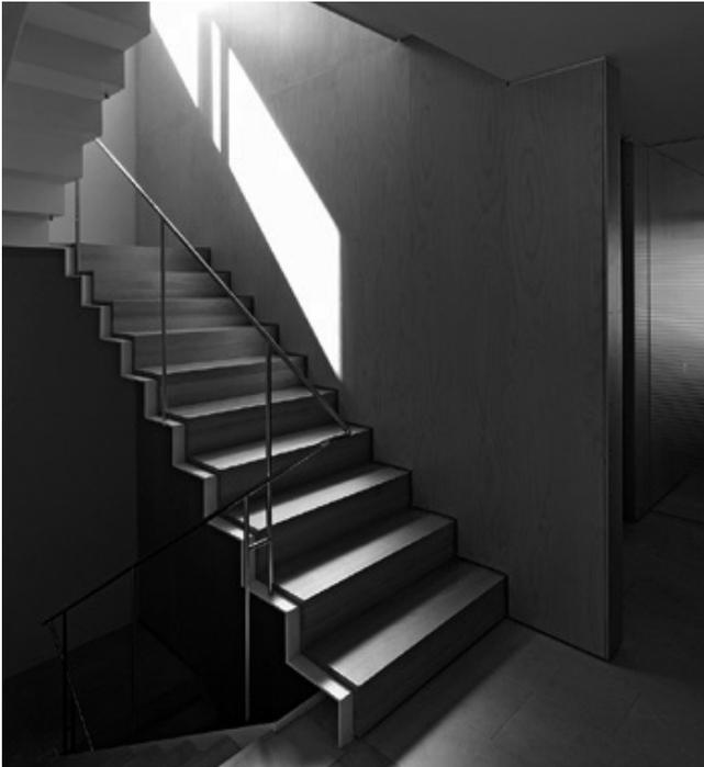
Imagen 404: Escalera metálica recubierta con madera.
