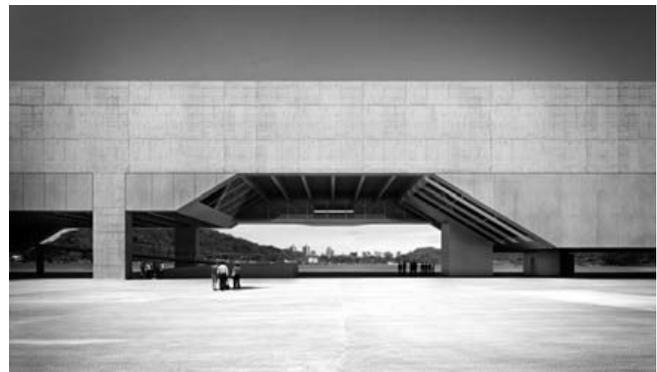
Imagen 111: Construcción en hormigón pretensado, sistema por sección transversal conformando pórticos. Cais das Artes, Bahía de Suã, Vitoria, Brasil, 2011, Paulo Mendes da Rocha, João Eduardo de Gennaro y METRO Arquitectos Asociados.
