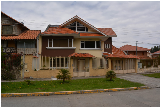
Figura 4.28 Estado actual de edificación, Zona 5.
