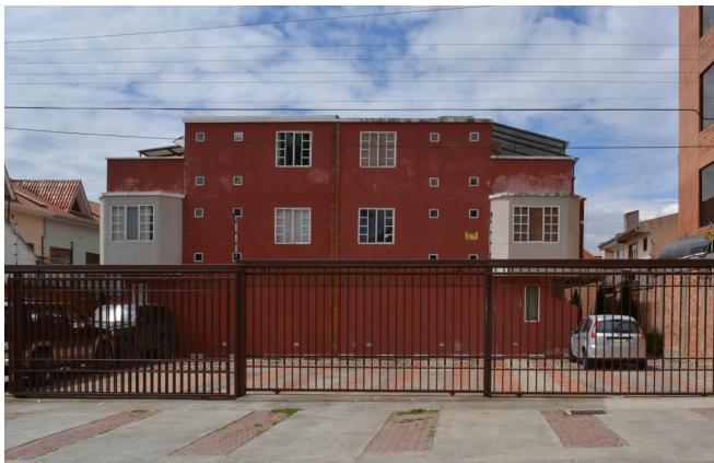
Figura 4.24 Estado actual de edificación, Zona 5.
