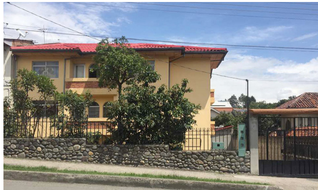
Figura 2.90 Cerramiento combinado de piedra y metal.
