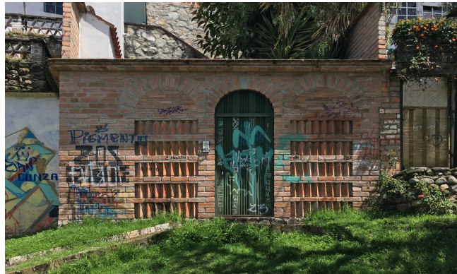
Figura 2.74 Cerramiento de ladrillo.
