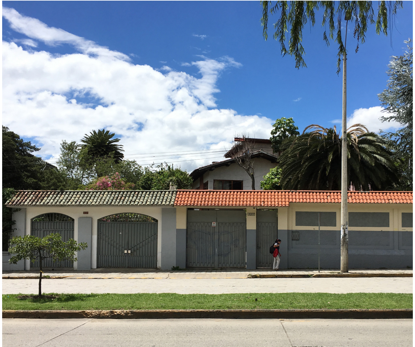
Figura 4.1 Edificaciones que incumplen con la normativa, zona 3.
