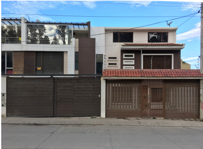
Figura 4.20 Estado actual de edificación, Zona 1.
