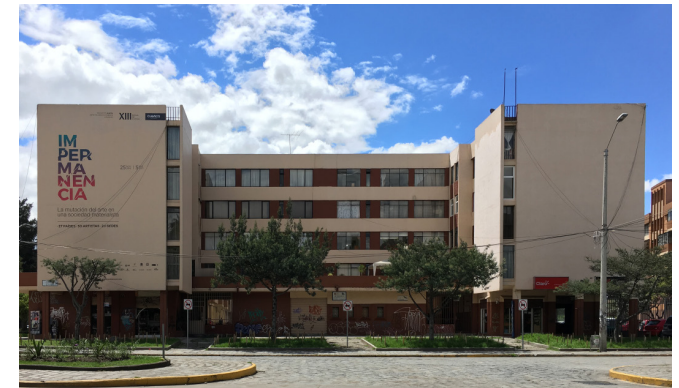
Figura 2.77 Fachada de mampostería.
