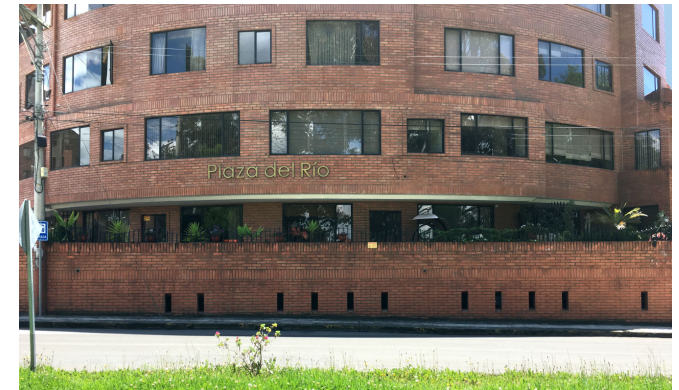
Figura 2.52 Cerramiento de ladrillo.
