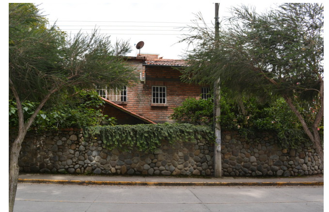
Figura 4.27 Estado actual de edificación, Zona 5.
