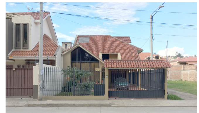
Figura 2.31 Cerramiento de metal.
