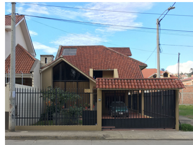
Figura 4.15 Estado actual de edificación, Zona 1.
