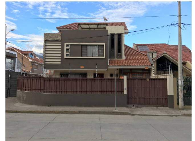
Figura 4.19 Estado actual de edificación, Zona 1.
