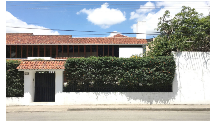
Figura 2.50 Cerramiento de mampostería y vegetal.
