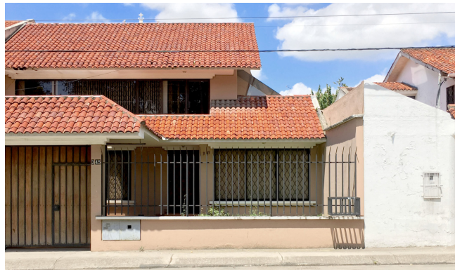
Figura 2.53 Cerramiento combinado, mampostería y metal.
