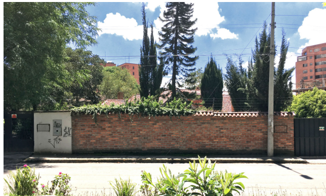
Figura 2.51 Cerramiento de ladrillo.
