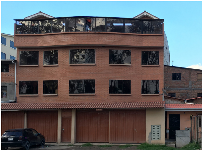
Figura 4.16 Estado actual de edificación, Zona 1.
