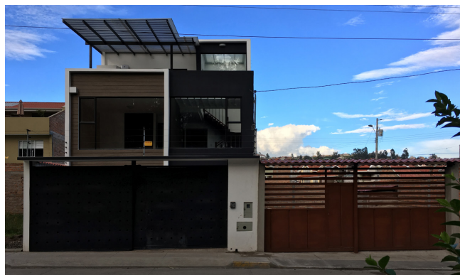
Figura 2.30 Cerramiento de metal.
