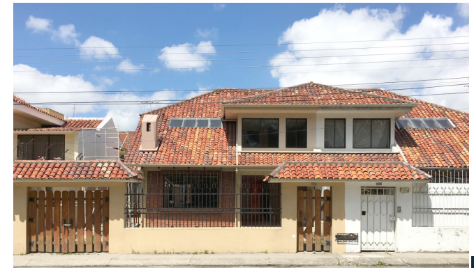
Figura 2.54 Cerramiento combinado, mampostería y metal.
