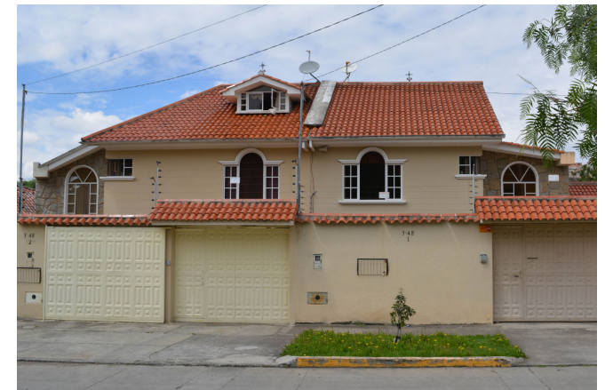
Figura 4.23 Estado actual de edificación, Zona 5.
