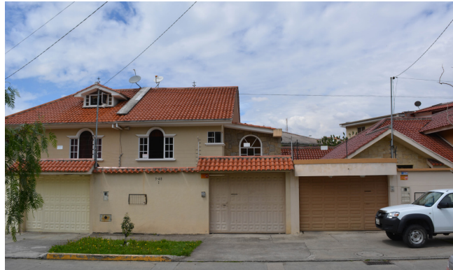
Figura 2.110 Cerramiento de mampostería.
