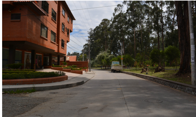
Figura 2.108 Edificio sin cerramiento.
