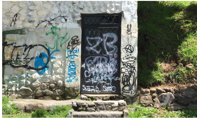
Figura 2.72 Fachada de piedra.
