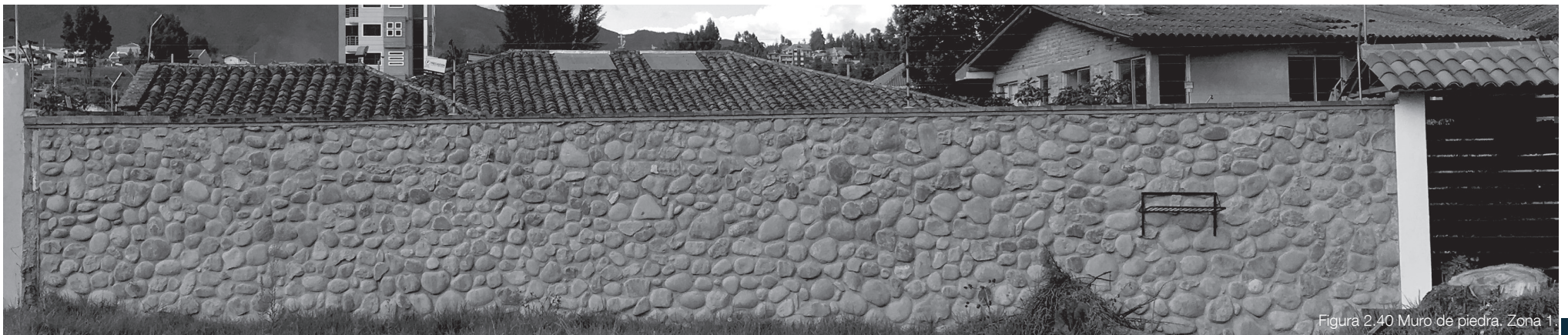
Figura 2.39 Muro de piedra. Zona 1
