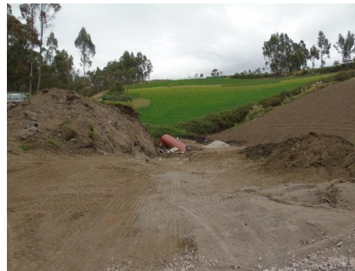
Fotografía No 16: Ejecución de relleno dentro de la Quebrada Santa Lucía del Cantón Tisaleo Autor: Elizabeth Miranda (2017)
