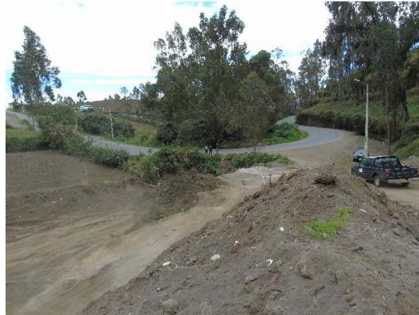
Fotografía No 9: Vialidad existente junto a las áreas de la Quebrada Santa Lucía. Autor: Elizabeth Miranda
