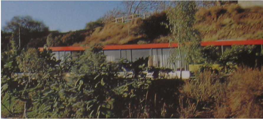
Figura 27. Vista desde la calle CSH 1950
