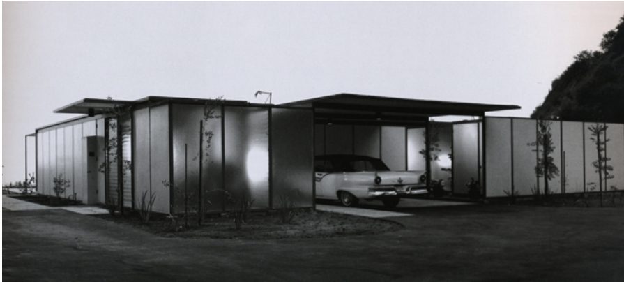
Figura 31. Vista del acceso vehicular CSH #18
