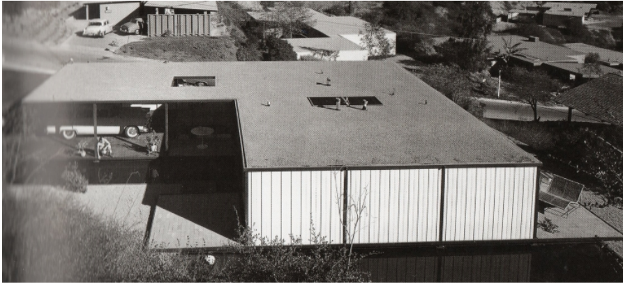
Figura 35. Vista aérea CSH #21
