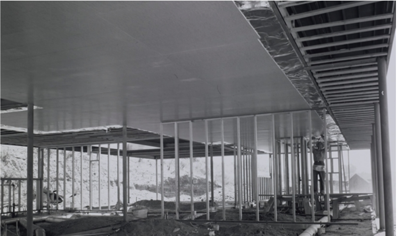
Figura 01. CSH 1950 Rafael Soriano, 1950. Montaje de Paneles y Cielo Raso en Estructura.
