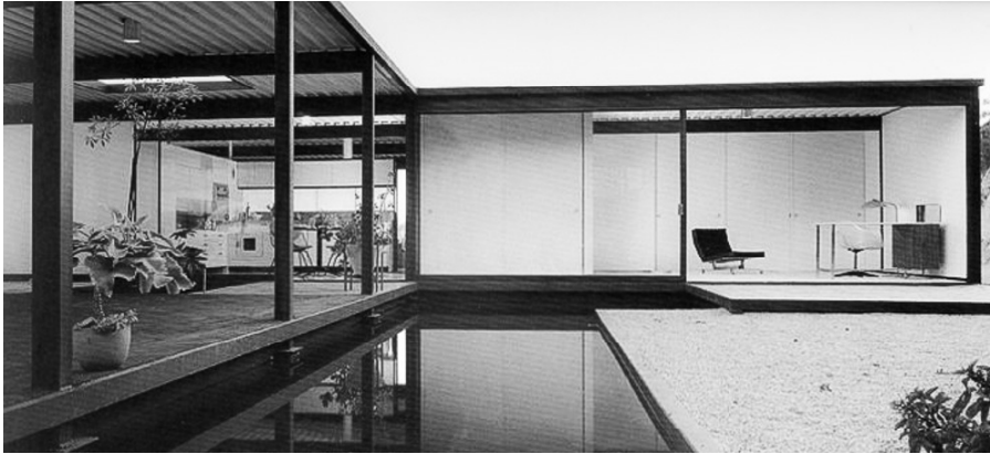
Figura 41. Vista de la fachada Norte y parte del garaje CSH #21
