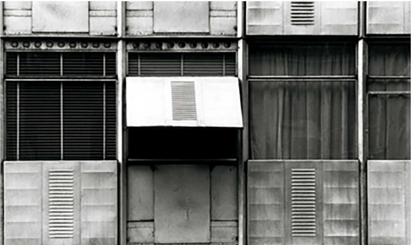
Figura 09. Muro Cortina de la vivienda de JEAN PROUVÉ, 1960
