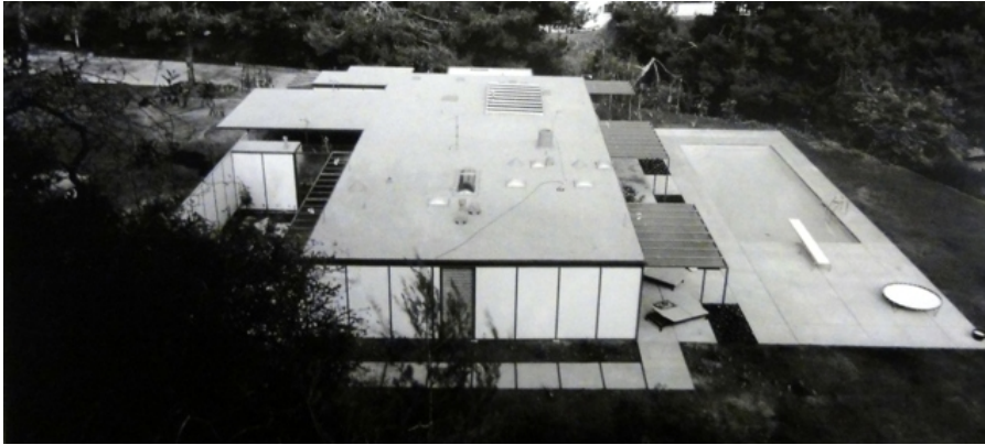
Figura 29. Vista Aérea CSH #18
