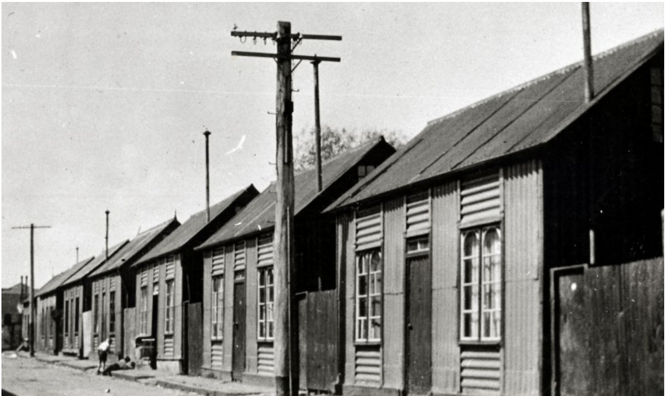
Figura 08. Casa Portables con placas de corrugadas de hierro en el sur de Melbourne
