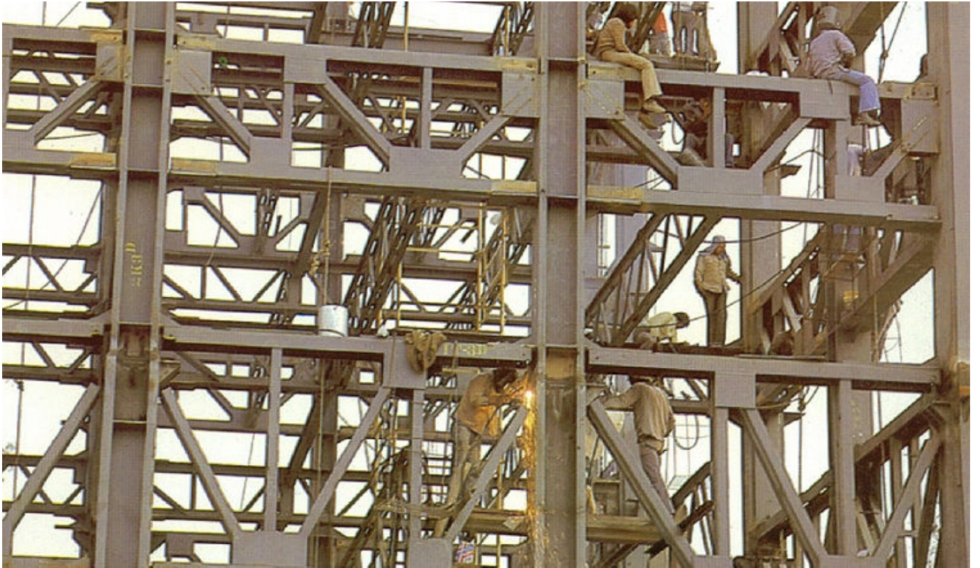
Figura 02. Estructuras de Hierro
