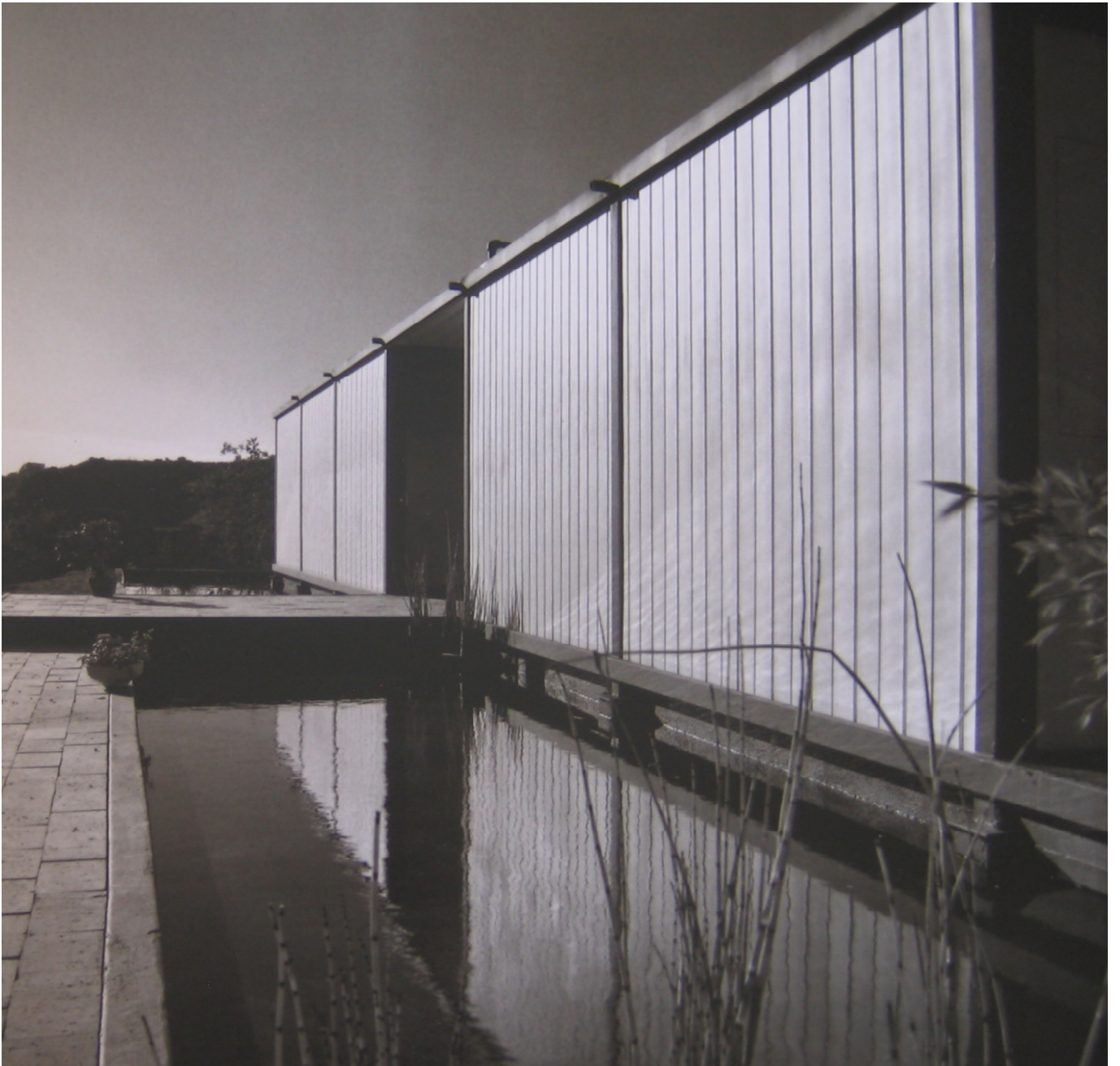
Figura 40. Vista de la fachada Este junto al estanque de agua CSH #21
