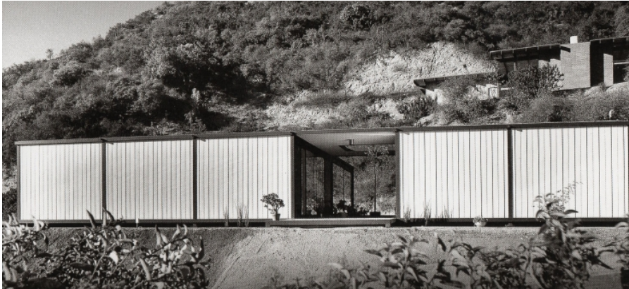
Figura 39. Vista desde la calle CSH #21
