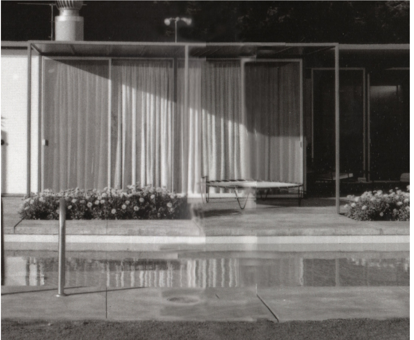
Figura 34. Pérgola Fachada Sur CSH #18
