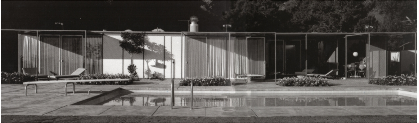
Figura 33. Fachada Sur CSH #18
