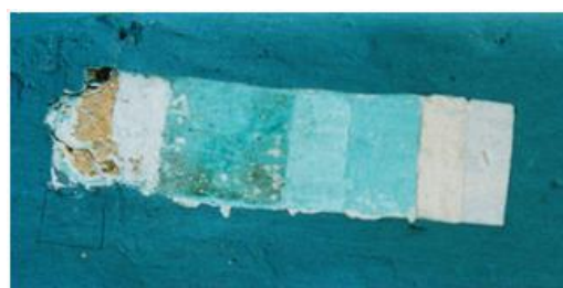
Figura 2 y 4: Calas de prospección en pared y en columna; edificación ubicada en la calle Mariano Cueva 4-22 entre las calles Larga y Honorato Vázquez. Fuente: Achig & Paredes, 2001.
