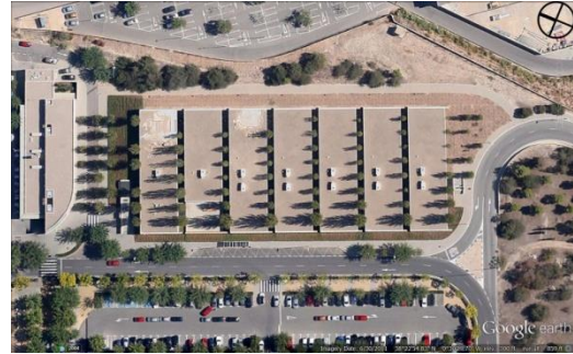
Figura 5: emplazamiento del Aulario III.
