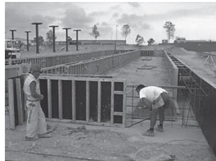
Figura 14: Construcción de vigas de cimentación elevadas
