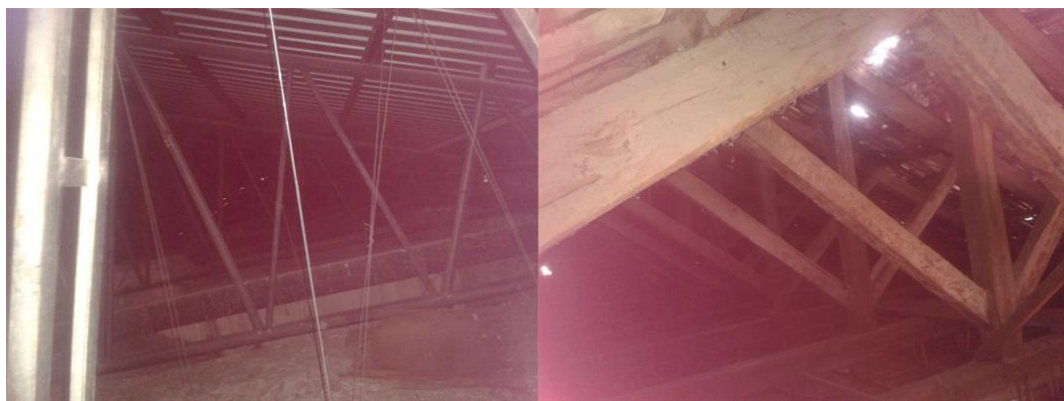
Figura 12: Estructuras de cubierta metálica y de madera de las iglesias de Santo Domingo y San Agustín, respectivamente
