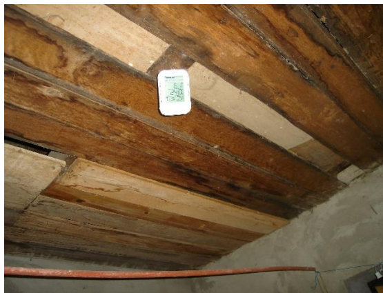
Fotografía 47: Instalación de registrador de datos en el interior de la vivienda.
