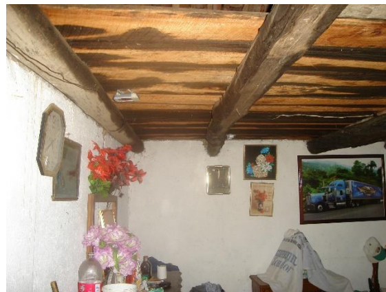
Fotografía 42: Instalación de registrador de datos en el interior de la vivienda.
