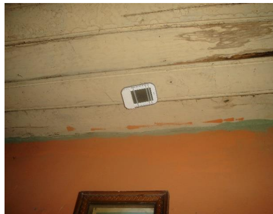
Fotografía 36: Instalación de registrador de datos en el interior de la vivienda.
