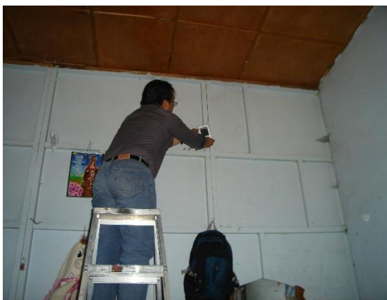
Fotografía 5: Instalación del registrador de datos.
