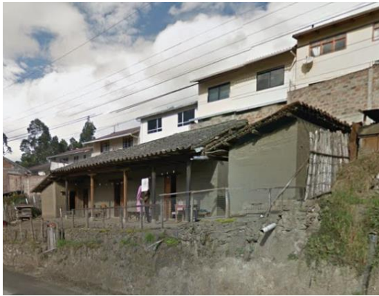
Fotografía 19: Vista frontal de la vivienda.
