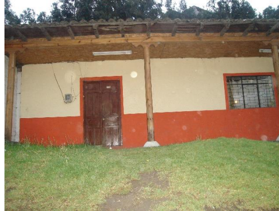
Fotografía 2: Detalle de portal frontal.
