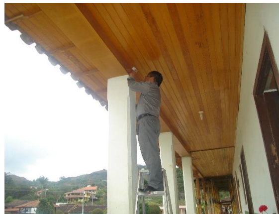
Fotografía 28: Instalación de sensores en el exterior de la vivienda.
