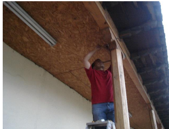
Fotografía 4: Instalación de sensores en el exterior de la vivienda.
