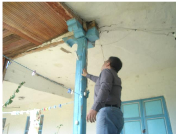
Fotografía 12: Instalación de sensores al exterior de la vivienda.
