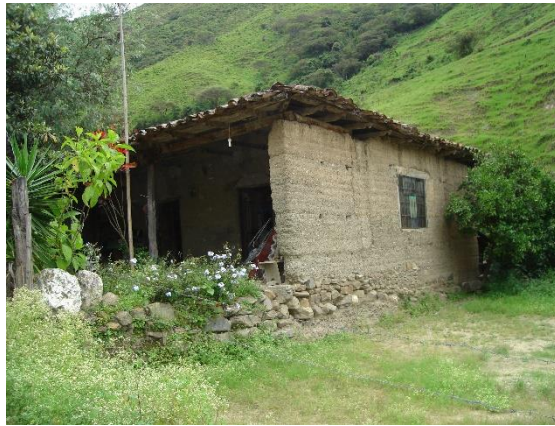
Fotografía 43: Vista frontal de la vivienda.
