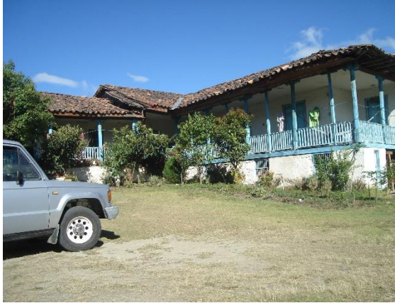
Fotografía 7: Vista frontal de la vivienda.
