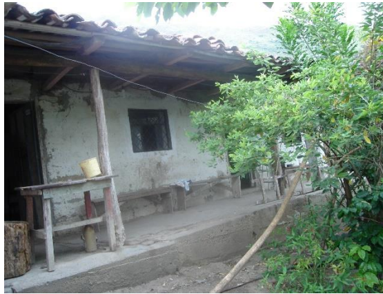
Fotografía 37: Vista frontal de la vivienda.
