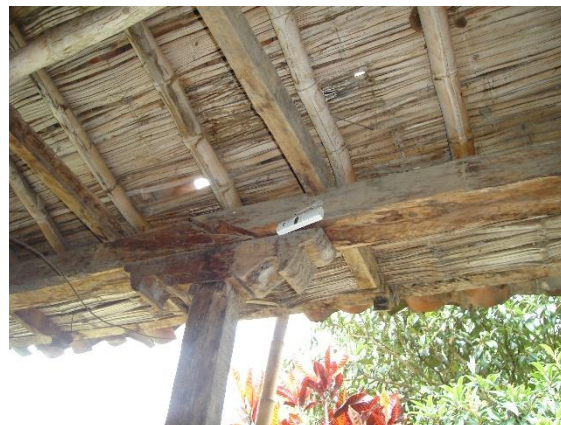
Fotografía 48: Instalación de sensores en el exterior de la vivienda.
