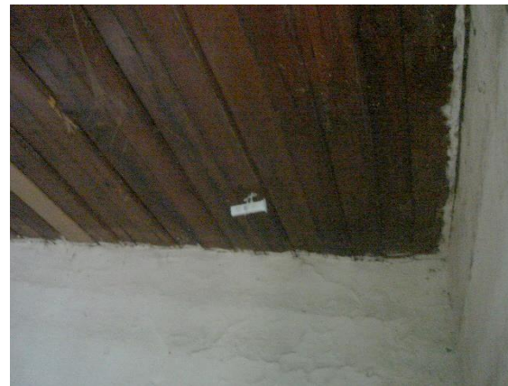
Fotografía 18: Instalación de sensores al interior de la vivienda.
