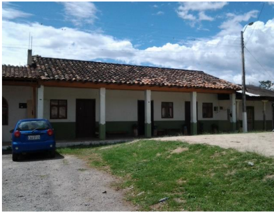
Fotografía 25: Vista frontal de la vivienda.
