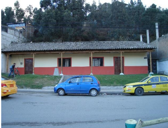
Fotografía 1: Vista frontal de la vivienda.
