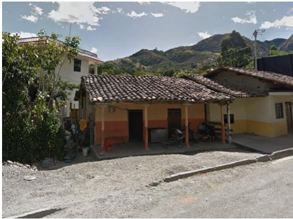
Fotografía 31: Vista frontal de la vivienda.
