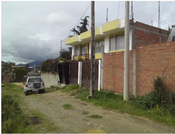
Fotografía 49: Vista frontal de la vivienda.
