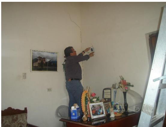
Fotografía 29: Instalación de registrador de datos en el interior de la vivienda.
