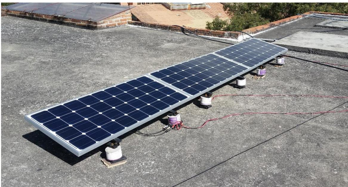
Fig. 18: Paneles monocristalinos montados sobre soportes de hierro con bases cilíndricas de cemento.
