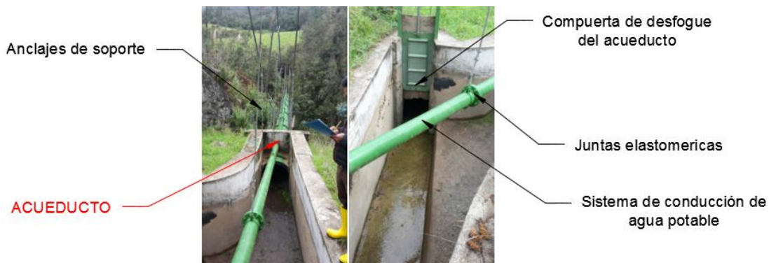
Figura 6.31: Detalle del acueducto.
