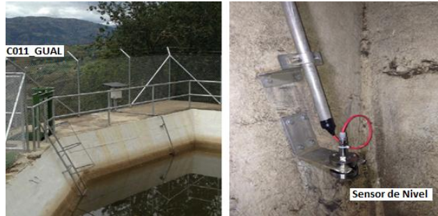
Figura 5.7: Sensor de nivel ubicado en el taque de carga. Fuente: Realizado por Ángel Guamán y Cristian Pesantez.
