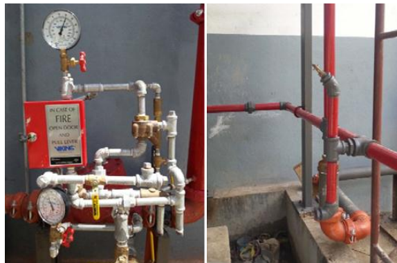
Figura 4.38: Válvula de diluvio y boquillas tipo abierto.
