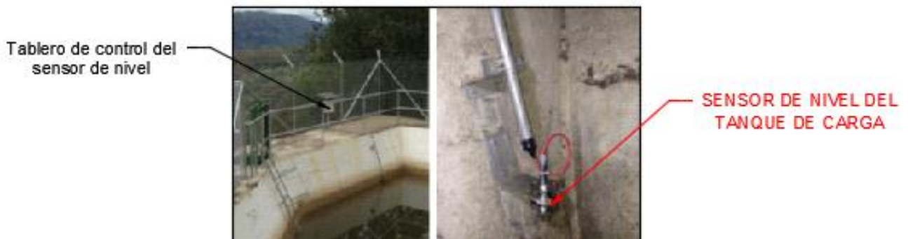
Figura 6.35: Detalle y ubicación del sensor de nivel del tanque de carga.
