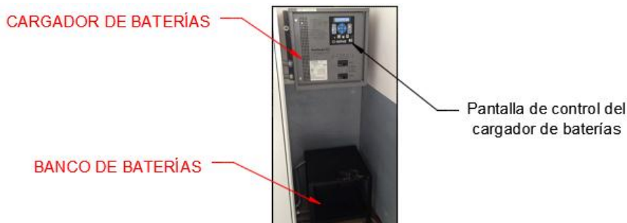
Figura 6.38: Detalle del cargador de baterías del tanque de carga.
