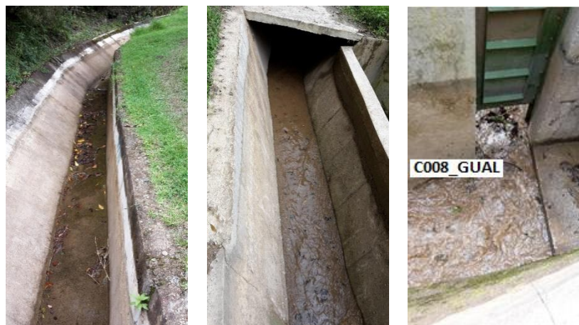
Figura 5.5: Limpieza de los canales de conducción de agua de la Mini – Central Gualaceo.
