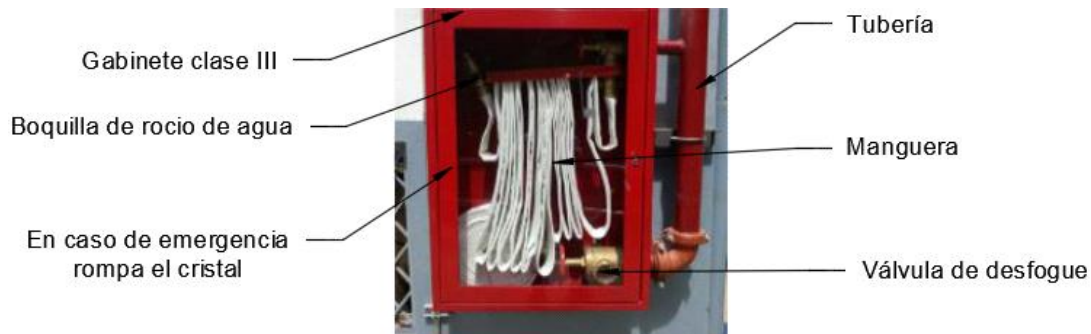
Figura 6.103: Detalle del gabinete clase III.
