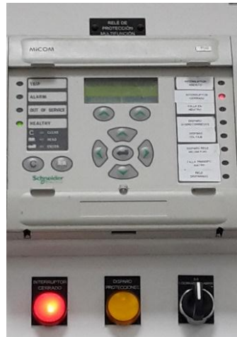
Figura 4.32: Relé de protección.
