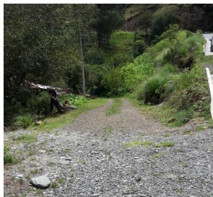
Figura 6.90: Vía de acceso al tanque de carga de la mini central.
