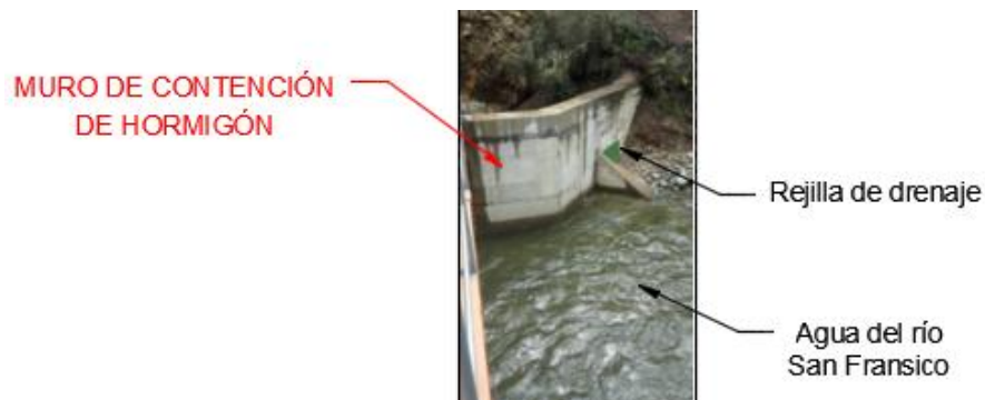
Figura 6.21: Muros de contención de la captación.
