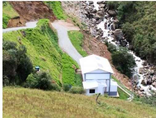
Figura 3.12: Casa de máquinas de la Mini – Central Gualaceo.
