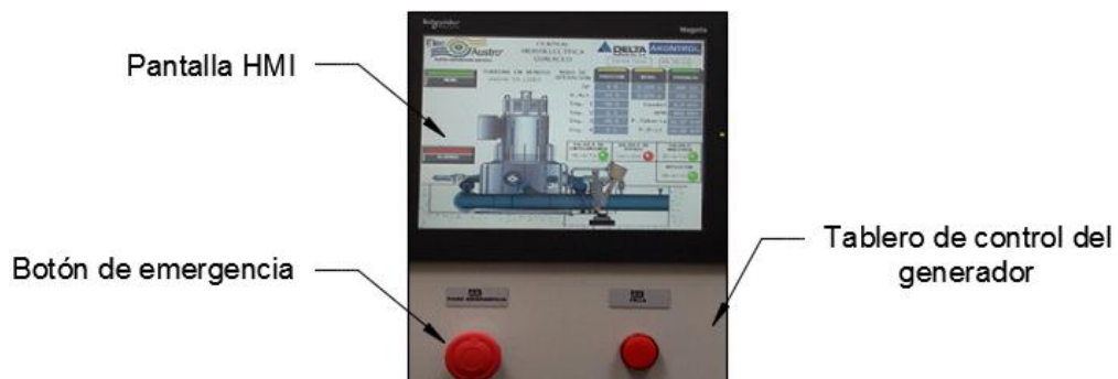
Figura 5.15: Botón de “PARO EMERGENCIA” en el tablero de control. Fuente: Unidad de Supervisión de Proyectos (ELECAUSTRO S.A.), Sistema SCADA.
