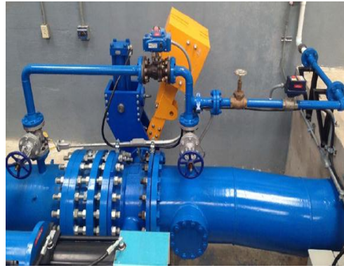
Figura 4.24: Válvula de guardia posición abierta.
