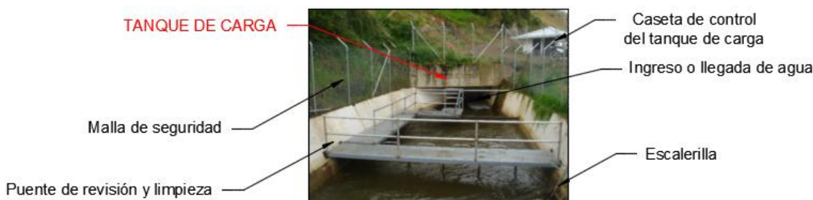
Figura 6.33: Detalle del tanque de carga.
