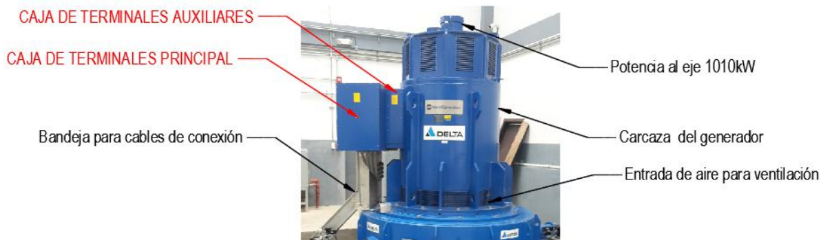
Figura 6.50: Partes de la unidad de generación.
