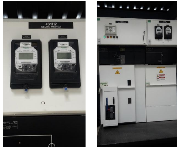
Figura 4.29: Celdas de media tensión de la Mini – Central Gualaceo.
