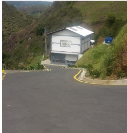
Figura 6.88: Vía de acceso a la casa de máquinas de la mini central.
