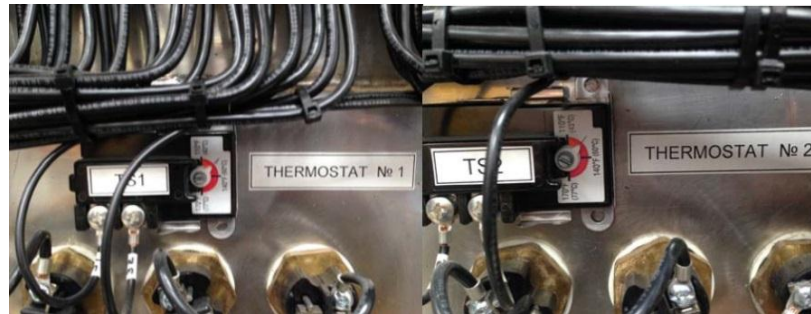
Figura 4.18: Termómetro del tanque de resistencias.
