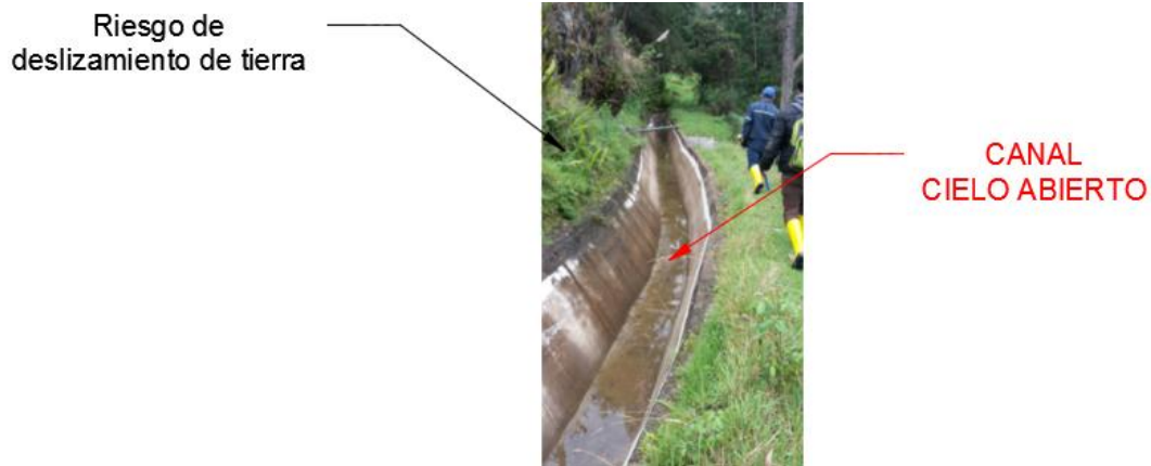
Figura 6.28: Detalle de las canales de conducción a cielo abierto.
