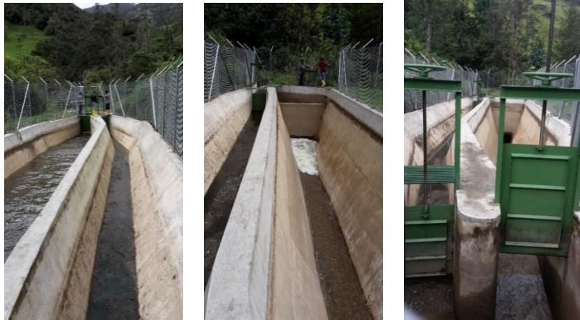
Figura 3.6: Desarenador de la Mini – Central Gualaceo.
