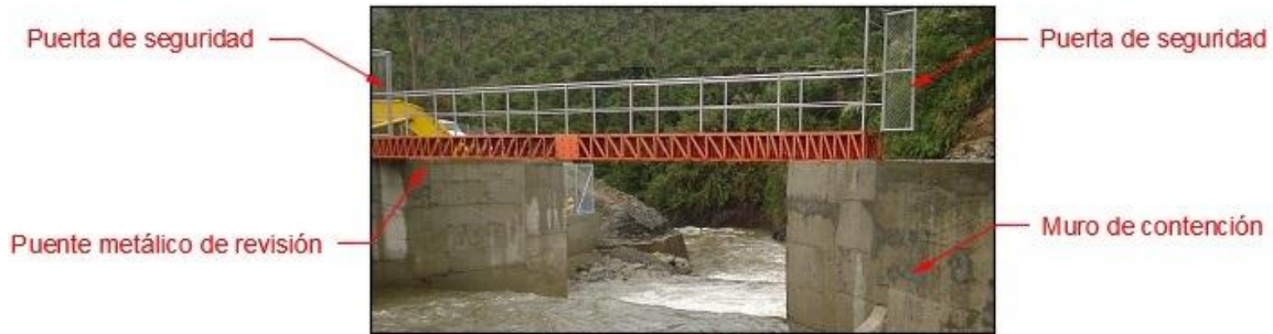
Figura 6.20: Partes del puente de la captación.
