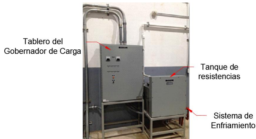
Figura 6.71: Partes del gobernador de carga.
