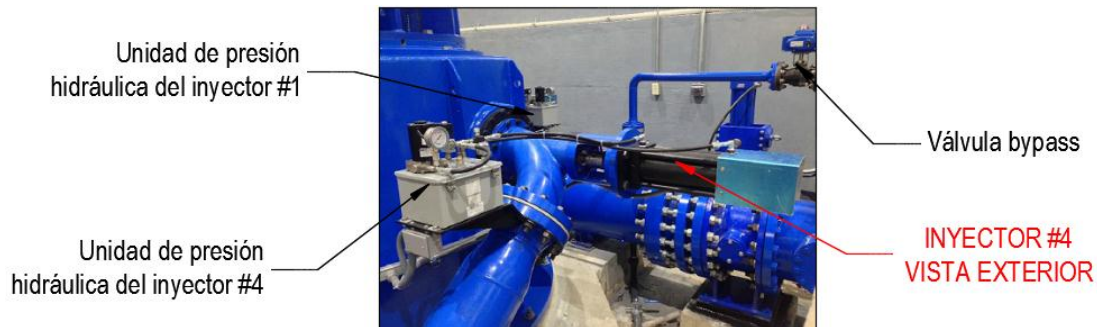
Figura 6.59: Detalle de los inyectores.
