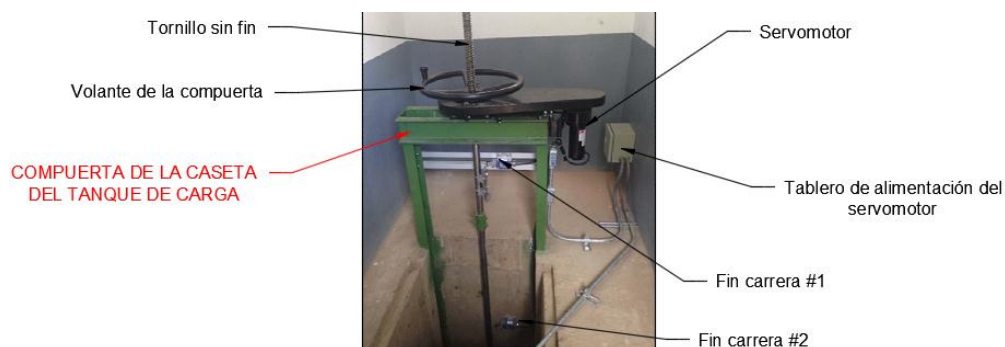
Figura 6.41: Detalle de la compuerta del tanque de carga.
