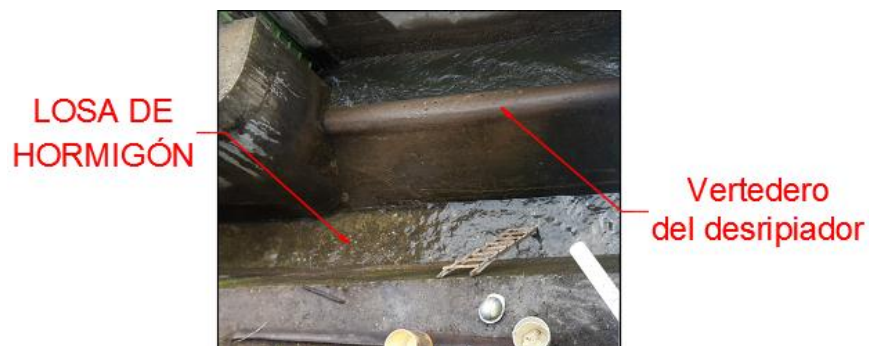
Figura 6.23: Cimiento de la captación.
