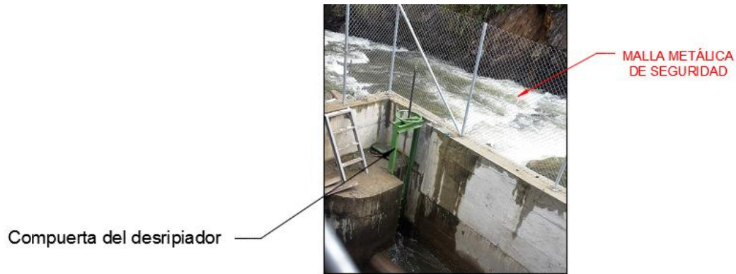
Figura 6.27: Cerramiento con malla galvanizada.
