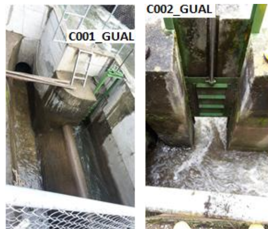
Figura 5.2: Captación y vertedero 1 de la Mini – Central Gualaceo.
