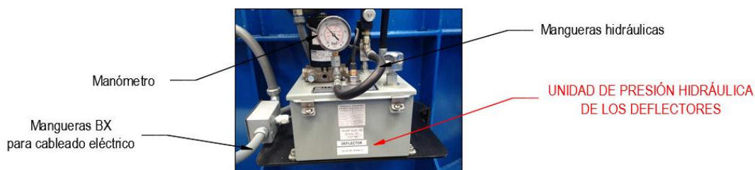
Figura 6.67: Detalle de la UHP de los deflectores.
