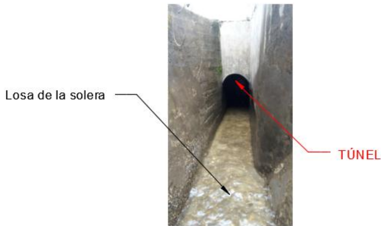
Figura 6.32: Túneles del sistema de conducción de agua.
