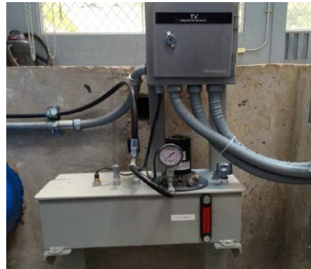
Figura 4.25: Unidad hidráulica de control de la válvula mariposa.
