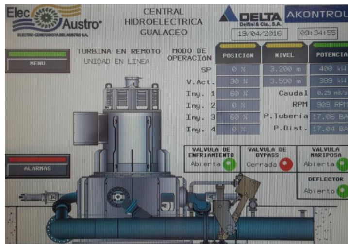
Figura 5.8: Pantalla HMI en el tablero de control.
