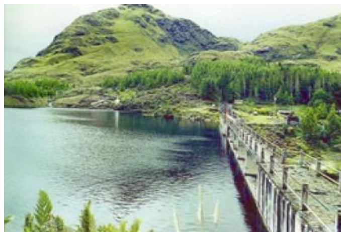
Figura 2.2: Presa Lcdo. Daniel Toral Vélez (El Labrado) de propiedad de Electro Generadora del Austro “ELECAUSTRO S.A.”
