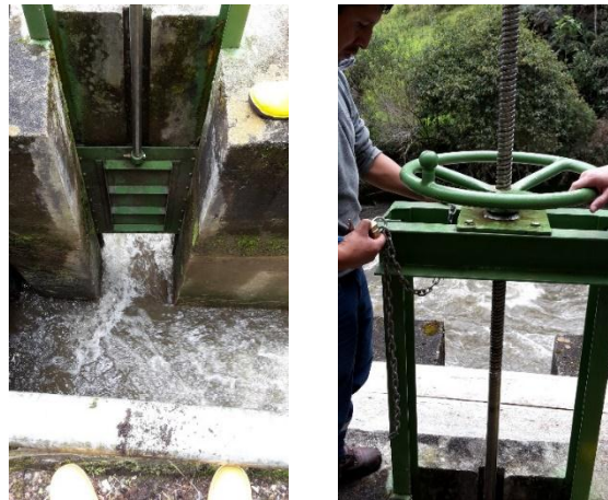
Figura 3.4: Compuertas de los vertederos de la Mini – Central Gualaceo.
