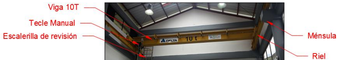
Figura 6.76: Partes del puente grúa.
