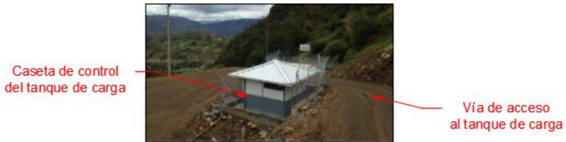
Figura 6.89: Vía de acceso al tanque de carga de la mini central.
