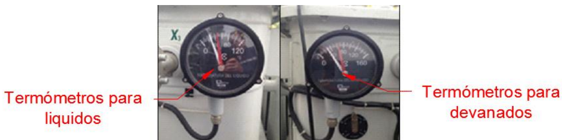
Figura 6.74: Termómetros para aceite y devanado.
