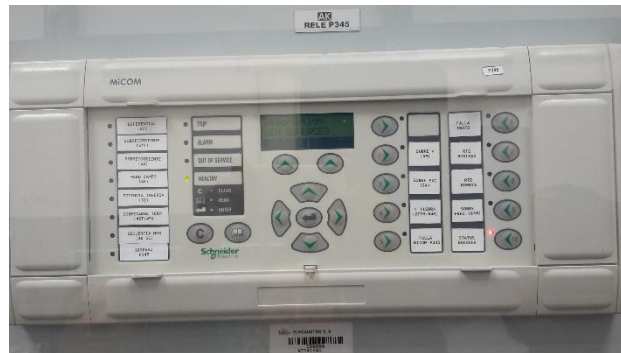
Figura 4.31: Relé de protección P345.
