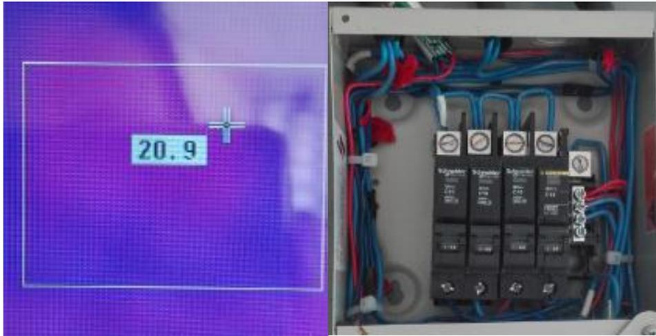
**Figura 3:** Imagen térmica de caja de breakers.
