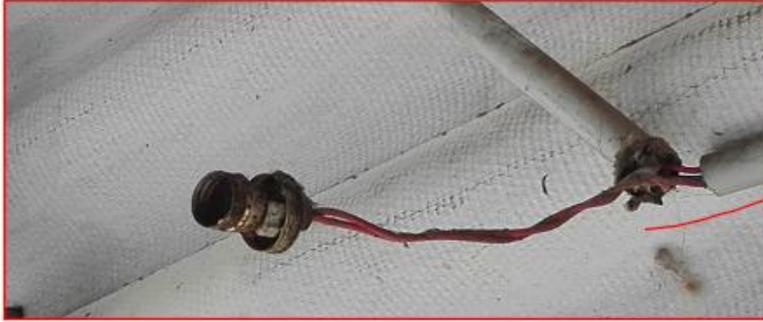
Luminarias deterioradas por falta de mantenimiento
