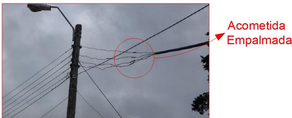
**Figura 3.10:** Acometida Empalmada de manera Inadecuada.
