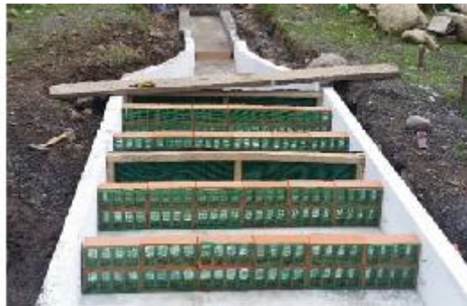
Figura. 6. Aquietamiento del flujo de ingreso, aguas arriba y aguas abajo del vertedero de control
