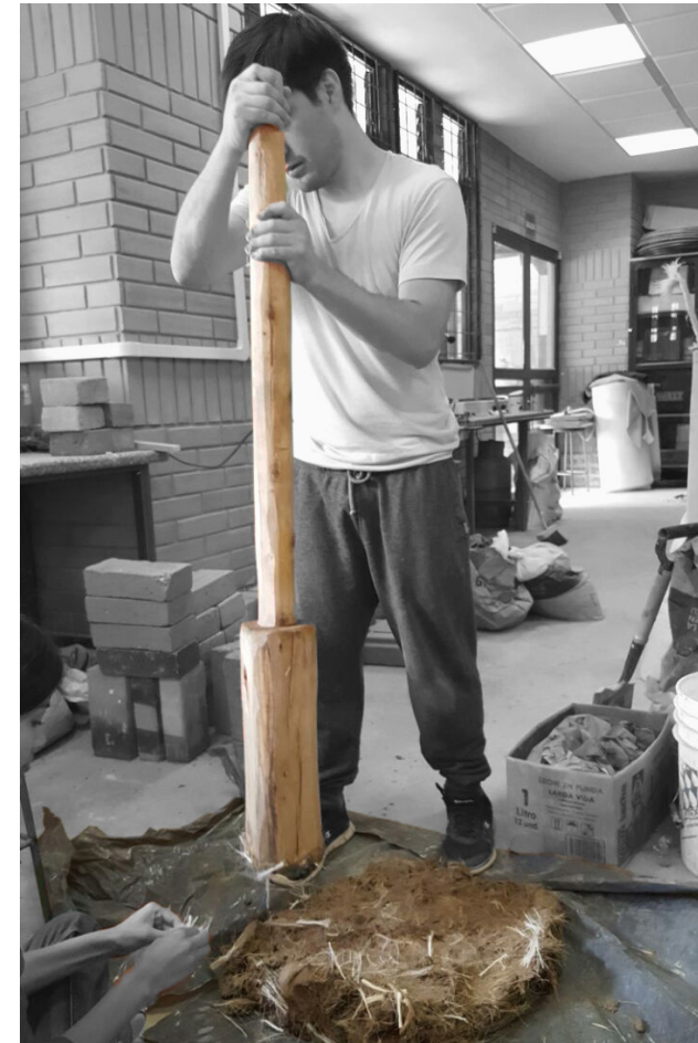
Imagen 178. Mezcla y compactación de material con cabuya. Delgado, K. y Flores, C. (2017).
