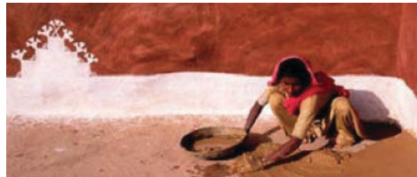
Imagen 58. Colocación de pigmentos naturales para pisos, India.
