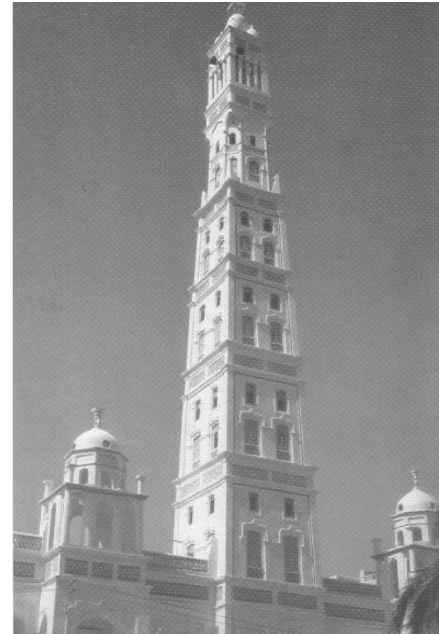
Imagen 01. Torre de la mezquita de Tarim, Yemen, 38 m de altura construida con adobe hecho a mano. Recuperado de: Minke G., 2005.
