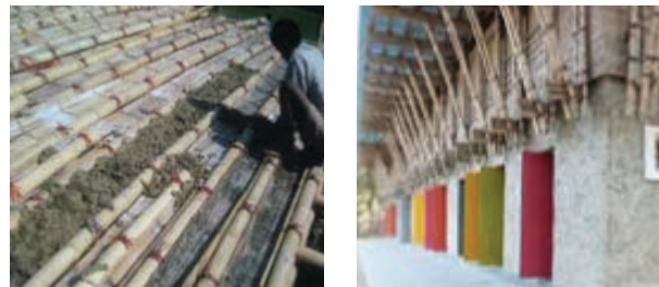
Imagen 39 - 40. Utilización de tierra en paredes y techos.
