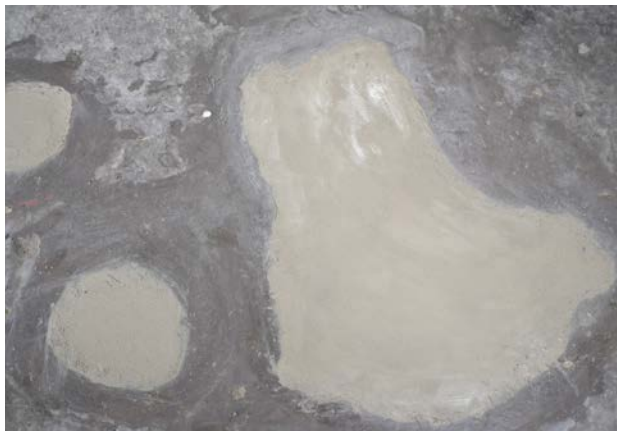
Imagen 136. Curado de piso con mezcla de prototipo diseñada por Flores, C. & Delgado, K. 2017.
