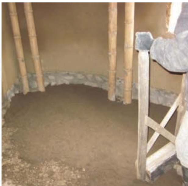
Imagen 62. Compactación del piso con herramienta manual por Bustos, V.
