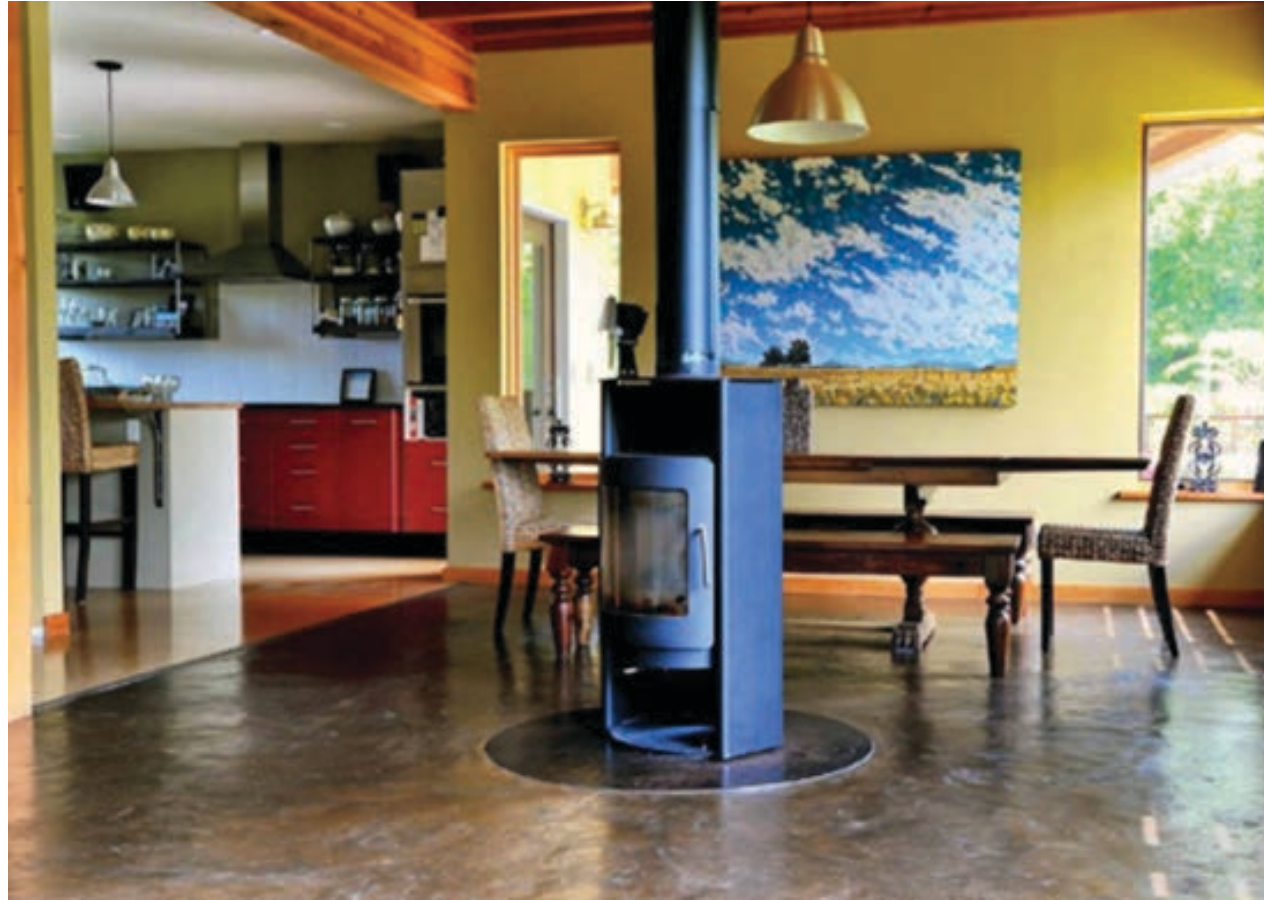
Imagen 20. Pisos colocados en Óregon por Stebivka, M.(2014). Recuperado de: Earthen Floors por Thomson, J. & Reay, S (2014).
