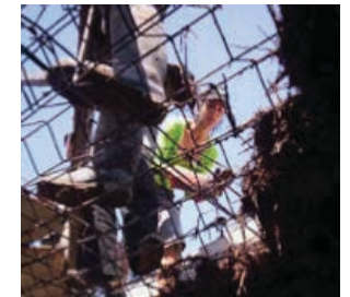
Imagen 50. Construcción con mallas, Chile.
