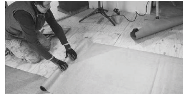
Imagen 67. Colocación de un aislante térmico. Reay & Thomson, 2014.
