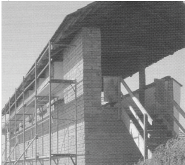
Imagen 03. Reconstrucción de un muro de adobe del siglo 6 a. D., Heuneburg, Alemania, Recuperado de: Minke G., 2005.
