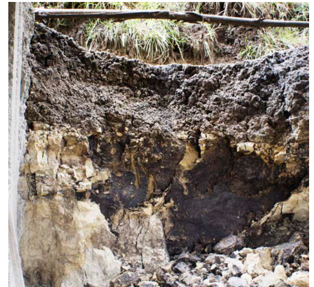
Imagen 141. Calicata de extracción del material por Flores, C. 2017.
