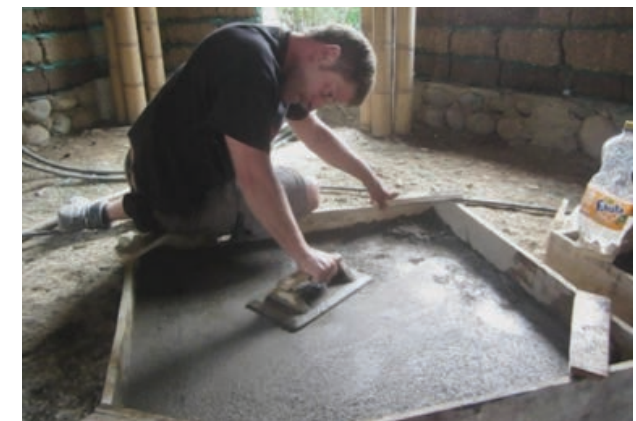
Imagen 65. Prueba 06 para la colocación del piso.
