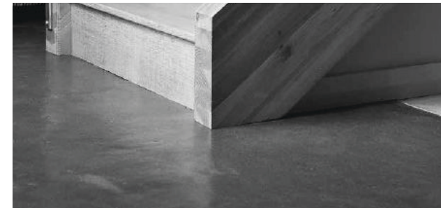
Imagen 100. Piso de tierra colocado en área social. Recuperado de: Earthen Floors por Thomson, J. & Reay, S (2014).
