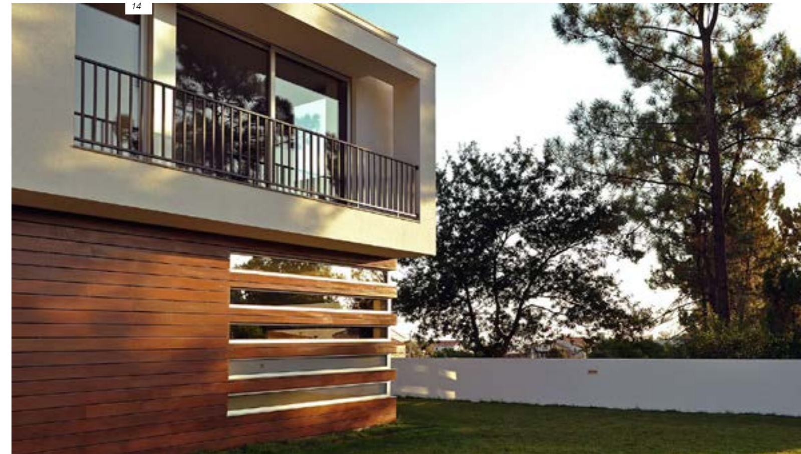
FOTO 14: Recubrimiento exterior en madera Fuente: http://www.construyehogar.com/casas/diseño-casa-cuadrada
