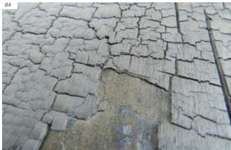
FOTO 84: Desprendimiento de carbón Fuente: Autores
