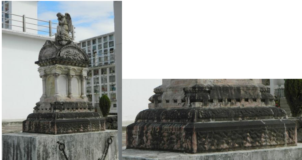
Fig. 21 Mausoleo Familia Jaramillo. Detalle de deterioro. Fuente: Autor de la tesis. 2016
