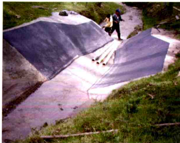
Figura 2. Aforador trapezoidal de flujo supercrítico ubicado en la Q. Turupamba del río Burgay (al momento de su construcción)
