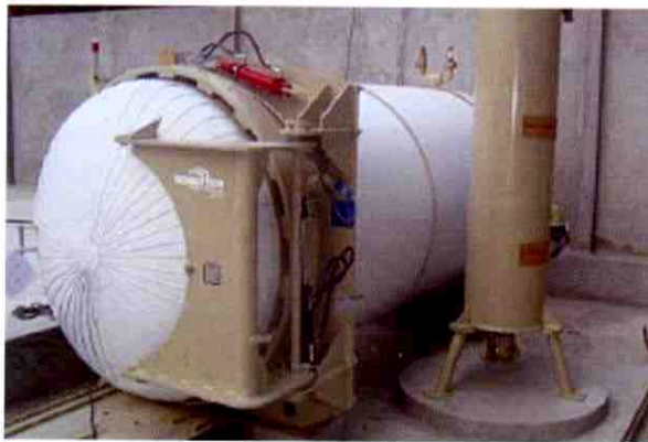
Fig. 4 Autoclave de 4 m3 de capacidad, utilizado para el tratamiento de los desechos infecciosos
