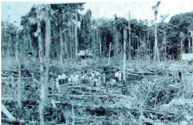
Fig. 4.12 Área desmontada en donde se ubicaría una aldea cooperativista, 1971
