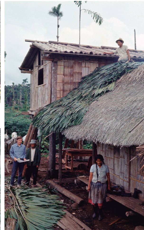
Fig. 4.14 Colocación de la cubierta de hojas de palma en la vivienda de una de las aldeas cooperativistas. Inicios de la década de 1970
