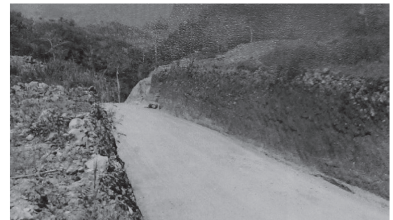
Fig 3.4 Tramo de la carretera hacia Méndez: Km 42-43, 1971
