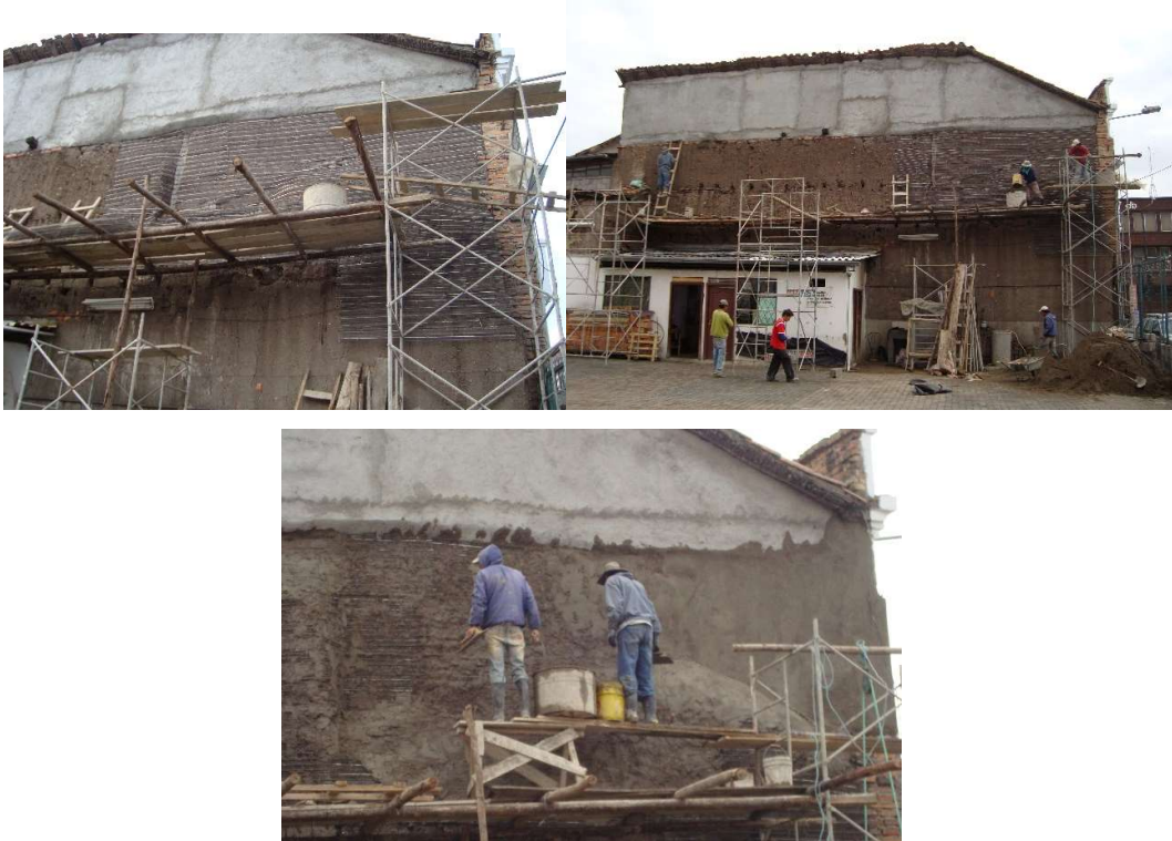
fig. 13 Rehabilitación Arquitectónica Estructural: refuerzo con mallas.
