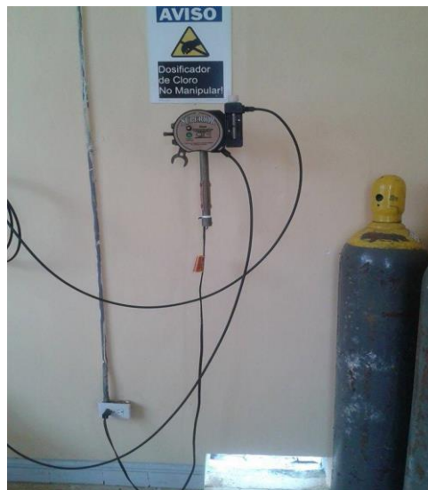
Figura 7 Dosificador de cloro gaseoso empleado en la desinfección del agua en la Planta de tratamiento "Uchupucún". Fuente: Autora
