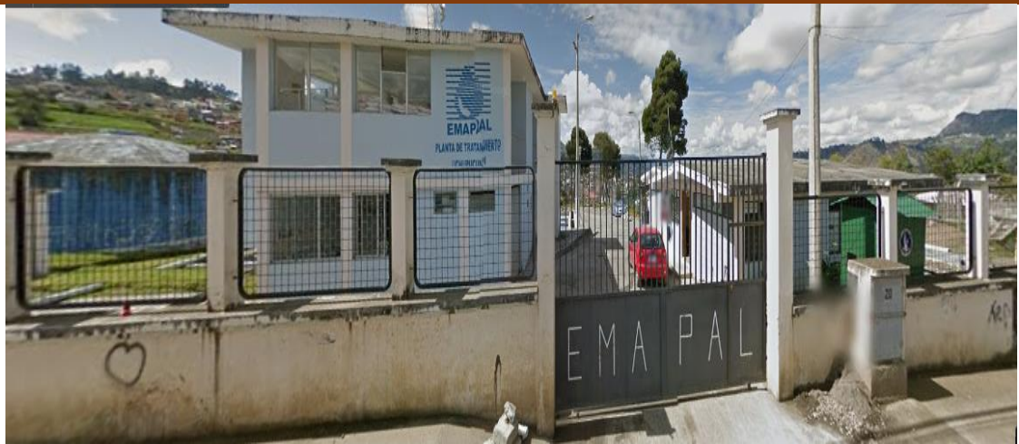
Figura 2 Planta de tratamiento de agua "Uchupucún". Fuente: Autora
