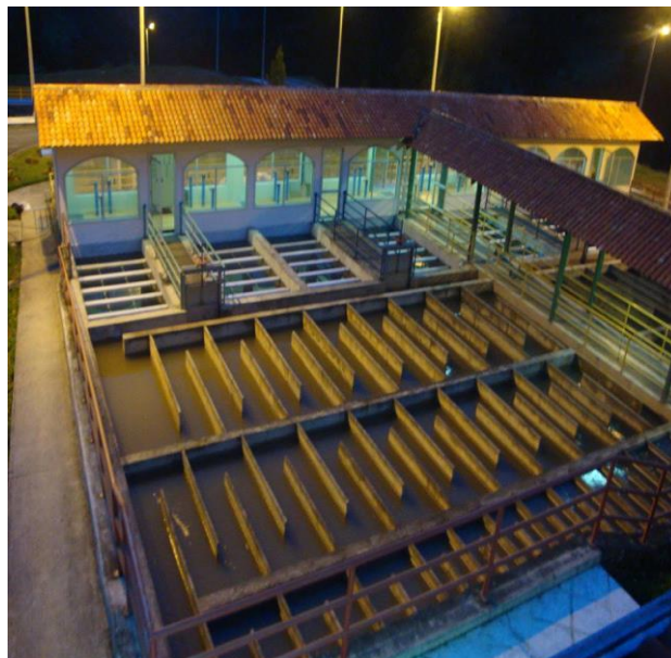
Figura 8 Planta de tratamiento de agua "Mahuarcay".
