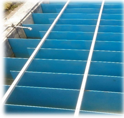
Figura 4 Floculadores de la Planta de tratamiento "Uchupucún". Fuente: Autora Sedimentadores: Se dispone de cuatro, de placas paralelas de flujo ascendente con una tasa superficial de diseño de 130 \text{ m}^3/\text{m}^2/\text{día} .
