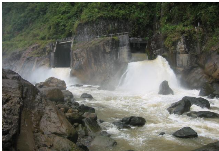
Foto 6: Túneles de descarga de la Fase AB y C hacia el Río Paute
