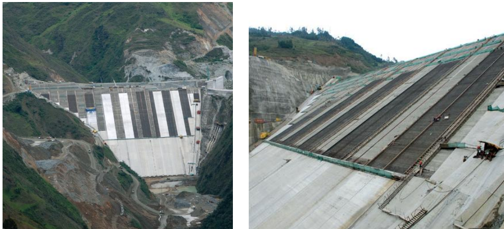
Foto 7: Construcción de la Presa de Mazar
