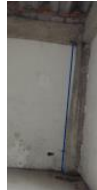
Fotos 55 y 56. Columna con acero de refuerzo visible y columna con deficiencia de aplome.
