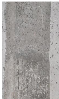
Foto 57 y 58. Reducción de sección y presencia de vegetación.
