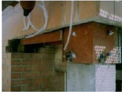
Fotos 44 y 45. El incremento de la capacidad portante mediante pletinas metálicas o fibras de carbono se ha convertido en una de las actuaciones de refuerzo más frecuentes [Fotografías de Paulo Helene].
