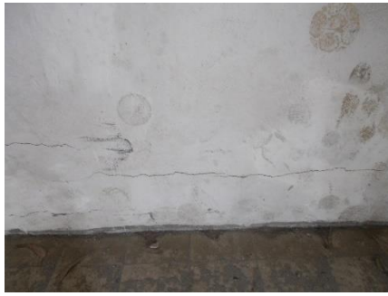
Fotos 59 y 60. Fisuras horizontales y cambio de color en varias zonas de las vigas de hormigón armado.
