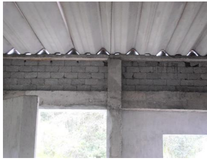
Fotos 59 y 60. Fisuras horizontales y cambio de color en varias zonas de las vigas de hormigón armado.
