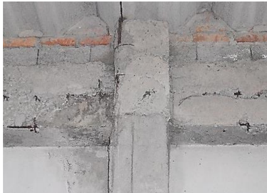
Fotos 55 y 56. Columna con acero de refuerzo visible y columna con deficiencia de aplome.
