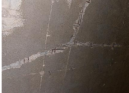
Foto 64. Armadura inferior de la losa de entrepiso.
