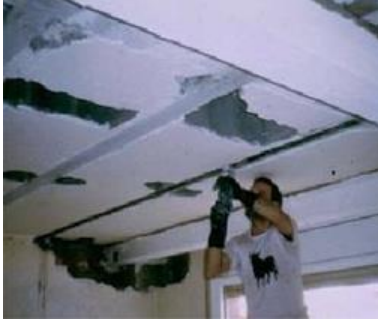
Fotos 44 y 45. El incremento de la capacidad portante mediante pletinas metálicas o fibras de carbono se ha convertido en una de las actuaciones de refuerzo más frecuentes [Fotografías de Paulo Helene].
