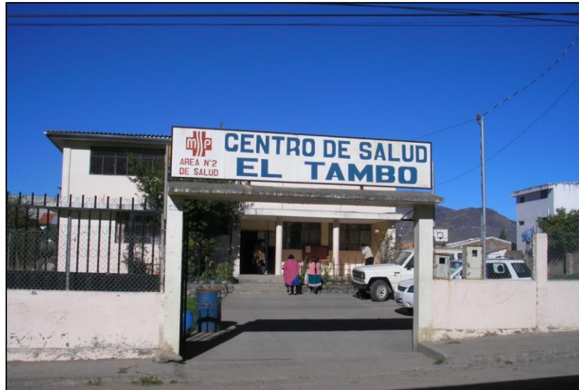
Ilustración 2-3 Vista panorámica del Centro de Salud EL Tambo
