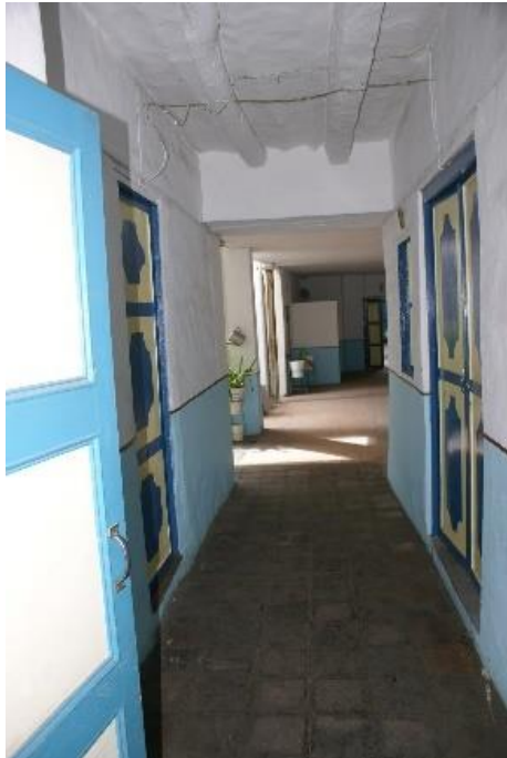
Figura 23 Vistas de interior del Monasterio
