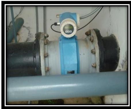
Fig. 2.3.1. Caudalímetro electrónico rectangular
