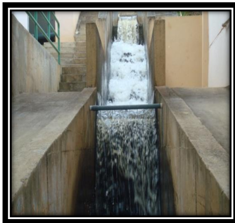
Fig. 2.4.1. Resalto hidráulico dosificadora
