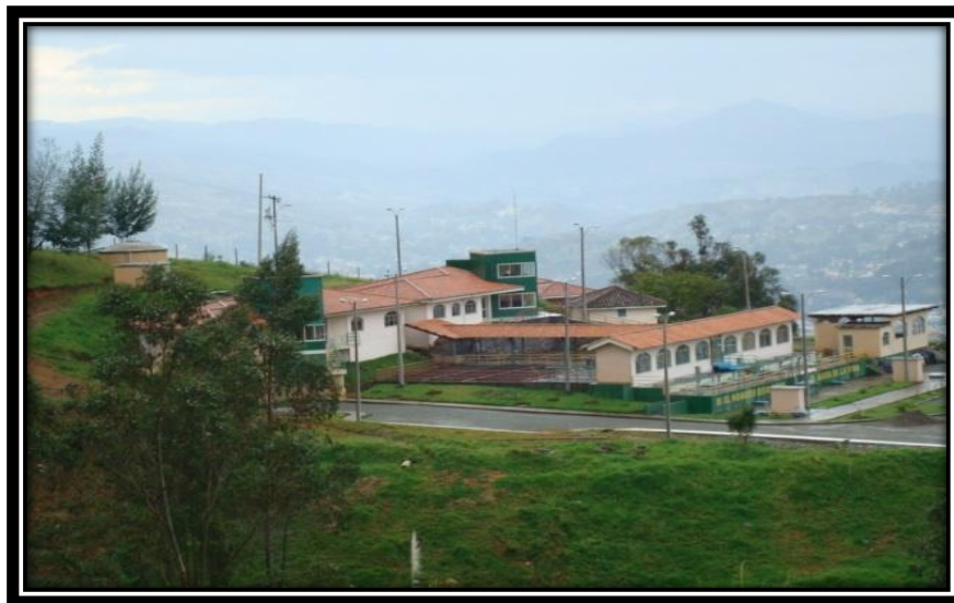
Fig. 2.1. Planta de Tratamiento de Agua Potable “Mahuarca”
