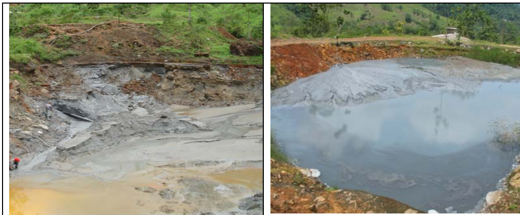
Foto 12.- Piscina de almacenamiento de arenas para Foto 13.- Piscina de almacenamiento de relaves
