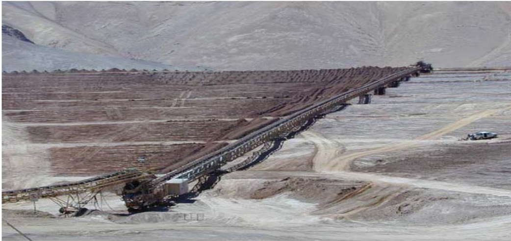
Foto 1.- Disposición de relaves filtrados
