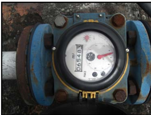
Fig. 17. Medidor de agua antiguo
