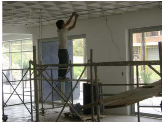
Imagen 4.5. Conexiones eléctricas
