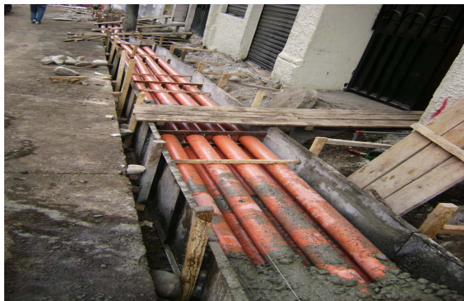
Imagen.4.20. Colocación de tubos.
