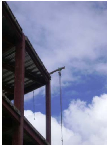
Imagen 4.7. Elevación por polea.
