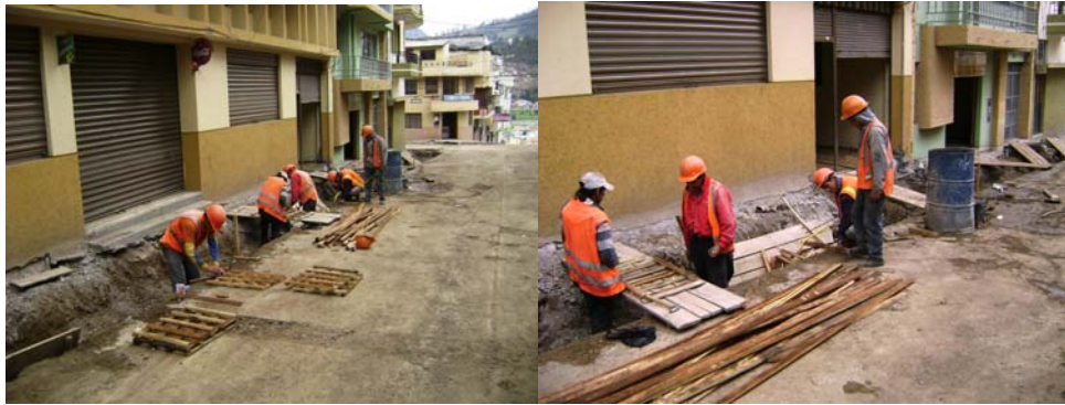
Imagen 4.19. Armado de ductos.
