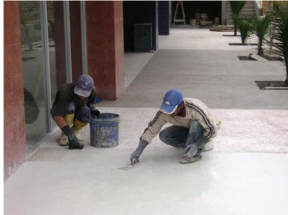
Imagen 4.11. Acabado de pisos
