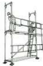
Figura 10. Montaje del resto del andamio
