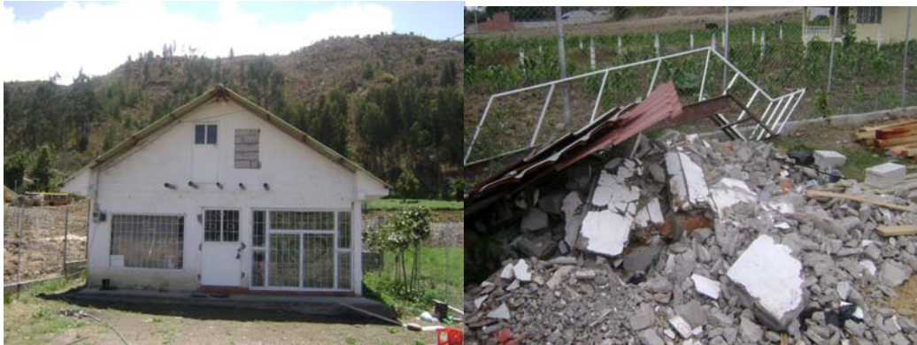
Imagen 4.22. Construcción original y escombros de demolición
