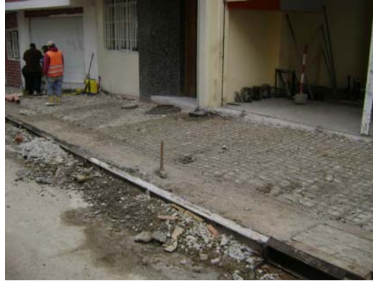
Imagen 4.21. Fundición de vereda y/o calle
