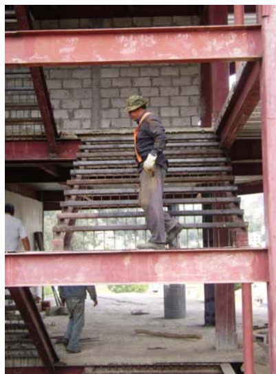
Imagen 4.6. Elevación y transporte manual por gradas.
