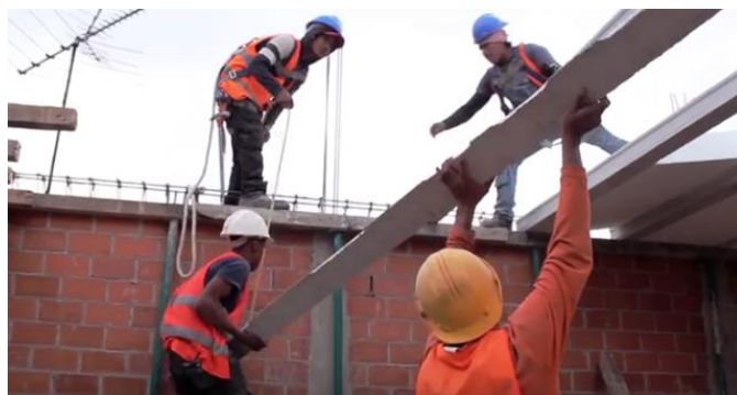
Figura 48: Obreros colocando manualmente las vigas pretensadas. Fuente: PREMEX.
