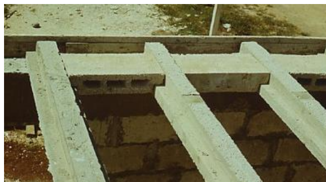
Figura 8: Solución Constructiva Vigueta-Bovedilla emplazada en obra. Se usan vigas de hormigón armado y las bovedillas de suelo-cemento. Fuente: Ing. Nelson Navarro, Ph.D.
