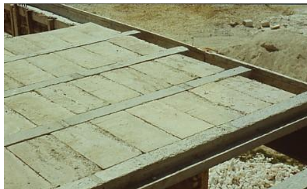
Figura 13: Solución Vigueta-Bovedilla emplazada en obra, previo a colar la carpeta de hormigón armado. Fuente: Ing. Nelson Navarro. Ph.D.
