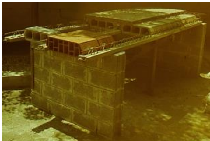
Figura 7: Exposición de diferentes soluciones de Bovedillas sobre semi viguetas de hormigón armado, CTVU, Cuba. Fuente: Ing. Nelson Navarro, Ph.D.
