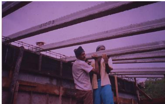
Figura 45: Personal levantando una viga. Ing. Nelson Navarro Campos. Ph.D.
