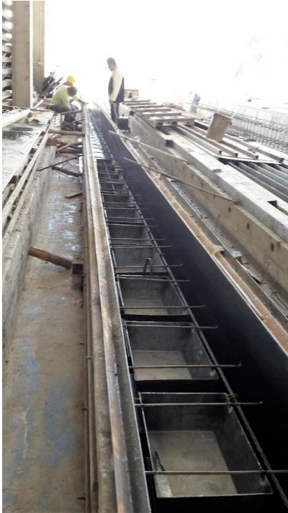
Colocación de los cofres superiores
