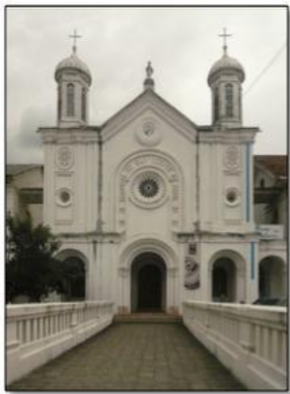
Imagen No. 13: Capilla del Antiquo Hospital San Vicente de Paúl. Fuente: INPC Regional 6.
