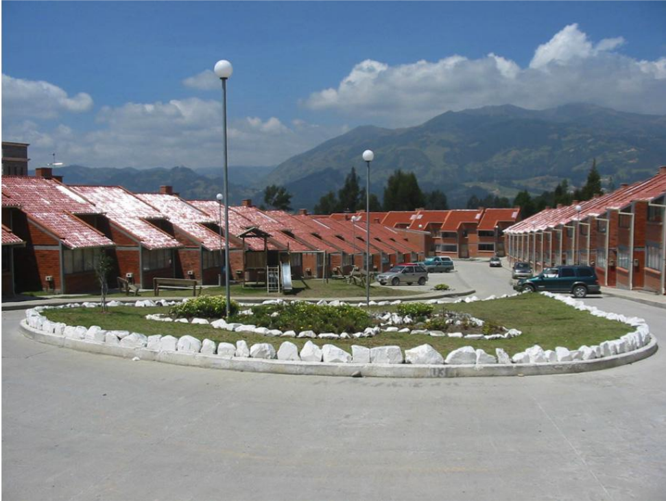
Figura 3.49 - Fotografía del estado de construcción Fuente: Arq. Hernán Córdova
