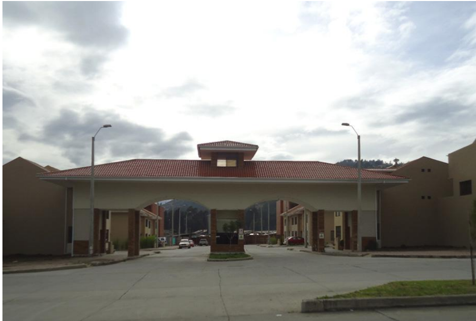
Figura 3.192 - Fotografía del estado de construcción Fuente: Arq. Hernán Córdova
