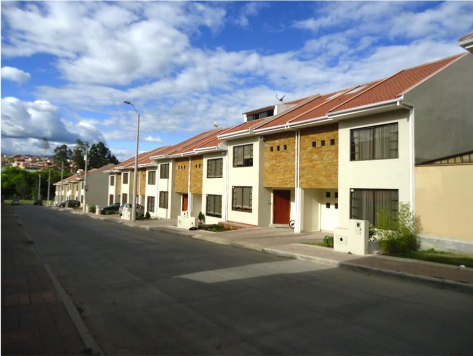
Figura 3.194 - Fotografía del estado de construcción Fuente: Arq. Hernán Córdova
