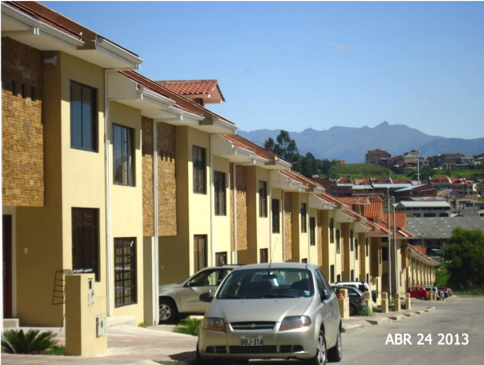
Figura 3.186 - Fotografía del estado de construcción Fuente: Arq. Hernán Córdova, 2013
