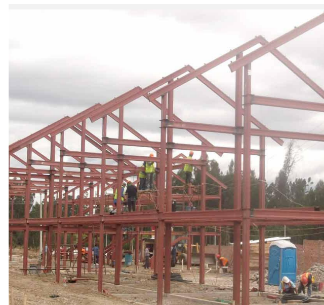
Figura 3.11 - Construcción de viviendas modulares Fuente: Empresa Municipal de Urbanización y Vivienda, 2016
