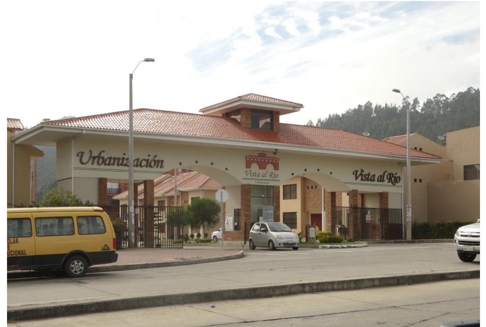
Figura 3.193 - Fotografía del estado actual
