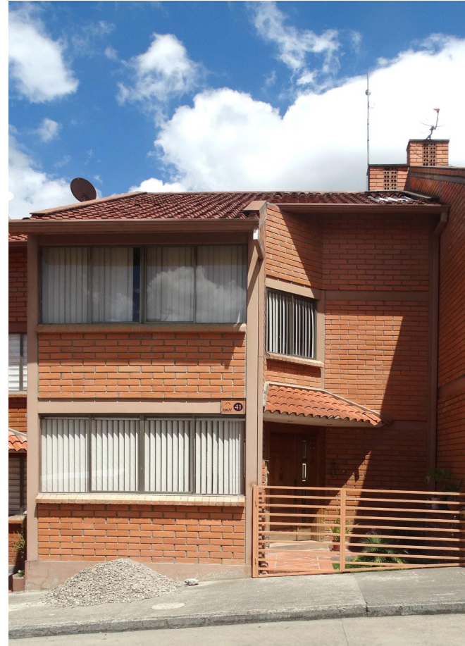
Figura 3.62 - Fotografía del estado actual
