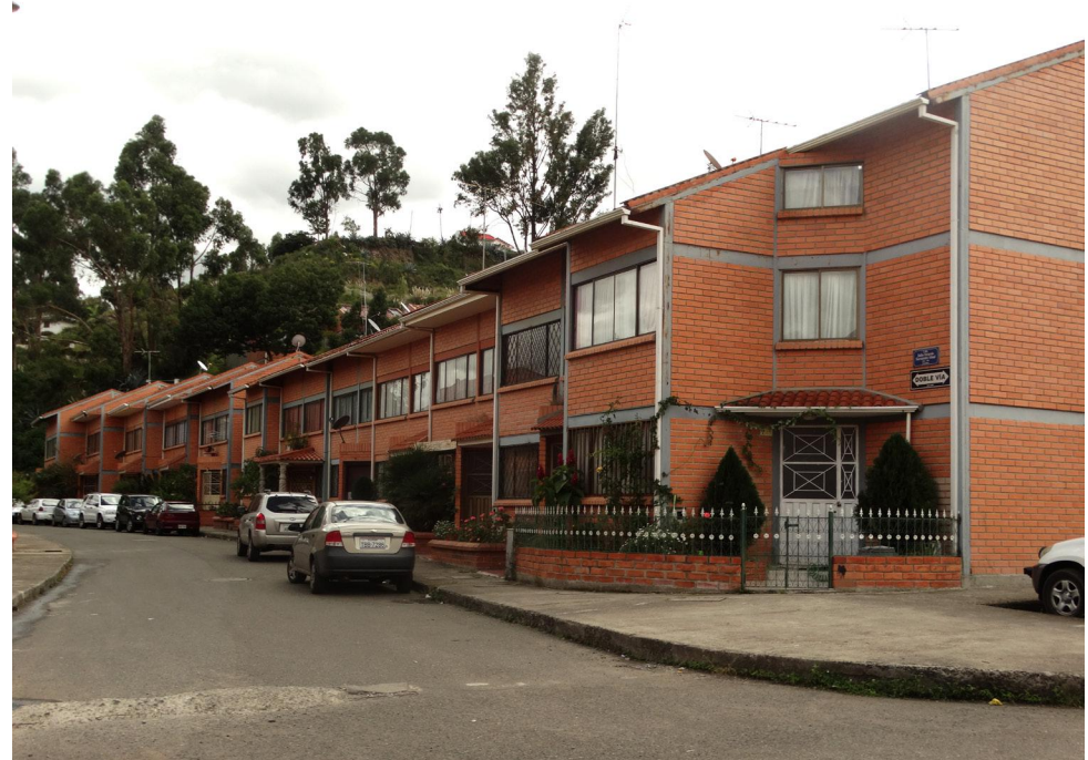
Figura 3.128 - Fotografía del estado actual
