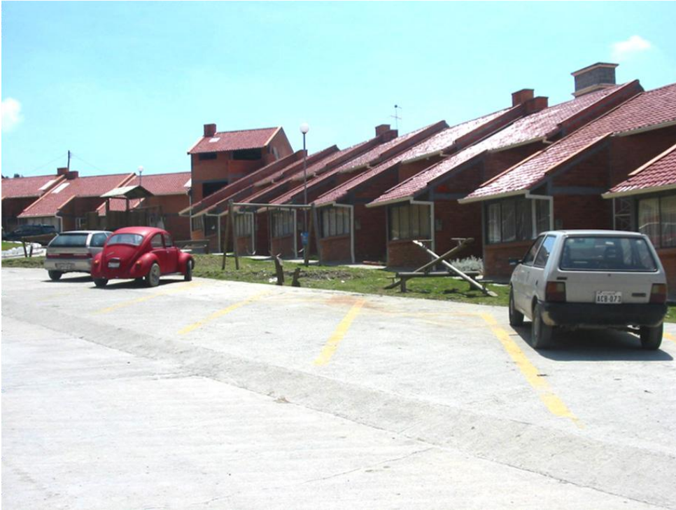
Figura 3.65 - Fotografía del estado de construcción Fuente: Arq. Hernán Córdova
