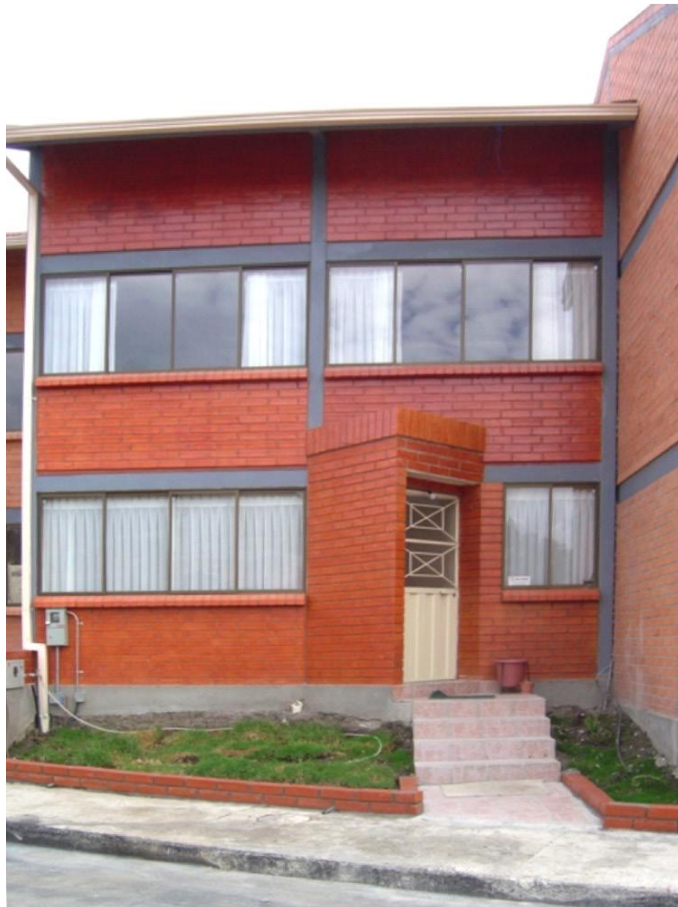
Figura 3.133 - Fotografía del estado de construcción Fuente: Arq. Hernán Córdova
