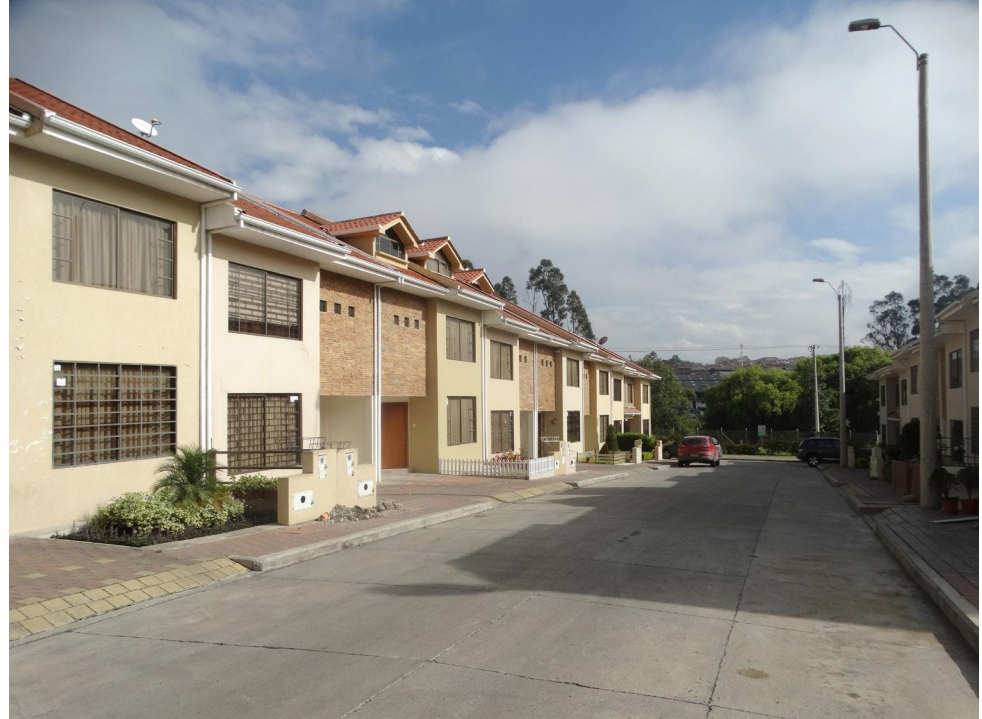
Figura 3.195 - Fotografía del estado actual
