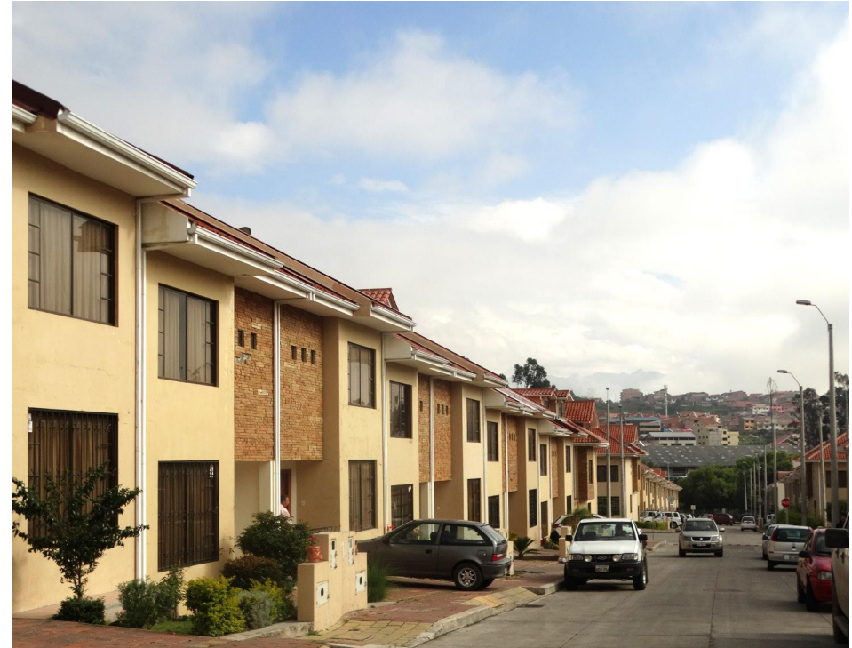
Figura 3.187 - Fotografía del estado actual
