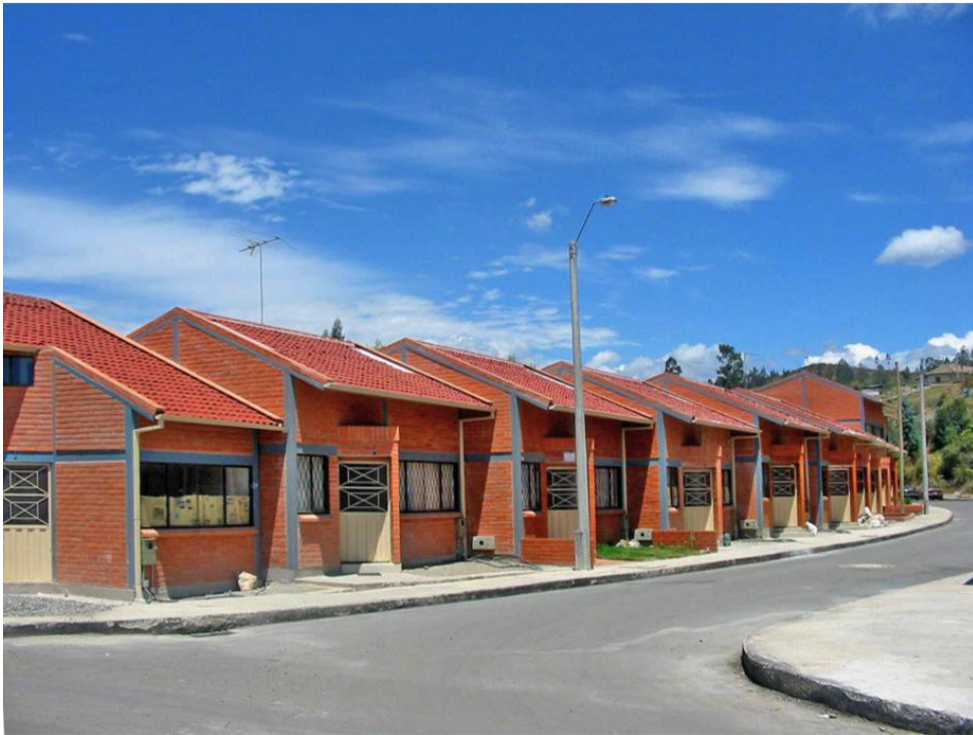
Figura 3.135 - Fotografía del estado de construcción Fuente: Arq. Hernán Córdova
