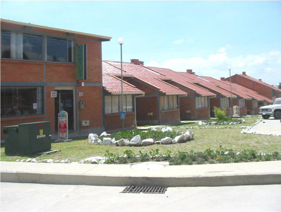
Figura 3.53 - Fotografía del estado de construcción Fuente: Arq. Hernán Córdova
