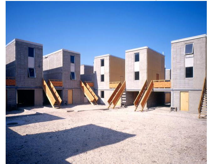
Figura 1.19 - Conjunto de 93 viviendas incrementales Fuente: CNCA, Sergio López, Hyatt Foundation, Víctor Oddó, 2016
