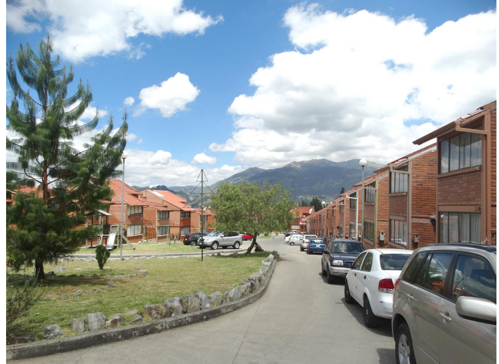
Figura 3.70 - Fotografía del estado actual
