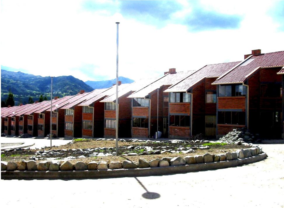
Figura 3.69 - Fotografía del estado de construcción Fuente: Arq. Hernán Córdova
