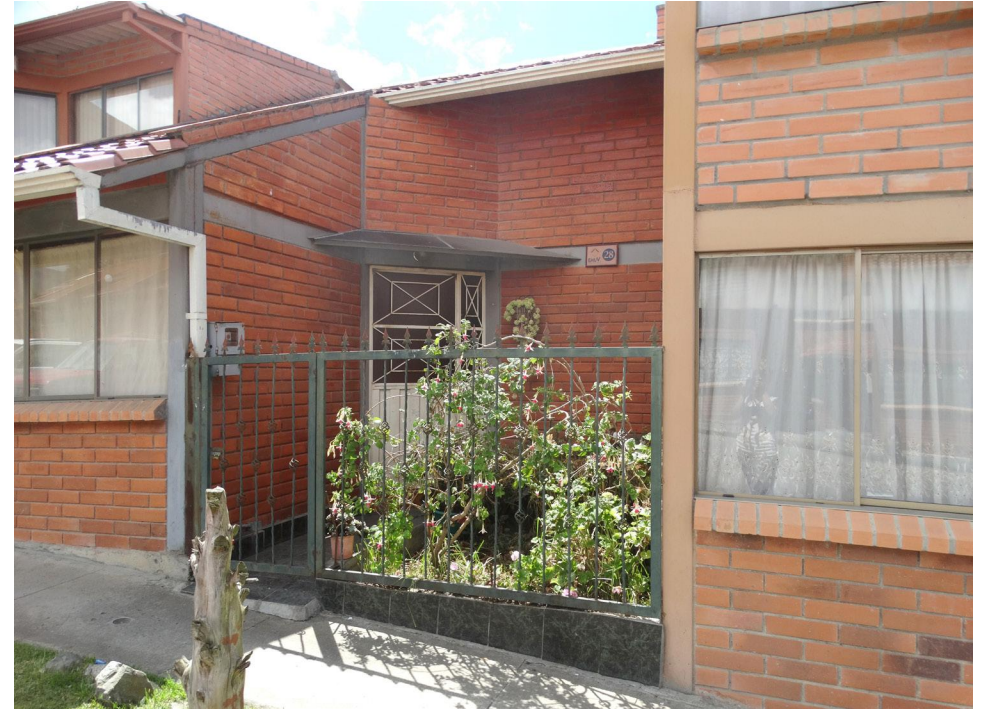
Figura 3.68 - Fotografía del estado actual
