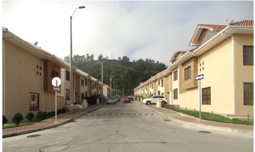
Figura 3.191 - Fotografía del estado actual
