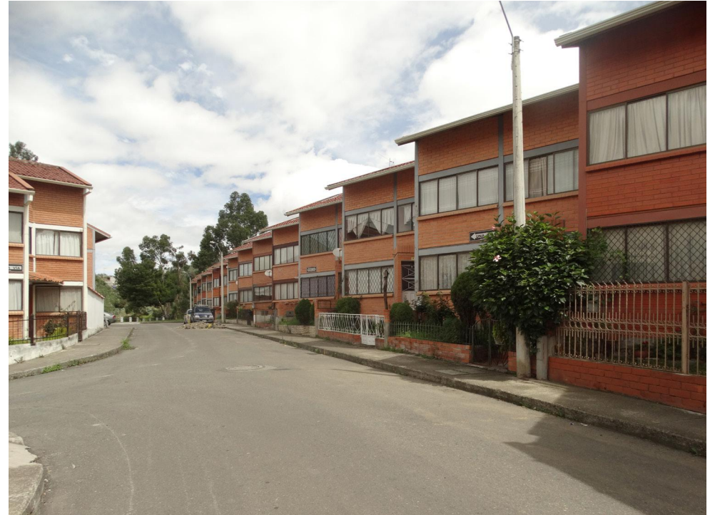
Figura 3.130 - Fotografía del estado actual
