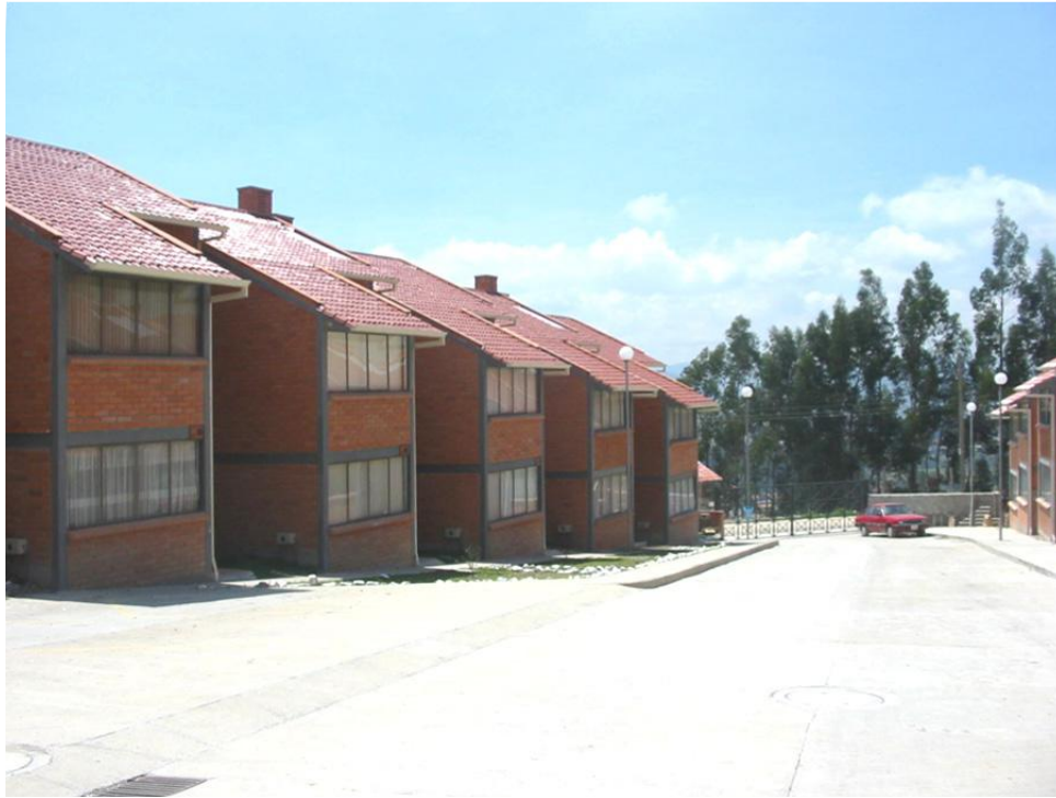
Figura 3.57 - Fotografía del estado de construcción Fuente: Arq. Hernán Córdova
