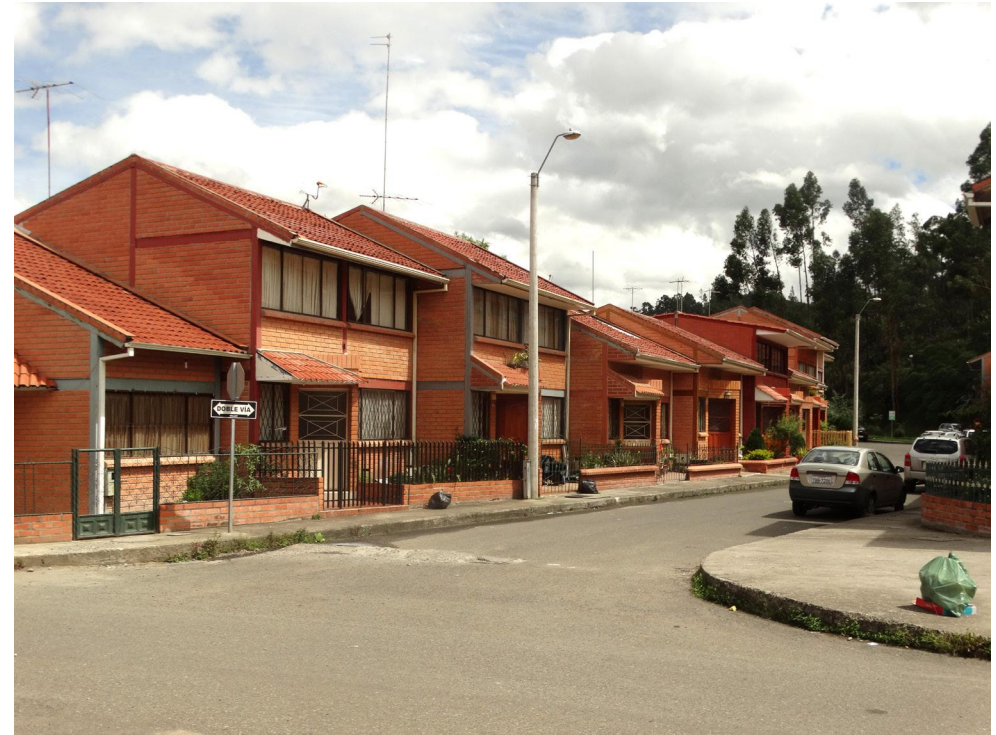
Figura 3.136 - Fotografía del estado actual
