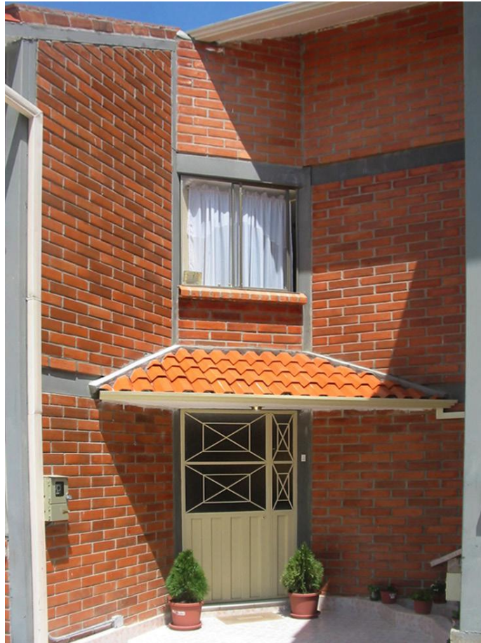
Figura 3.59 - Fotografía del estado de construcción Fuente: Arq. Hernán Córdova
