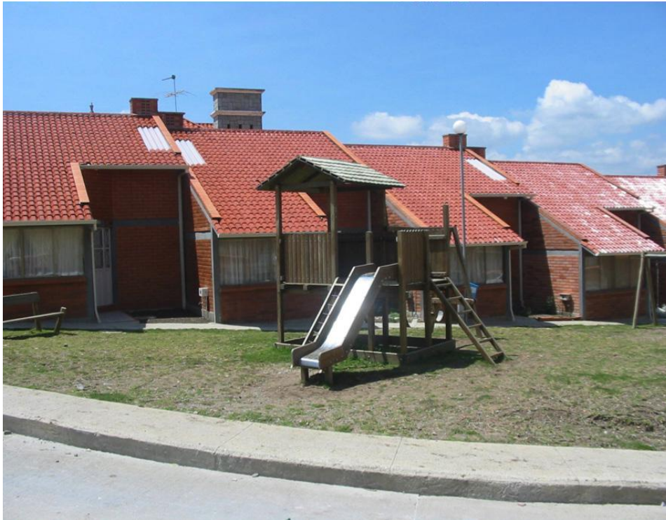
Figura 3.51 - Fotografía del estado de construcción Fuente: Arq. Hernán Córdova
