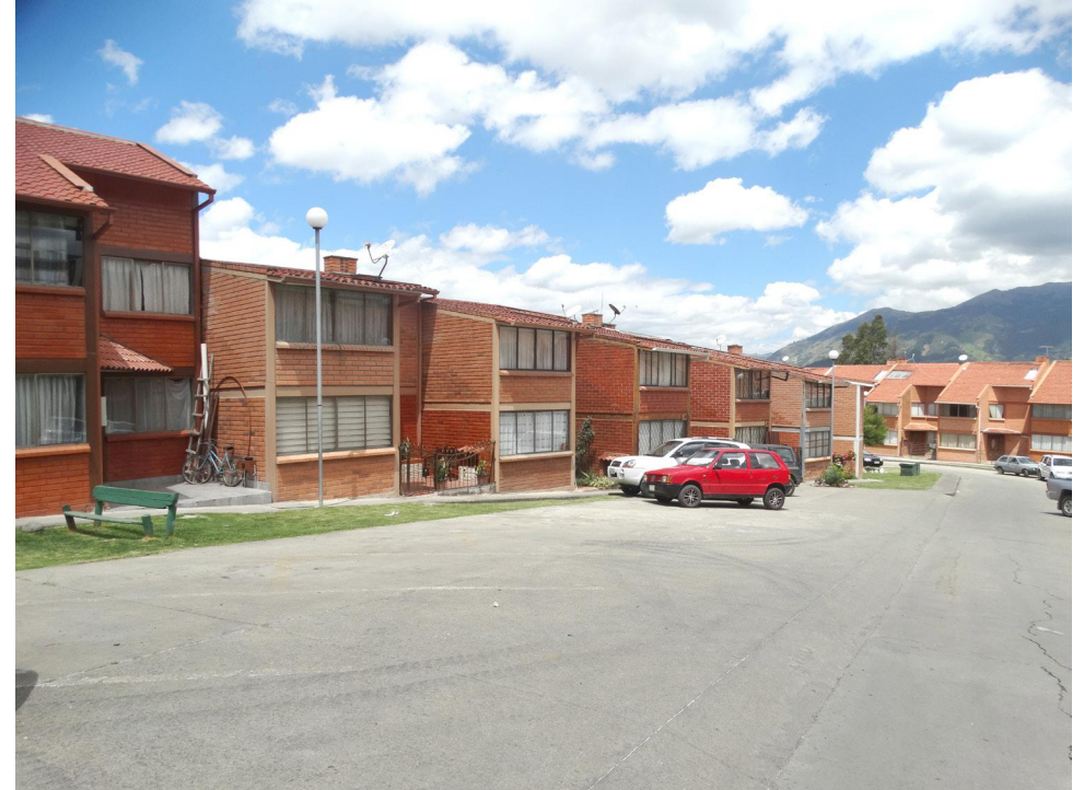
Figura 3.72 - Fotografía del estado actual
