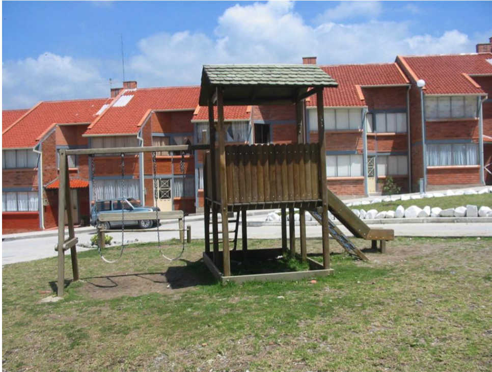
Figura 3.63 - Fotografía del estado de construcción Fuente: Arq. Hernán Córdova
