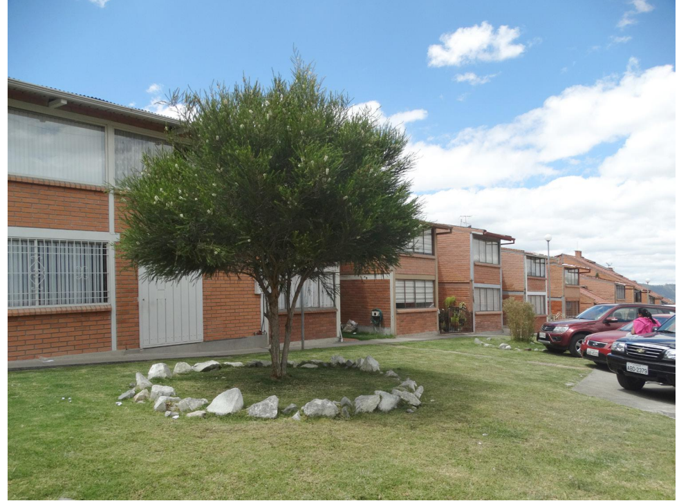
Figura 3.54 - Fotografía del estado actual
