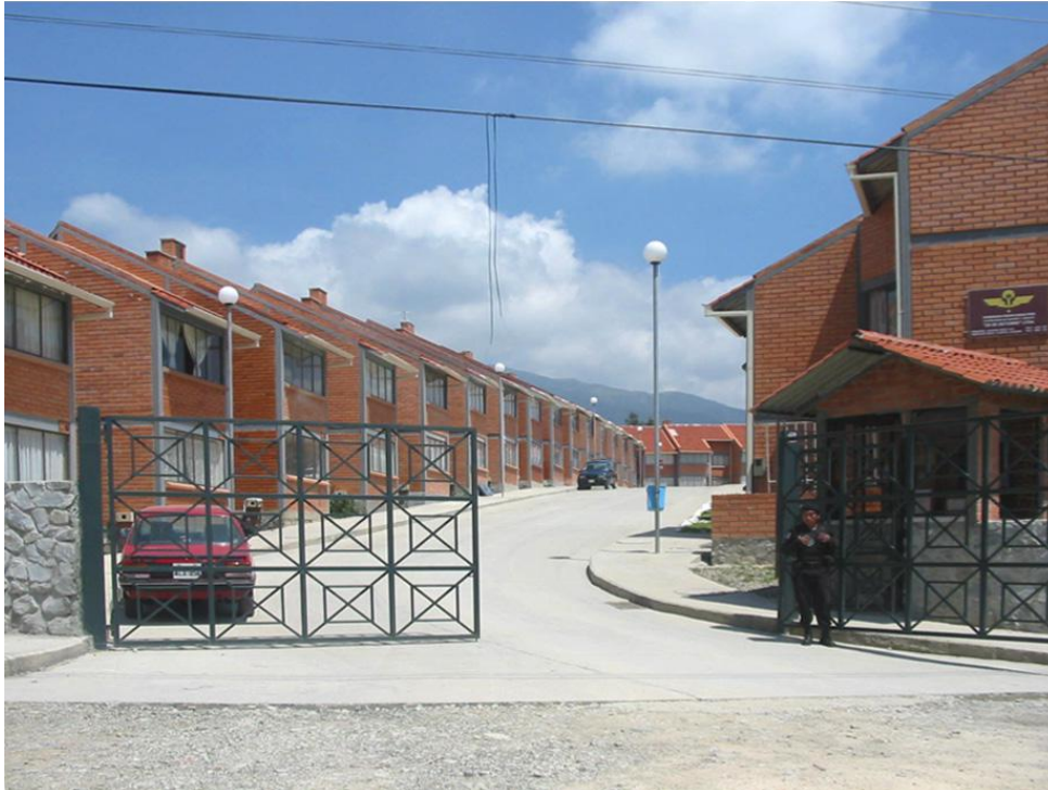
Figura 3.55 - Fotografía del estado de construcción Fuente: Arq. Hernán Córdova
