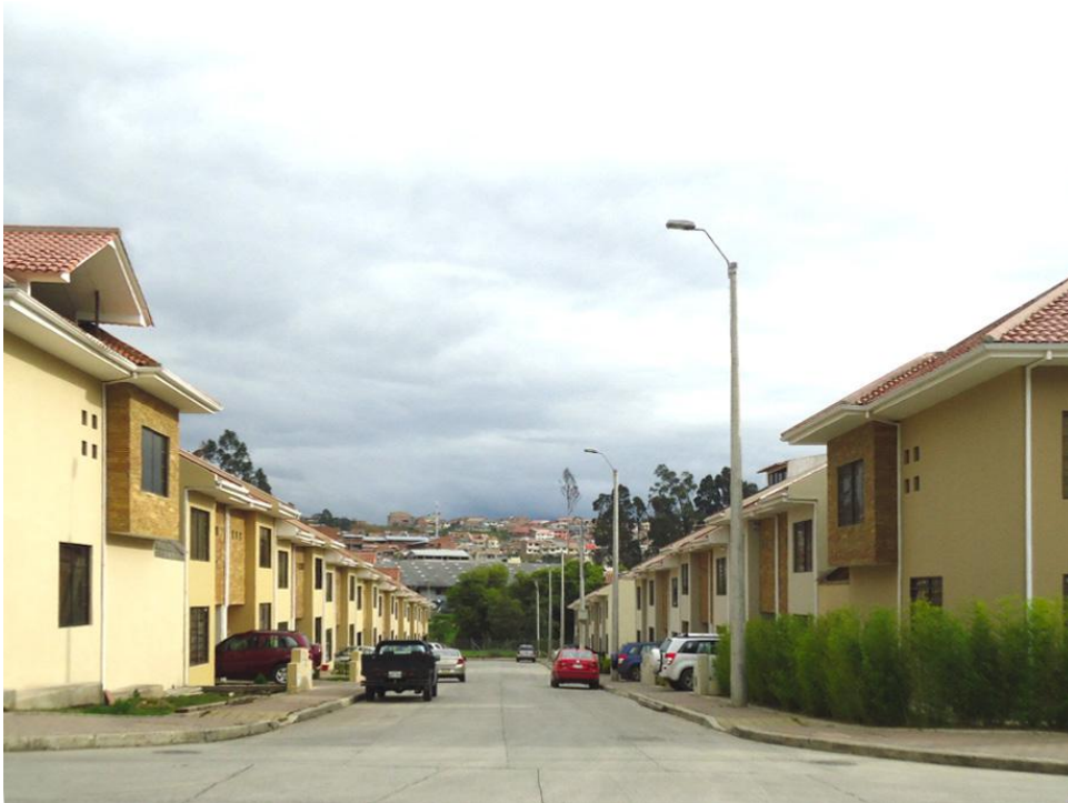
Figura 3.188 - Fotografía del estado de construcción Fuente: Arq. Hernán Córdova
