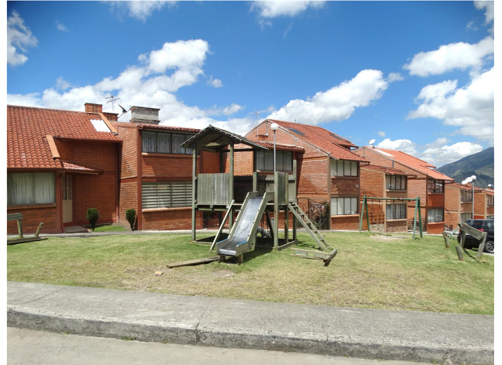
Figura 3.52 - Fotografía del estado actual
