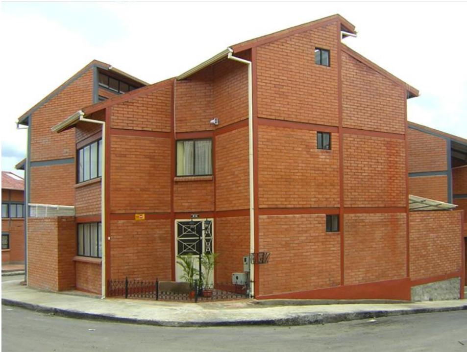
Figura 3.131 - Fotografía del estado de construcción Fuente: Arq. Hernán Córdova
