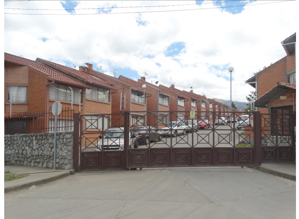
Figura 3.56 - Fotografía del estado actual
