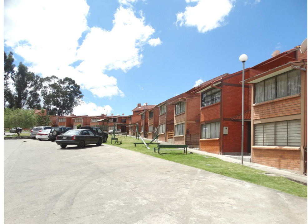
Figura 3.66 - Fotografía del estado actual
