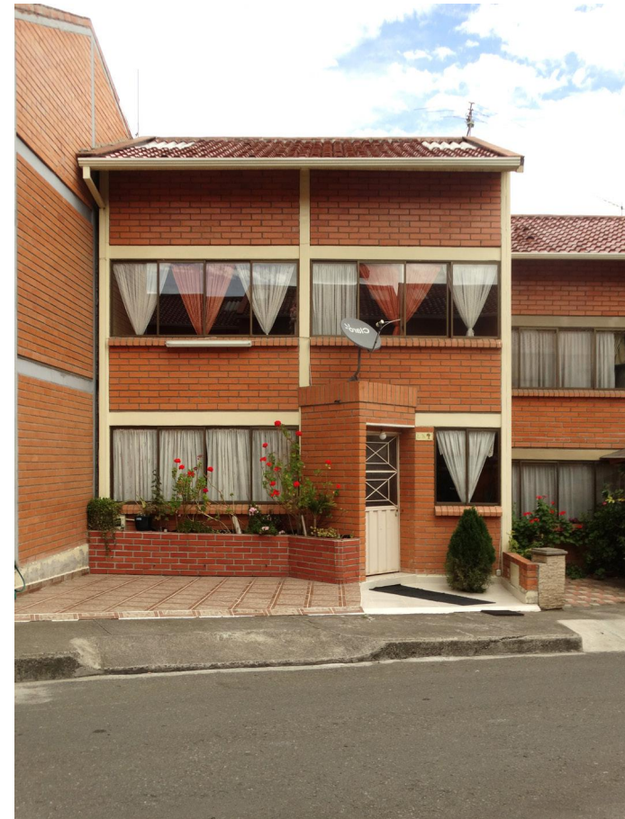
Figura 3.134 - Fotografía del estado actual
