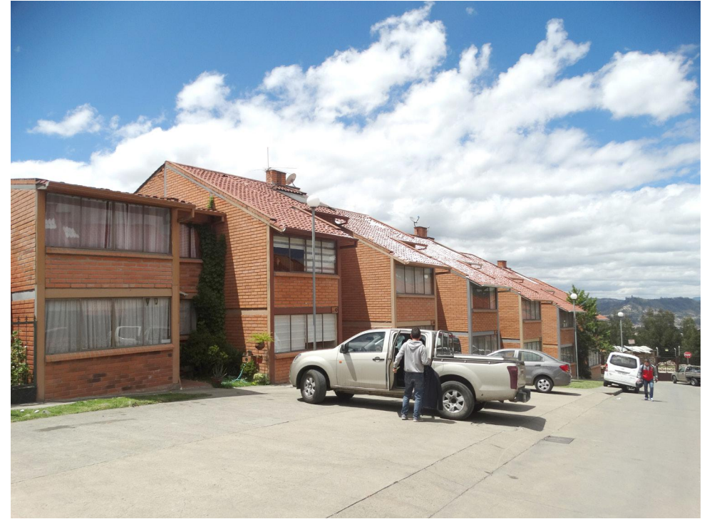
Figura 3.58 - Fotografía del estado actual
