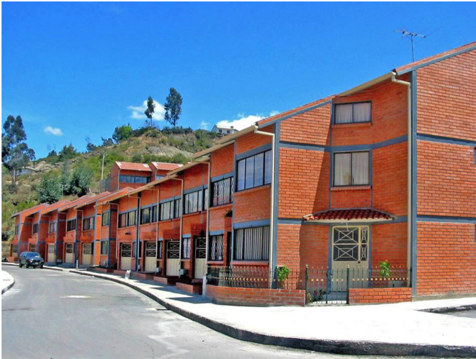
Figura 3.127 - Fotografía del estado de construcción Fuente: Arq. Hernán Córdova
