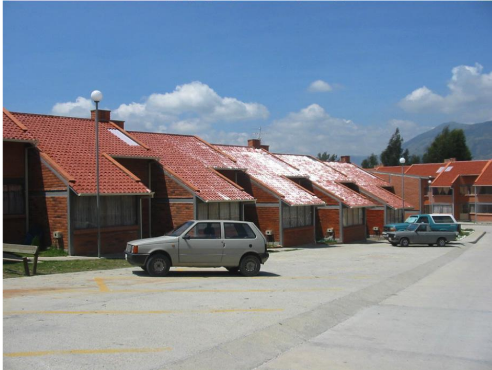
Figura 3.71 - Fotografía del estado de construcción Fuente: Arq. Hernán Córdova
