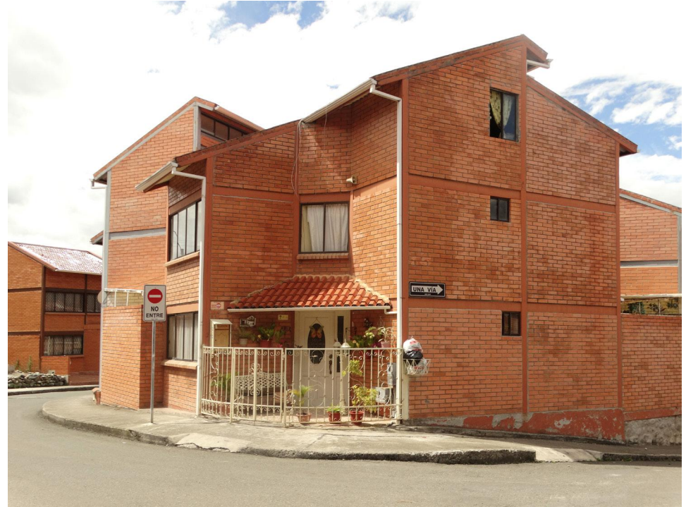
Figura 3.132 - Fotografía del estado actual
