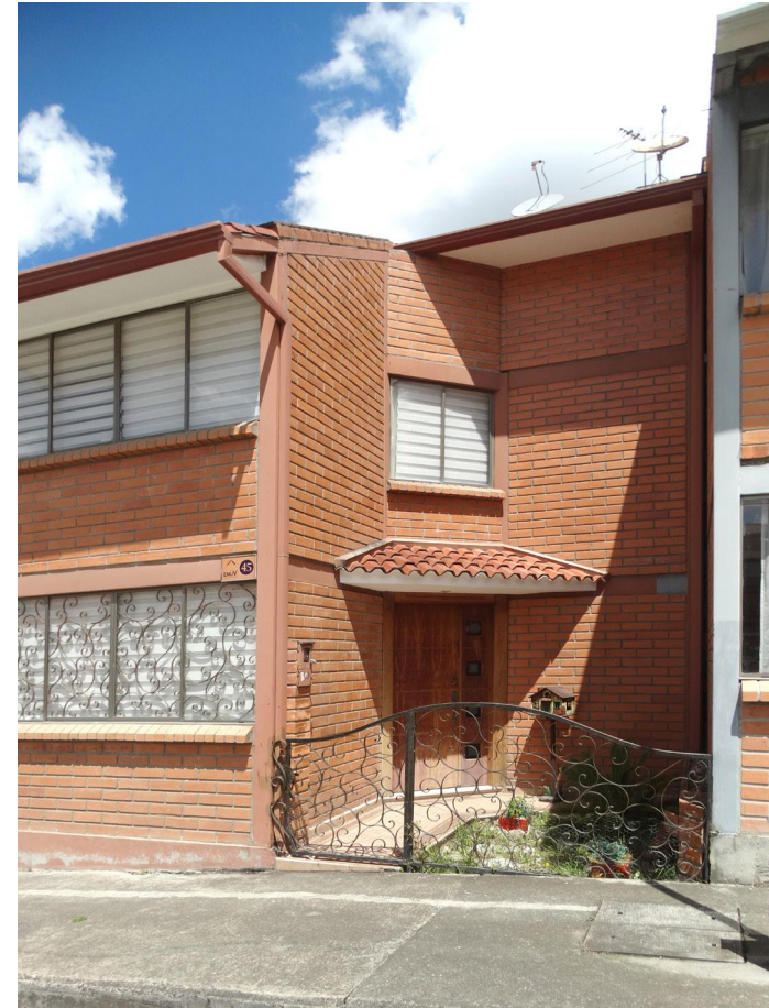
Figura 3.60 - Fotografía del estado actual
