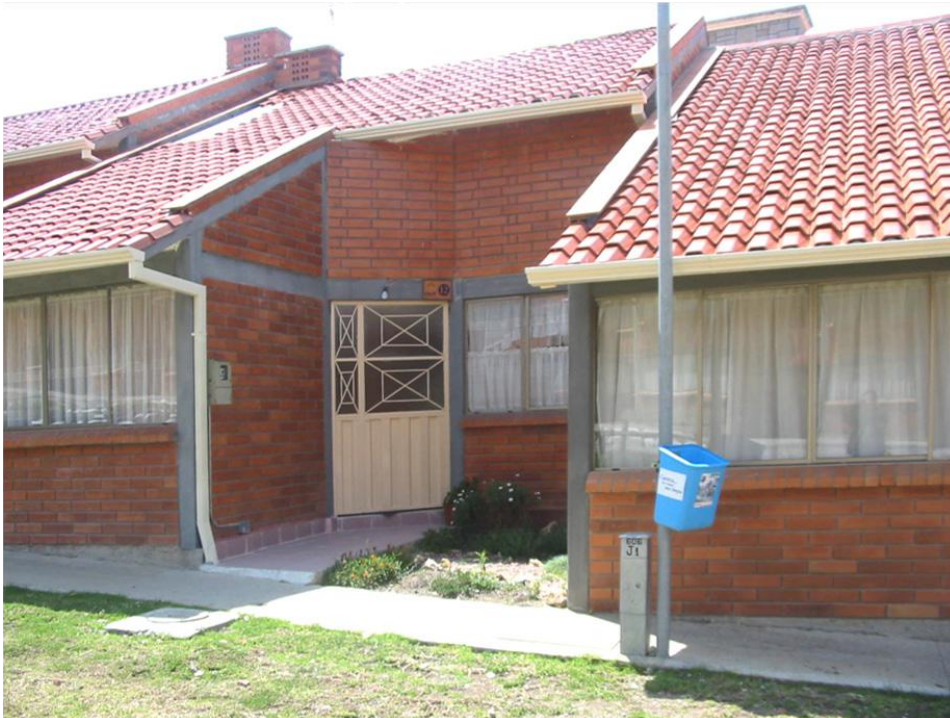
Figura 3.67 - Fotografía del estado de construcción Fuente: Arq. Hernán Córdova
