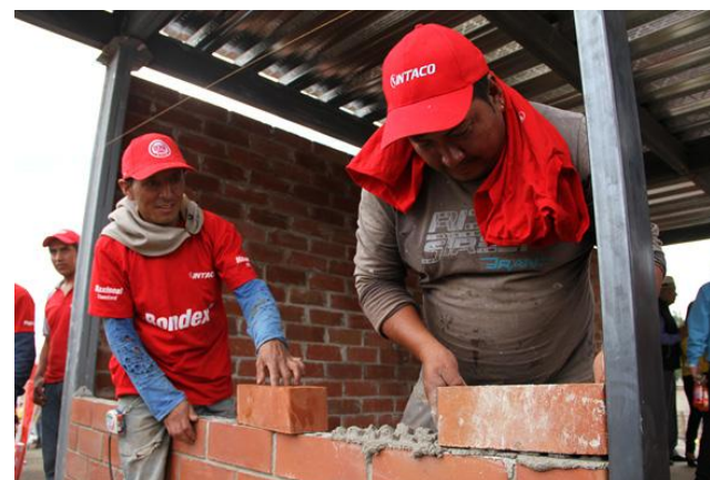
Figura 3.10 - Construcción de Viviendas Fuente: Empresa Municipal de Urbanización y Vivienda, 2016
