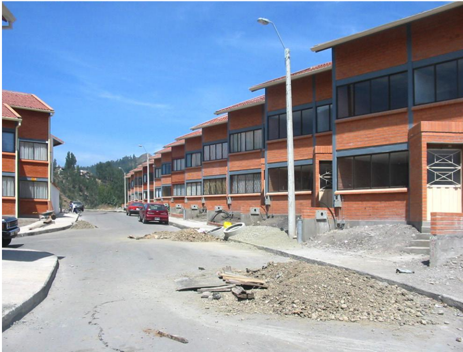
Figura 3.129 - Fotografía del estado de construcción Fuente: Arq. Hernán Córdova
