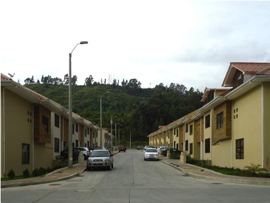
Figura 3.190 - Fotografía del estado de construcción Fuente: Arq. Hernán Córdova
