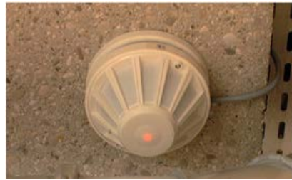
Figura 2.8. Sensor de Ocupación o de Presencia.
