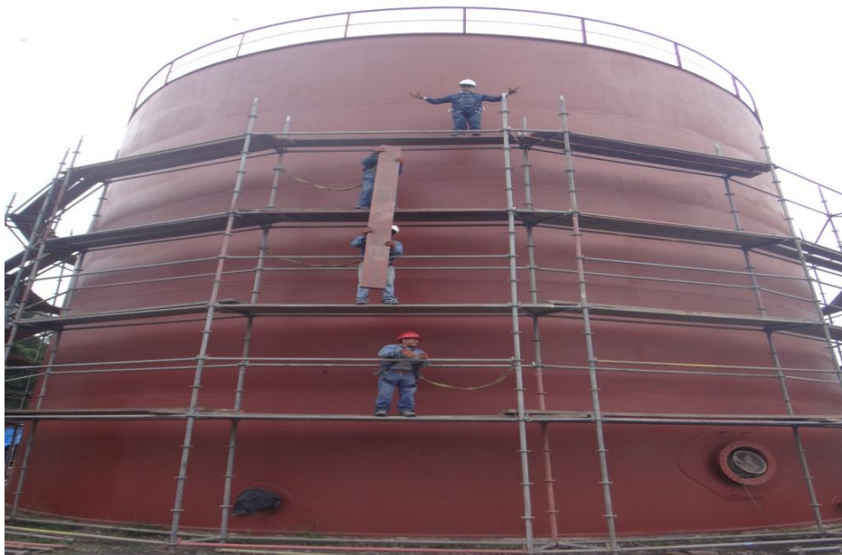
Armado de andamios alrededor de un tanque de almacenamiento de crudo
