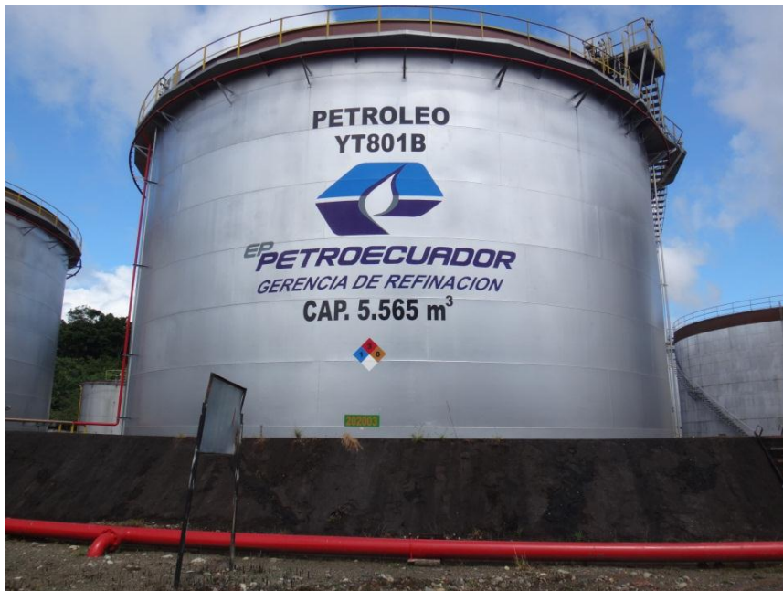
Espacio confinado cerrado
