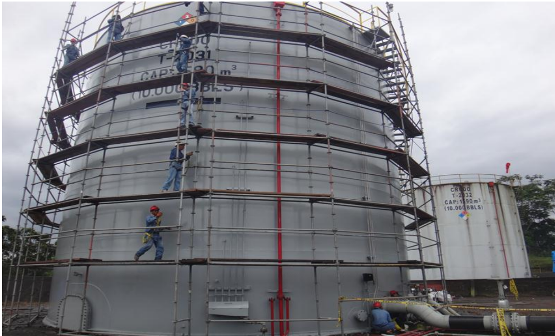
Montaje de andamios para las actividades de mantenimiento
