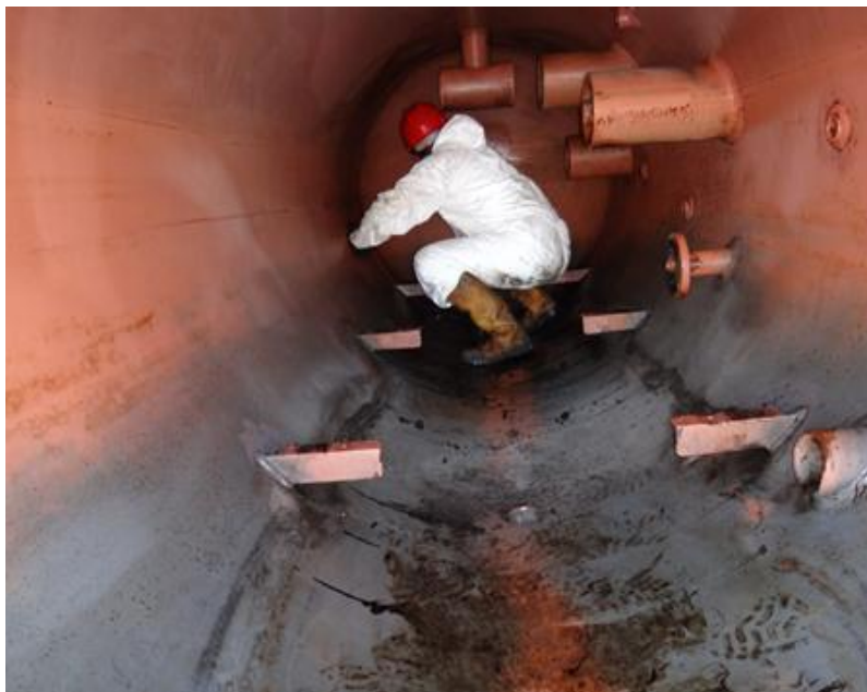
Limpieza interior de un tanque de almacenamiento de crudo
