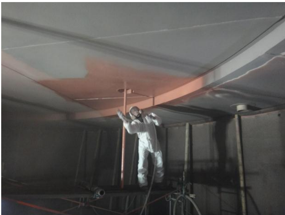
Proceso de pintura en el interior de tanque
