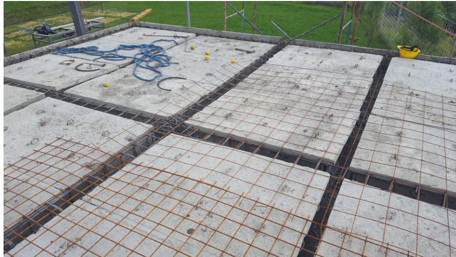
Foto. 11 Ensamblaje de paneles de losa.
