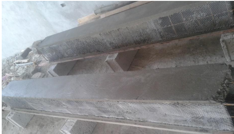
Foto. 2 Sistema de encofrado sobre armadura esquelética. (Tomado del anexo 3)
