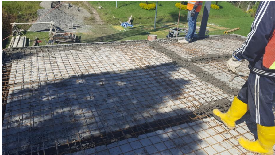
Foto. 14 Fundición de vigas.
