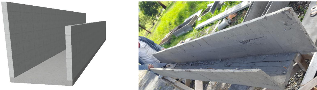
Figura. 12 Encofrado de viga perimetral
