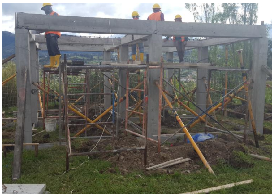
Foto. 10 Ensamblaje de vigas.
