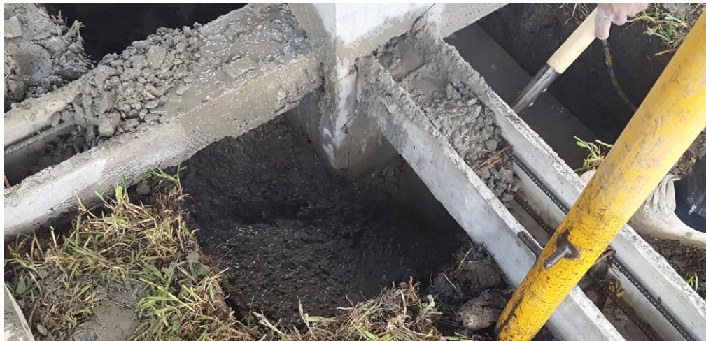
Foto. 12 Fundición de cuello, zapata y cadenas.
