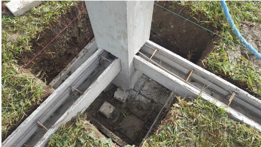
Foto. 8 Unión zapata, cadena columna del prototipo.
