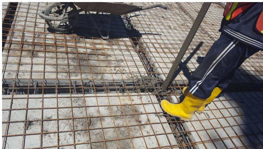
Foto. 13 Fundición de columnas.
