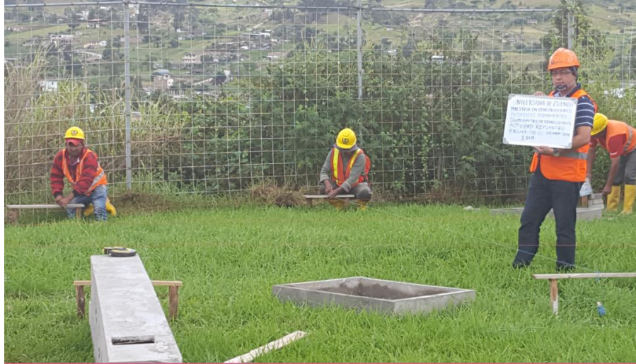
Foto. 6. Replanteo para la construcción del prototipo.
