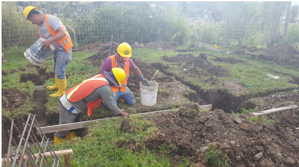
Foto. 7. Excavación para la construcción del prototipo.
