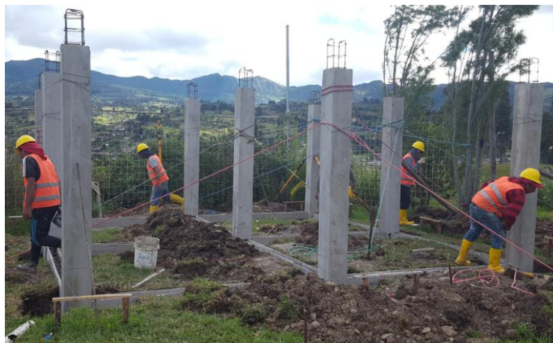
Foto. 9 Ensamblaje de zapatas, cadenas y columnas.
