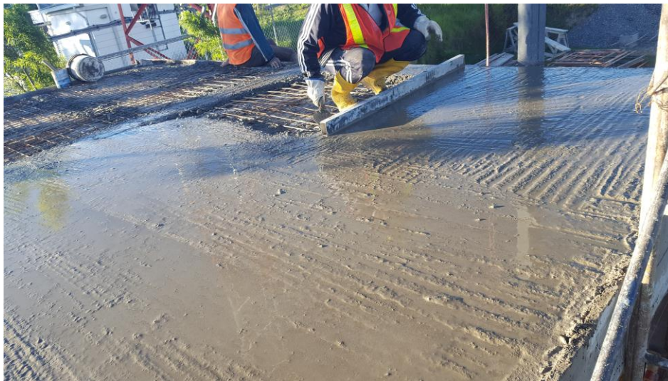
Foto. 15 Fundición de losa.
