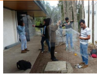
Imagen 44 Corta y arma mallas metálicas.
