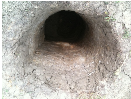
Foto 2.1 Perforación Manual, profundidad 3,50m
