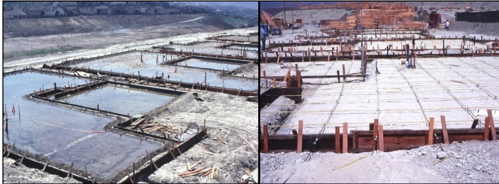
Foto 1.8. Saturación del suelo expansivo, para la construcción de losas
