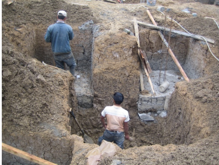
Foto 4.1 Zapatas cimentadas bajo la capa activa
