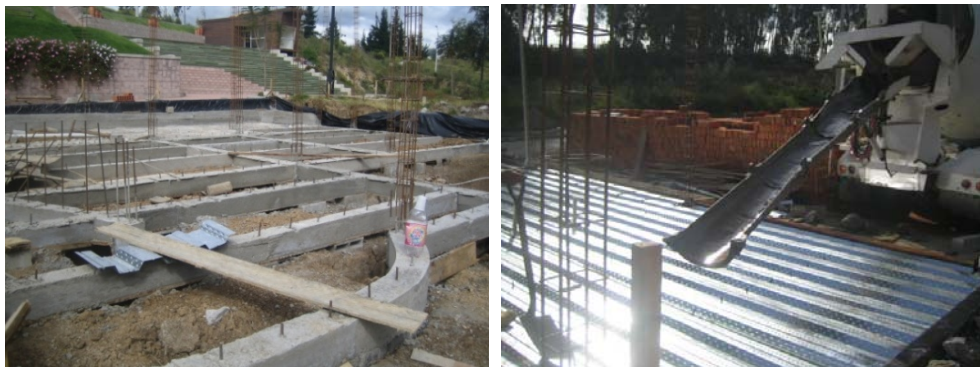
Foto 4.2 Losa Estructural con nova losa en su parte superior
