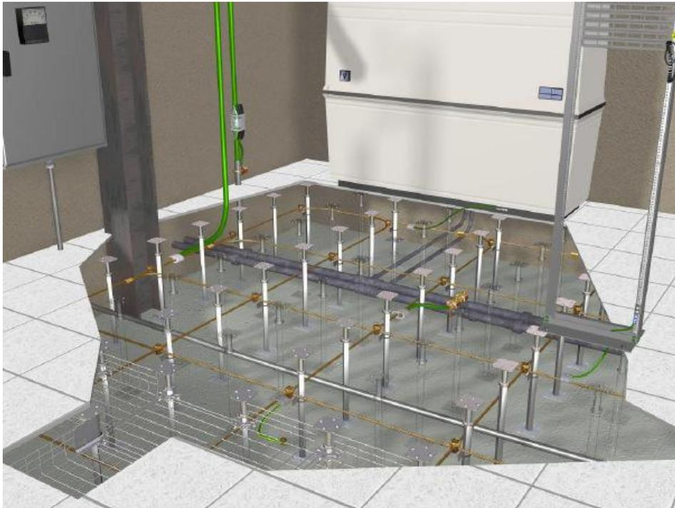
Fig. 4.8. Enlace equipotencial debajo del falso piso<sup>14</sup>
