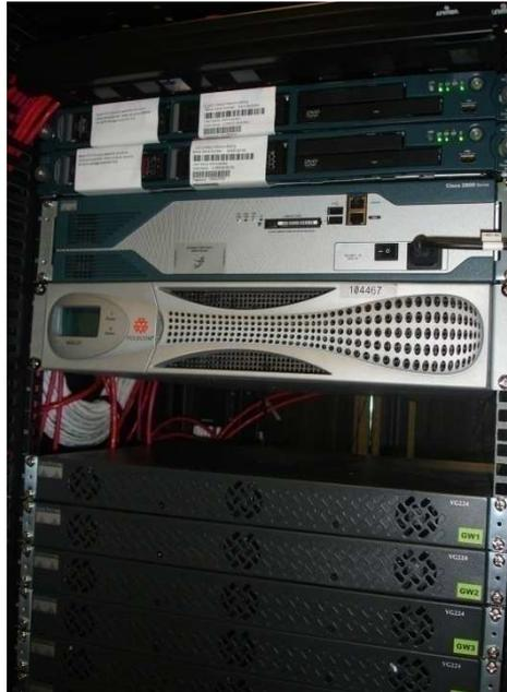
Figura 25. Central telefónica CISCO
