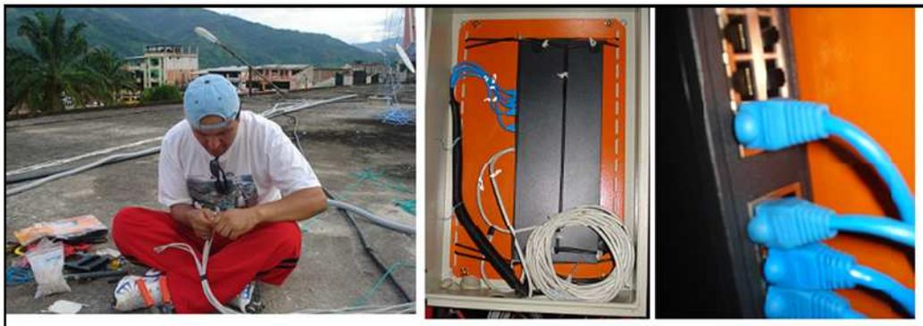
Figura: 5.17: Cableado e Instalación de switches
