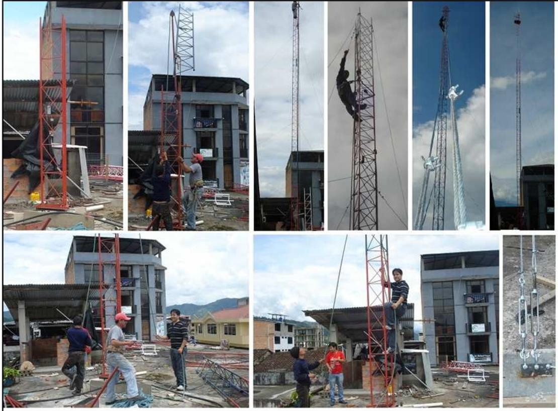
Figura: 5.15: Montaje de la torre de telecomunicaciones
