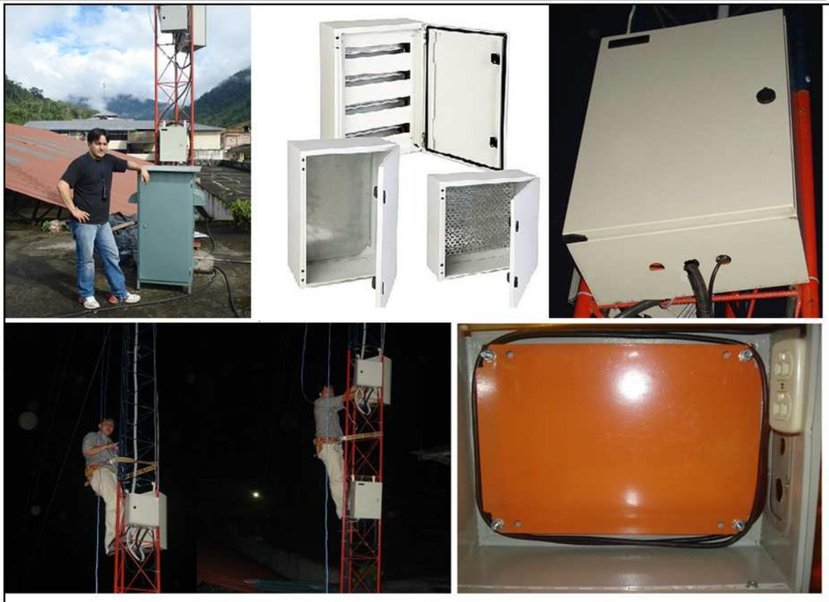
Figura: 5.16: Cajas metálicas herméticas para el albergue de los equipos
