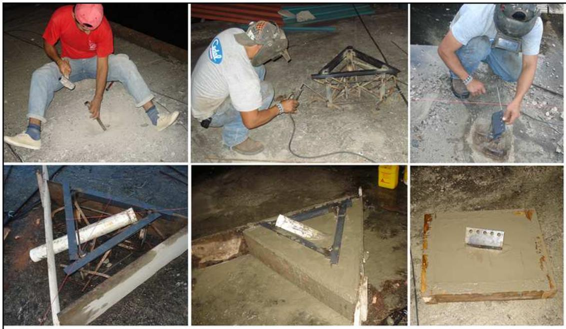
Figura: 5.14: Bases de soporte de la torre de telecomunicaciones
