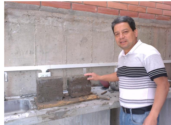
Foto N° 40 Elaboración de Muretes
