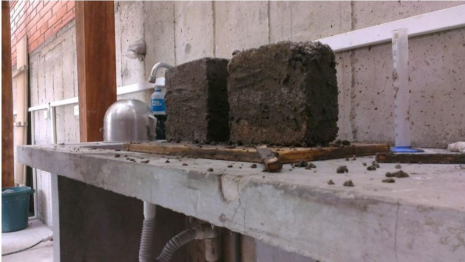
Foto N° 41 Elaboración de Muretes
