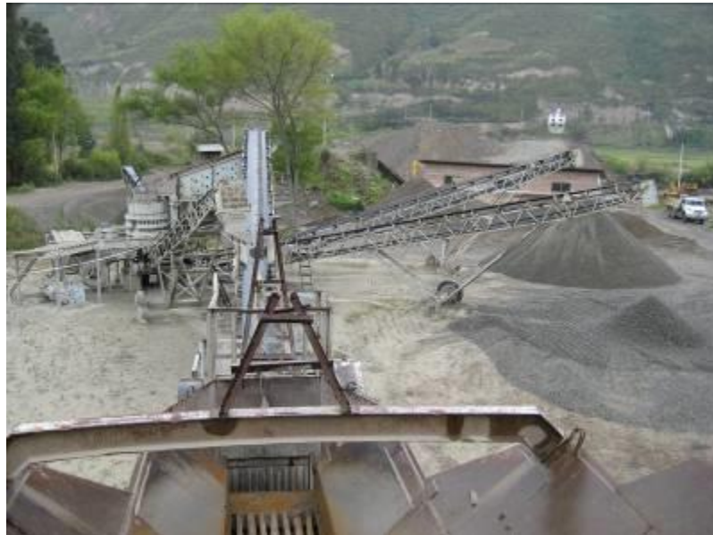
Foto 1. Área de Trituración. Fuente Autora.
