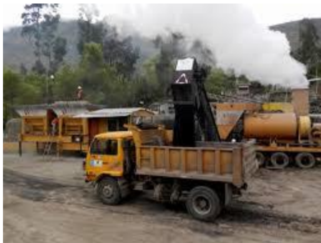
Foto 2. Planta de Hormigón Asfáltico. Fuente Autora.
