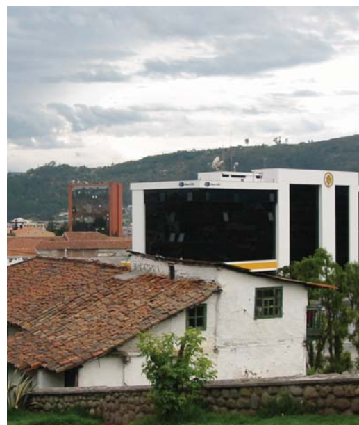
Fig. 4.7 Algunas actuaciones pueden determinar impactos importantes sobre las relaciones visuales, como se aprecia en la imagen.
