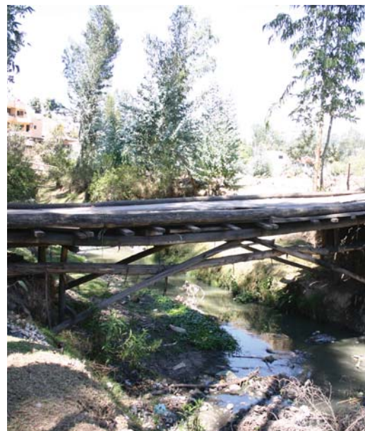
Fig. 5.24 Un sencillo puente de madera que atraviesa la quebrada de Milchichig
