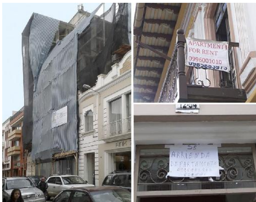
Fotografía 3.27: Edificaciones en remodelación y desocupado.
