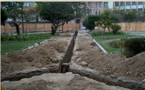
Fotografía N° 2.84 Zanjas para colocar tubería de circulación del agua de escorrentía
