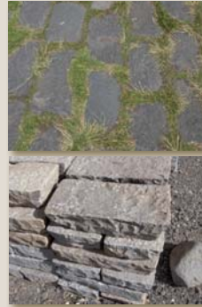
Fotografía N° 4.82, 4.83 Av. Huayna Cápac y Av. España, parterre central con piso de piedra labrada, colocada sobre suelo del lugar compactado, adoquines de piedra andesita, elaborados manualmente.
