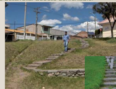
Fotografía N° 4.55 Gradas cómodas utiliza piedra andesita labrada, sobre suelo compactado, el Kikuyo rodea las gradas, el espacio permite desarrollar acceso confortable.
