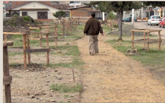
Fotografía N° 4.74, 4.75 Relleno y compactación de material de mejoramiento, acabado con lastre cernido
