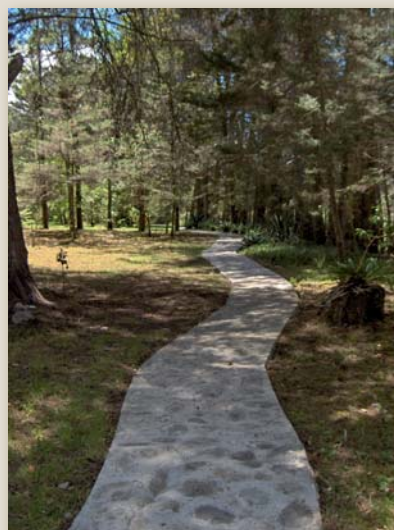
4U Fotografía N° 2.34 y N° 2.35, Parque Jipiro, caminera con lastre de las minas del Villonaco y Santiago, mezclado con arena amarilla.
