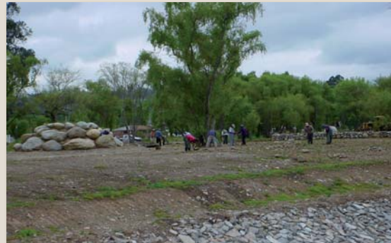
Fotografía N° 4.13, 4.14 Parque "El Paraíso", movimiento del suelo manteniendo la pendiente hacia el canal de drenaje.
