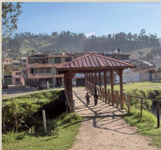
4U Fotografía N° 2.34 y N° 2.35, Parque Jipiro, caminera con lastre de las minas del Villonaco y Santiago, mezclado con arena amarilla.
