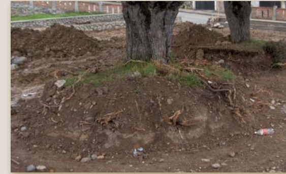
Fotografía N° 2.92, 2.93 Sustitución con hormigón y losetas de cemento
