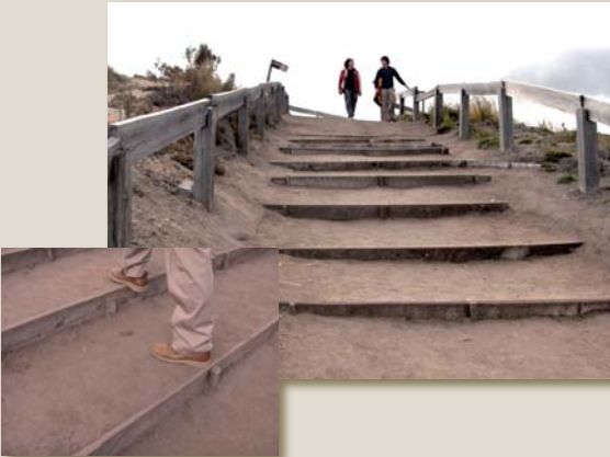
Fotografía N° 4.58 Funicular, Ciudad de Quito, gradas en tierra y madera, huella de 0.60 m., contrahuella 0.13 m.
