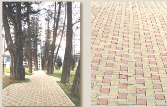
Fotografía N° 4.79, 4.80 Parque Lineal Machángara, Quito, tratamiento de superficie con piso de adocreto
