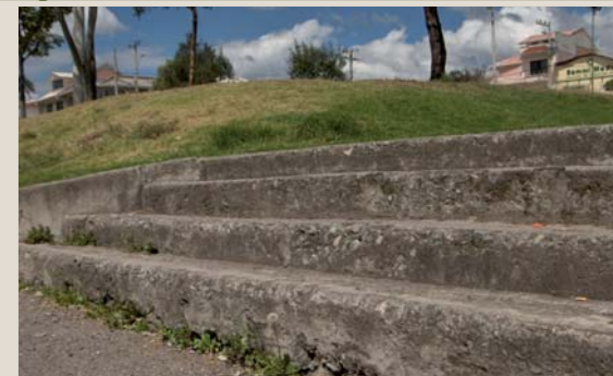
Fotografía N° 4.55 Gradas cómodas utiliza piedra andesita labrada, sobre suelo compactado, el Kikuyo rodea las gradas, el espacio permite desarrollar acceso confortable.
