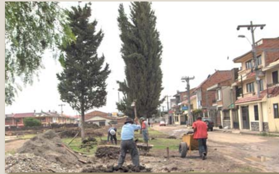
Fotografía N° 4.74, 4.75 Relleno y compactación de material de mejoramiento, acabado con lastre cernido
