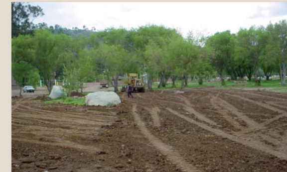
Fotografía N° 4.13, 4.14 Parque "El Paraíso", movimiento del suelo manteniendo la pendiente hacia el canal de drenaje.
