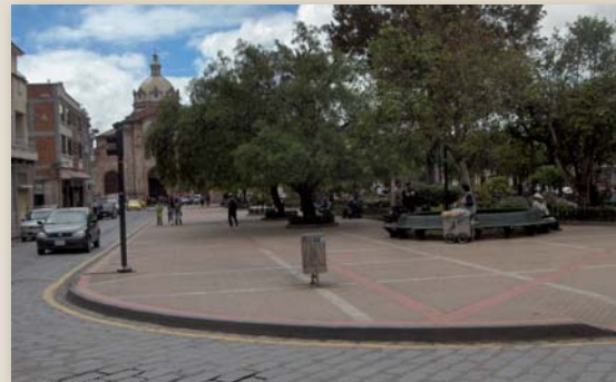
Fotografía N° 2.90, 2.91 Eliminación de la capa de suelo orgánico, destrucción de raíces, colocación de hormigón y piso duro.
