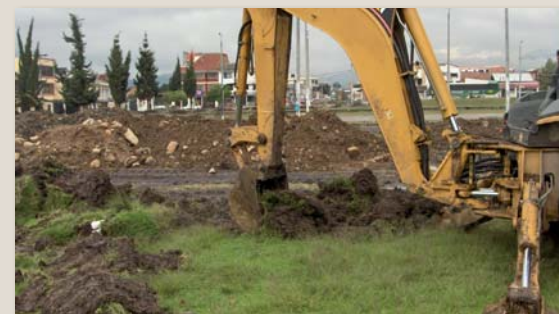
Fotografía N° 4.35, 4.36 Movimiento de la capa de suelo arable y acumulación en los costados del área deportiva.
