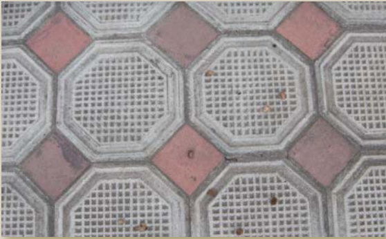
Fotografía N° 2.83 Sustitución con porcelanato
