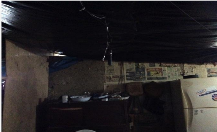
Fig. 175 Vista de cielo raso de plástico.
