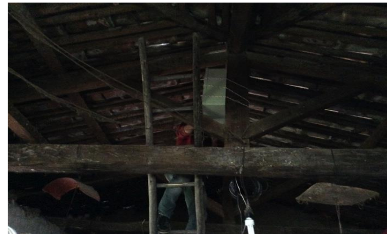
Fig. 142 Vista interior de estructura de cubierta . Fuente: Investigador
