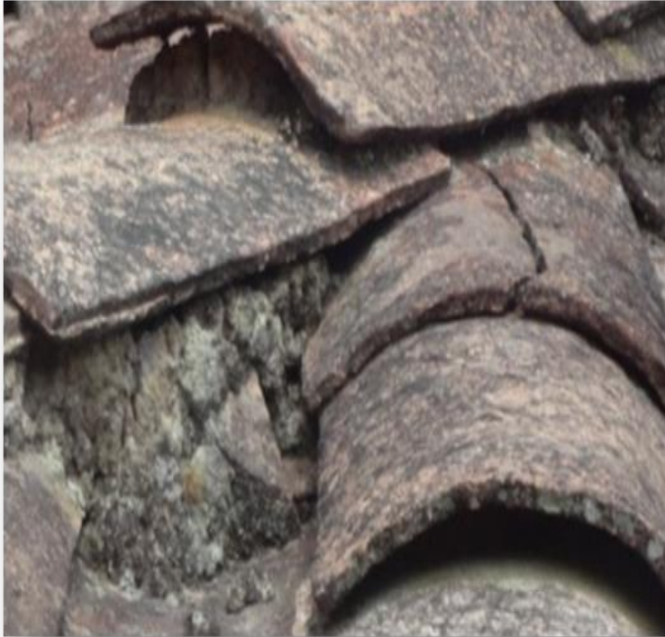
Fig. 174 Vista de teja artesanal colocado sobre cubierta. Fuente: Investigador
