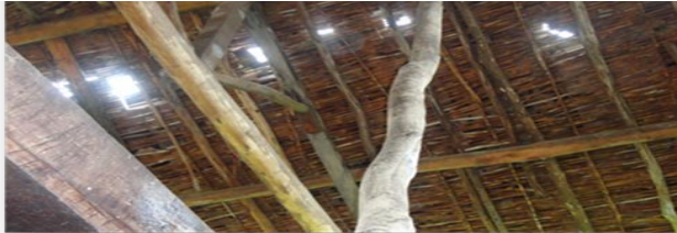
Fig. 90 Entramado de la cubierta Fuente: Investigador
