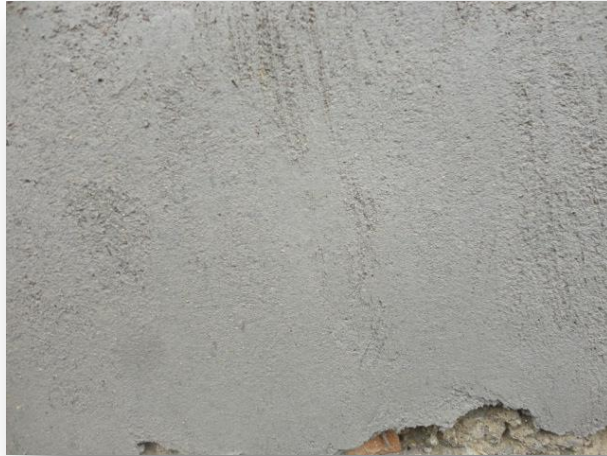
Fig. 282 MUESTRA DE REVOQUE FINO CON TIERRA ARENA Y CEMENTO. FUENTE: INVESTIGADOR
