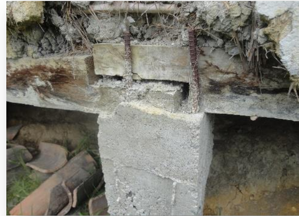
Fig. 60 Basas de hormigón armado. Fuente: Investigador
