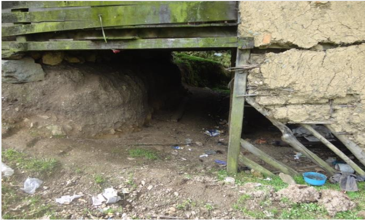
Fig. 153 Cimentación mixta. Piedra, mampostería de tierra, y pilares de madera. Fuente Investigador
