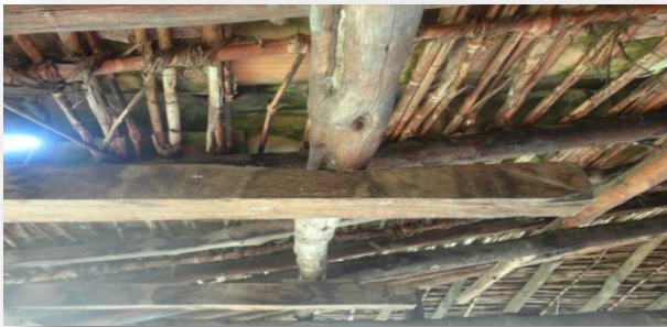
Fig. 91 Estructura de alero, barras y caimán. Fuente: Investigador
