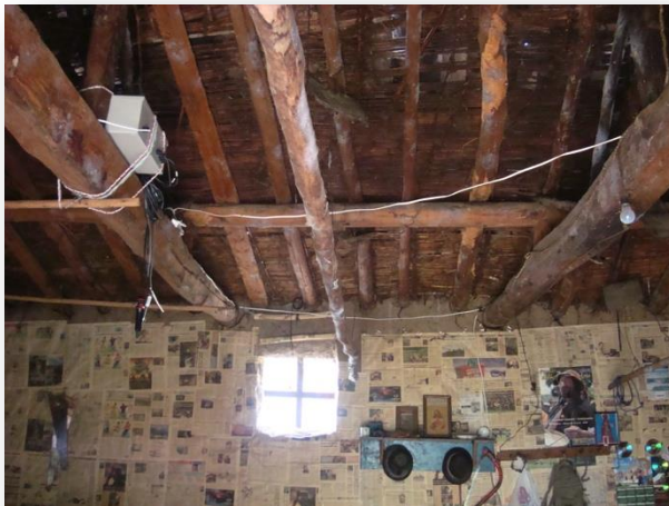
Fig. 206 sala sin recubrimiento en cielo raso Comunidad de Lagunas. Fuente: Investigador
