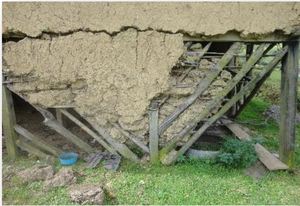
Fig. 65 Pilares sobre basas. Fuente: Investigador
