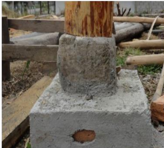
Fig. 155 Fig. 156 Basa de hormigón y piedra labrada. Saraguro Fuente: Investigador
