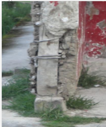
Fig. 8 Vista de perfil de pared de bahareque de Galluchaqui. Fuente: Investigador 2013
