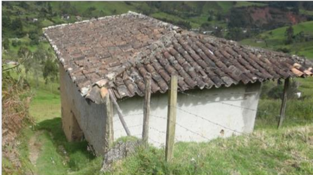
Fig. 84 Cubierta a 4 aguas Fuente: Investigador
