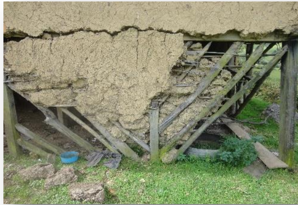
Fig. 66 Pilares sobre basas. Fuente: Investigador
