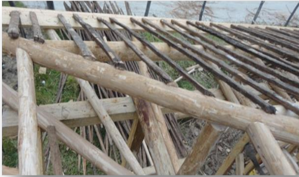
Fig. 94 Entramado de chota en cubierta. Fuente: Investigador
