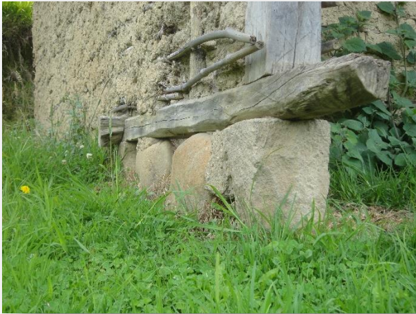
Fig. 62 Cimentación de vivienda en galluchaqui. Fuente: Investigador
