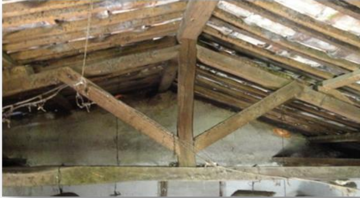
Fig. 169 Sistema de cerchas en cubierta. Fuente: Investigador
