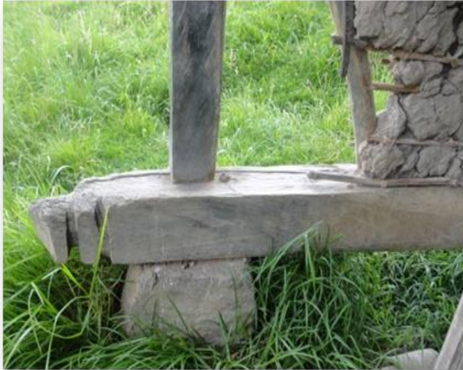
Fig. 148 Cementación sobre basas de piedra. Casa de Polivio Paqui. Fuente: Investigador
