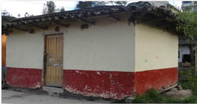
Fig. 162 Vivienda recubierta con mortero de cemento. Fuente Investigador
