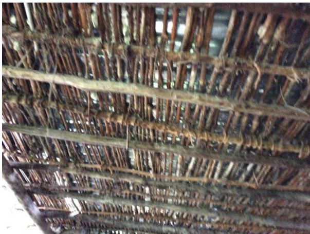
Fig. 144 Entramado de barra y chinchá para soportar la teja. Fuente Investigador
