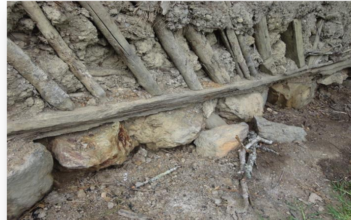
Fig. 152 Cimentación sobre. Piedra. Fuente Investigador
