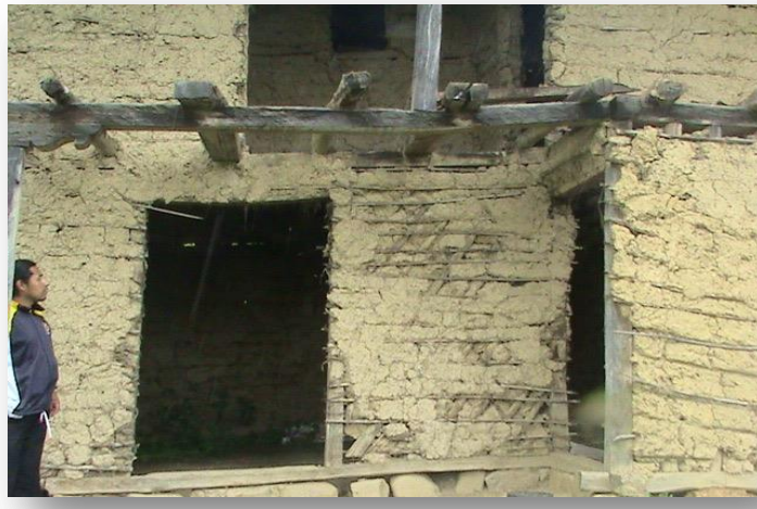
Fig. 163 Espesor de revestimiento. Fuente: Investigador
