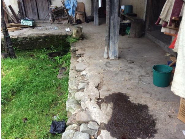
Fig. 128 basa de piedra, soportando pilar . Fuente Investigador
