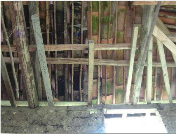
Fig. 92 Vista interior de entramado de chota en cubierta. Fuente: Investigador
