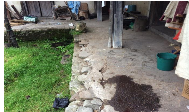
Fig. 132 Recubrimiento con mortero de cemento. Portal de acceso. Fuente: Investigador
