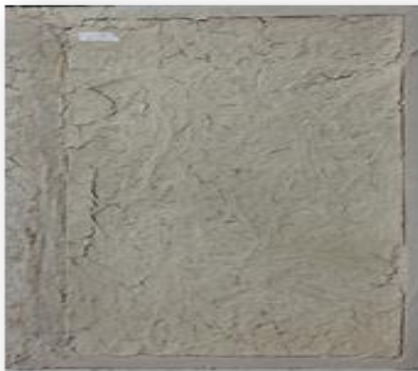
Fig. 281 Relleno estabilizado con cemento a los 20 días Fuente: Investigador
