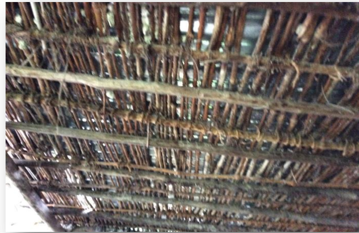
Fig. 218 Detalle de entramado de cubierta. Fuente: Investigador
