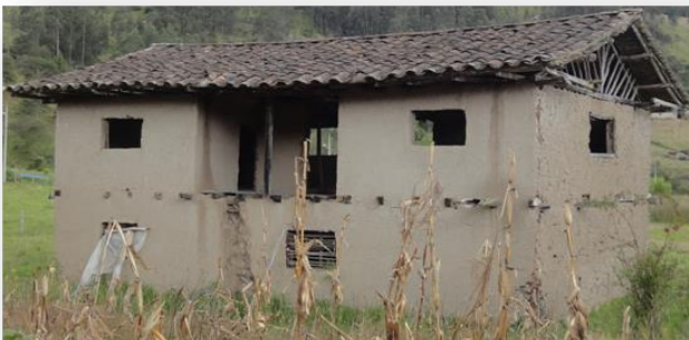
Fig. 87 Cubierta a dos aguas Fuente: Investigador
